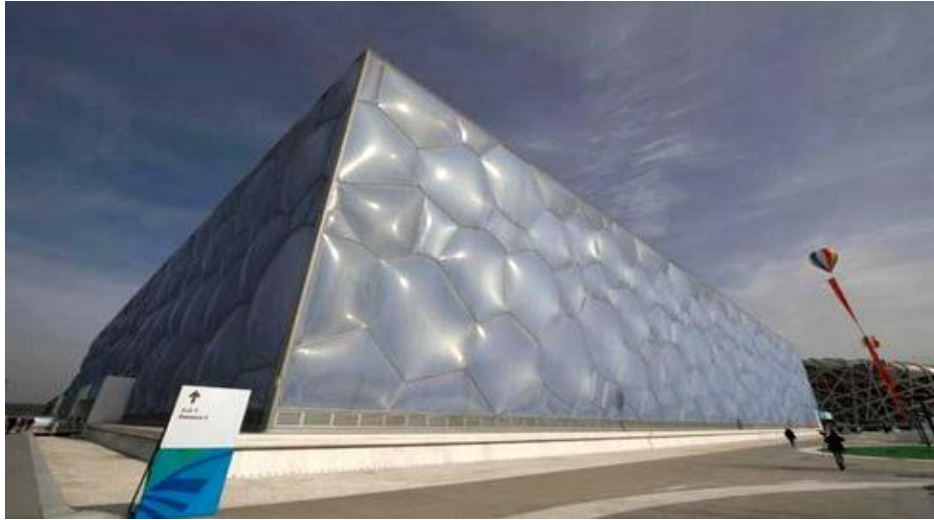
řekil 2.12 Etf e cephe kaplaması (en.beijing2008.cn)
