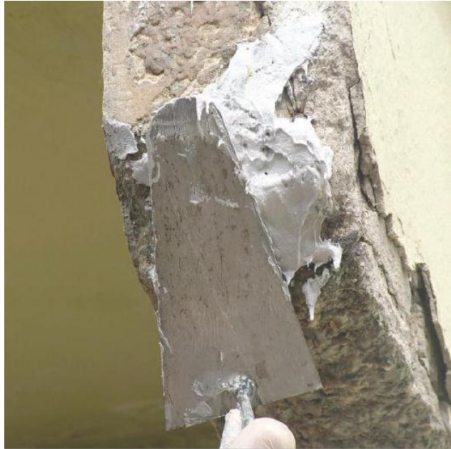
Şekil 3.6 Segregasyona uğramış yüzeyin harç ile tamir edilmesi (Ercan 2010)
