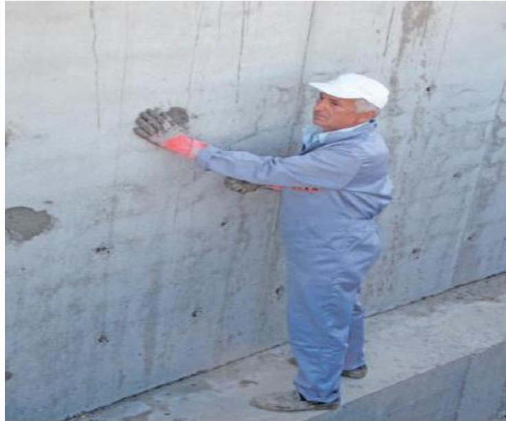
Şekil 3.8 Tij deliklerinin tamir harcı ile doldurulması (Ercan 2010)
