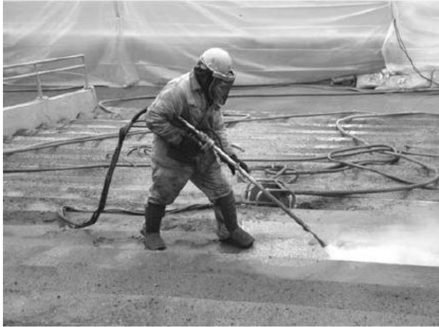
Şekil 3.5 Yüksek basınçlı veya çok yüksek basınçlı su ile temizleme (Ercan 2010)
