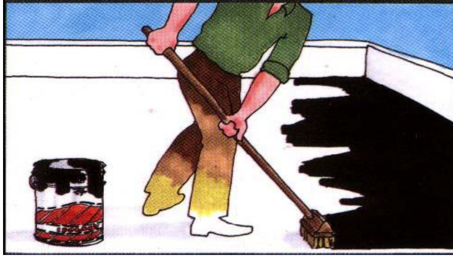
Şekil 3.24 Bitüm esaslı malzemeler ile su yalıtım uygulanması(Akyol, 2008)
