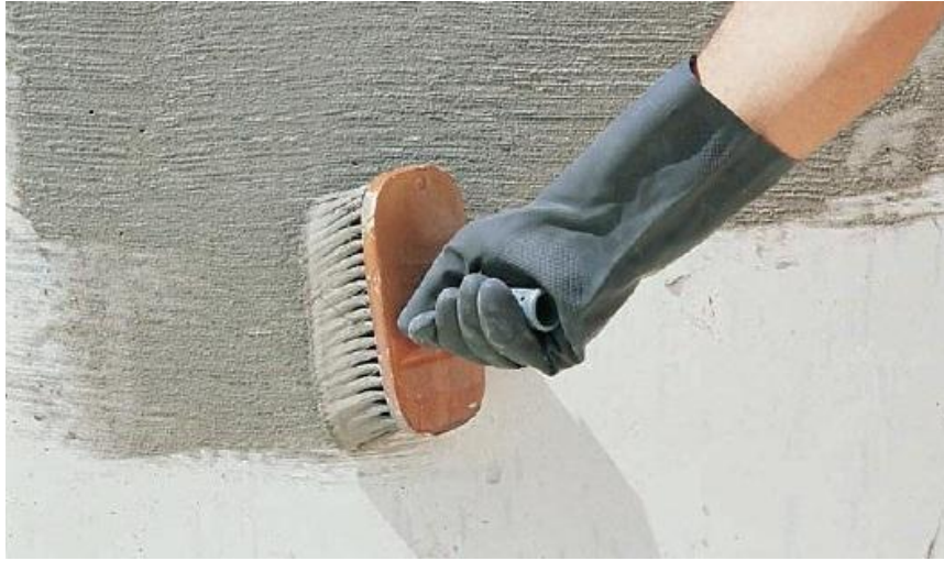
Şekil 3.17 Çimento esaslı su yalıtım malzemesi uygulaması (Ercan,2010)
