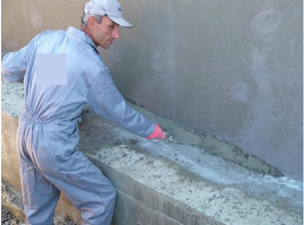
Şekil 3.4 Tamir harcı ile pahlama(Ercan 2010)
