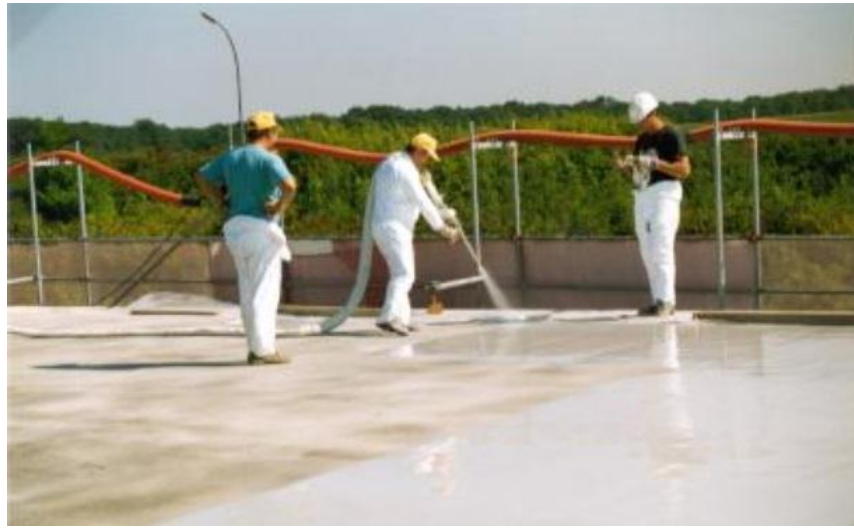
Şekil 3.28 Poliüretan esaslı su yalıtım malzemesi uygulaması(Cem Ercan,2010)
