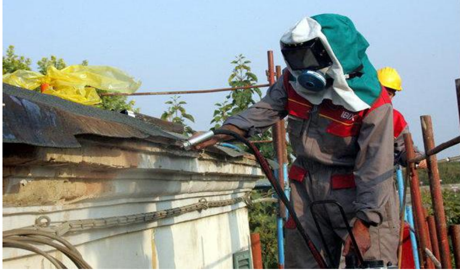
Şekil 3.7 Aderansı düşük yüzeyi kumlama ile pürüzlendirme(Ercan 2010)
