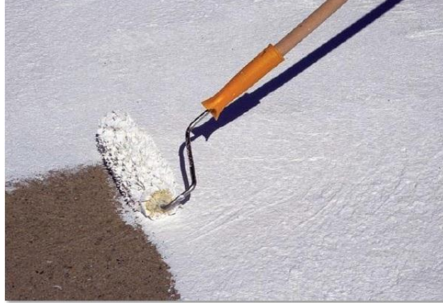
Şekil 3.30 Akrilik esaslı su yalıtım malzemesi uygulaması (Ercan,2010)
