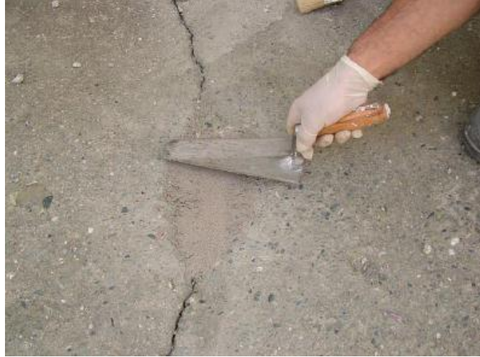
Şekil 3.1 Yapısal olmayan çatlak tamiri (Ercan , 2010)
