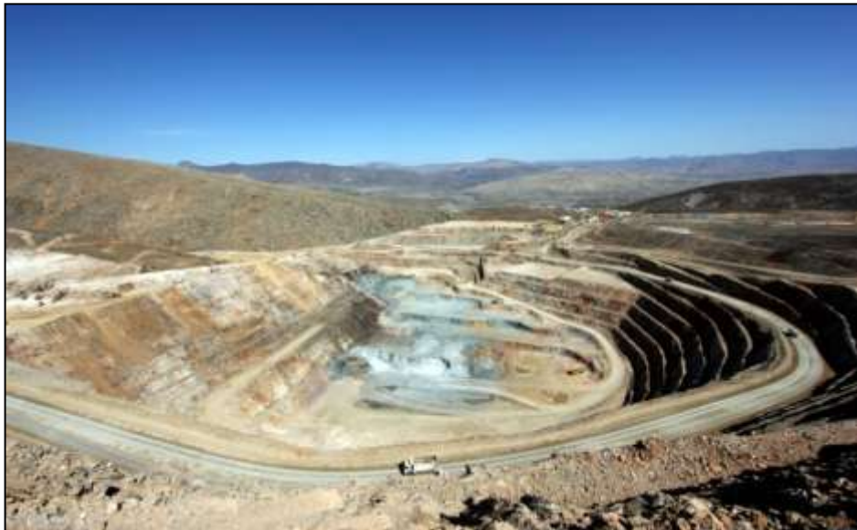
Şekil 2.3 Çöpler manganez açık ocağının genel görünümü.
