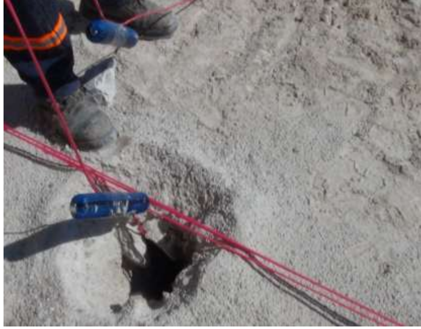
Şekil 3.16 Önkesme patlatmasında patlayıcı fitile bağlanan dinamitin deliğe yerleştirilmesi.
