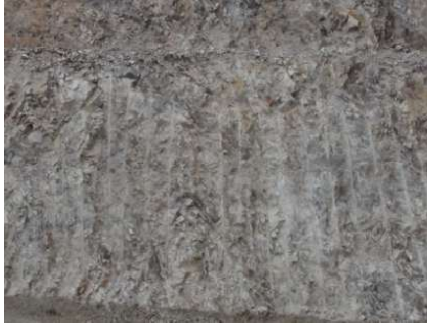
Şekil 3.17 Basamak şevinde patlatma sonrası görülen önkesme izleri.
