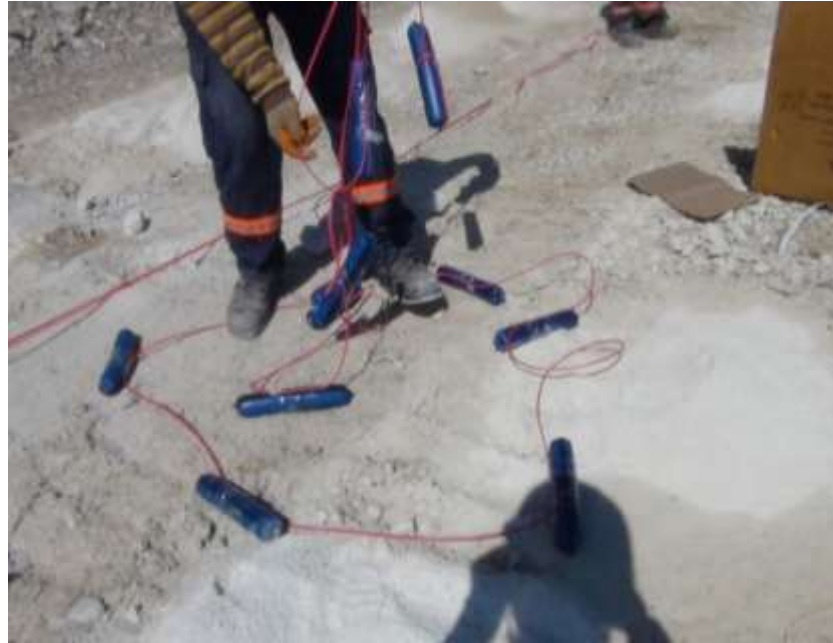
Şekil 3.15 Önkesme patlatmasında dinamit ve patlayıcı fitilin hazırlanması.
