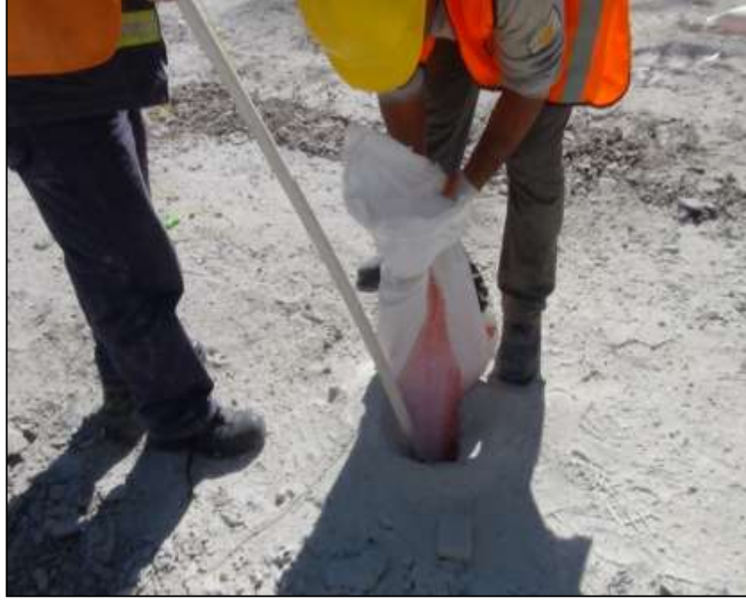
Şekil 3.12 Patlatma deliğinin doldurulması.
