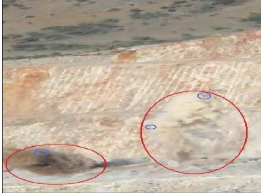
Şekil 4.6 Sahada yapılan patlatmalar sırasında taş savrulması (Bilgin, 2010).
