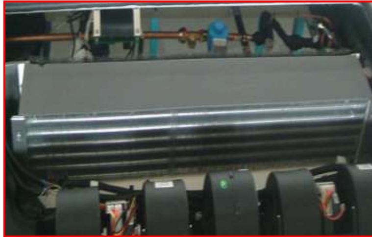
Şekil 2.11 Evaporatör ve radyal fan yerleşimi
