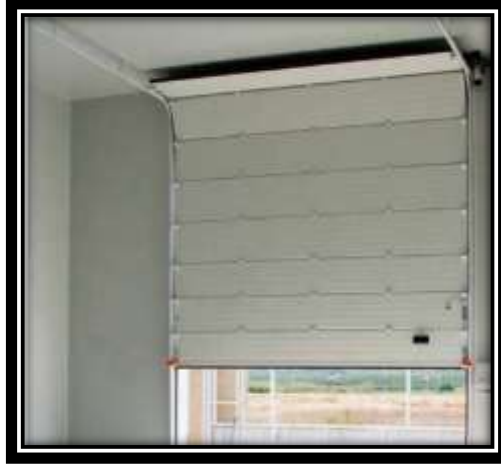
Şekil 5.2 Test odası araç giriş kapısı
