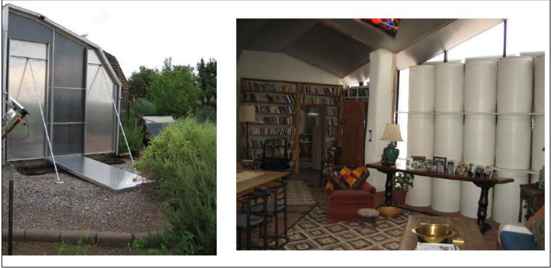
Şekil 3.40 Su duvarı olarak bidonların 1991’de konut örneğinde kullanılması (Bear, 2009)
