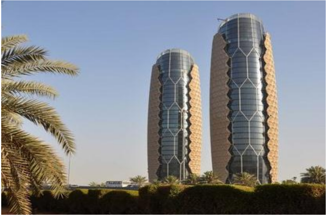
Şekil 3.13 Al Bahar Kulesi'nde güneş kırıcı kullanımı (Al Bahar Towers Responsive Facade / Aedas, 2012)
