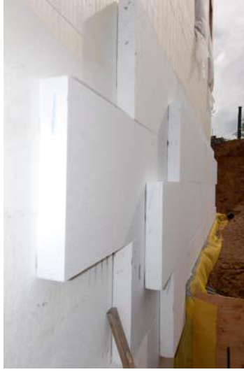
Şekil 4.9 ICF'nin Konkol Residence'de kullanımı (This is the Passive House in the Woods, bt)
