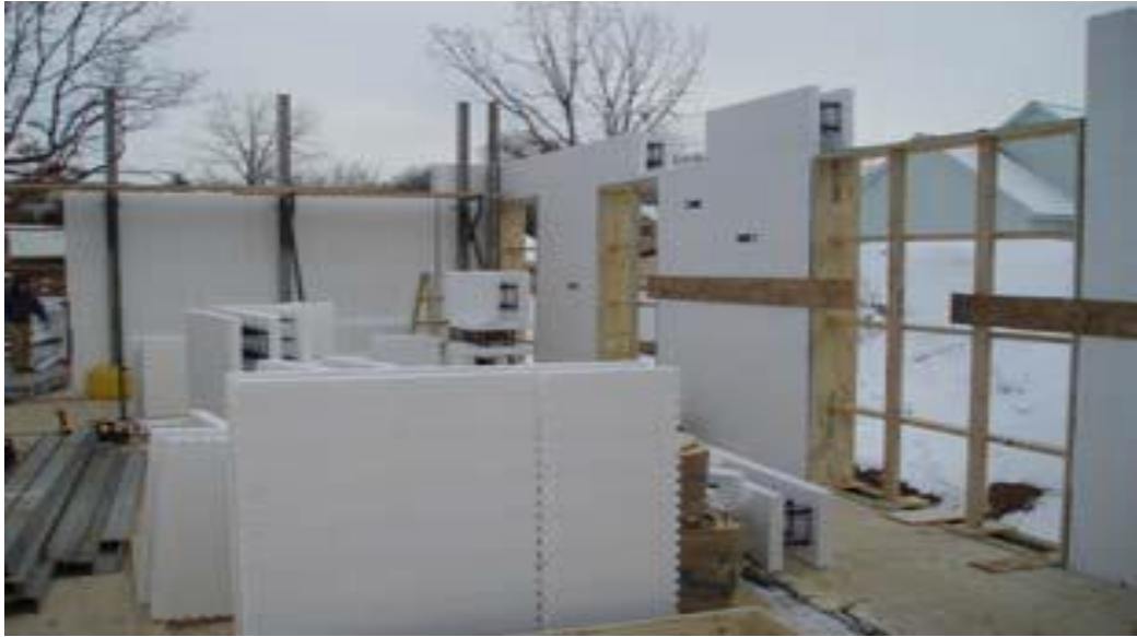
Şekil 4.8 Konkol Residence uygulama aşaması (This is the Passive House in the Woods, bt)
