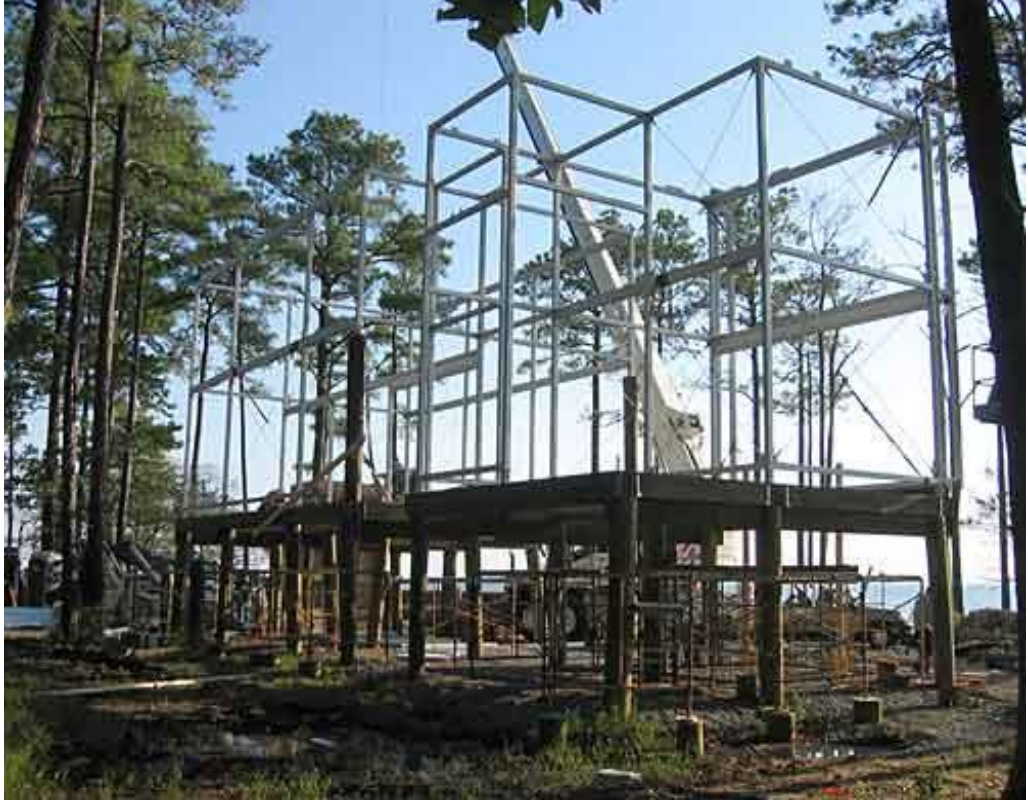
Şekil 4.27 Alüminyum iskele inşaatı (Pearson, bt)
