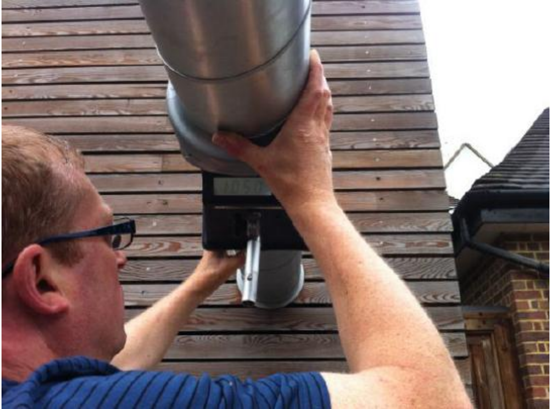
Şekil 4.77 Yapıda yapılan havalandırma ölçümleri (Camden Passivhaus, bt)
