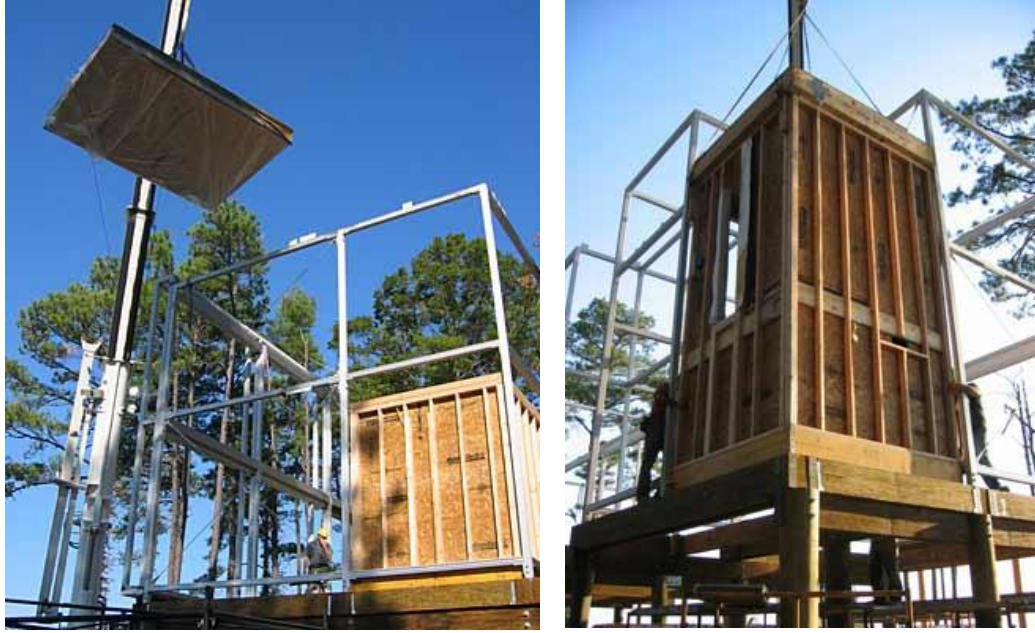
Şekil 4.28 Loblolly House yapım aşaması (Pearson, bt)
