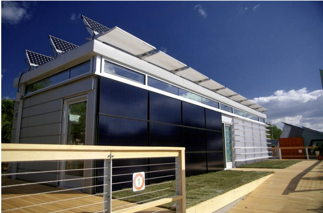
Şekil 3.4 ICARUS Binası'nda aerojel kullanımı (GT Solar Decathlon House, bt)
