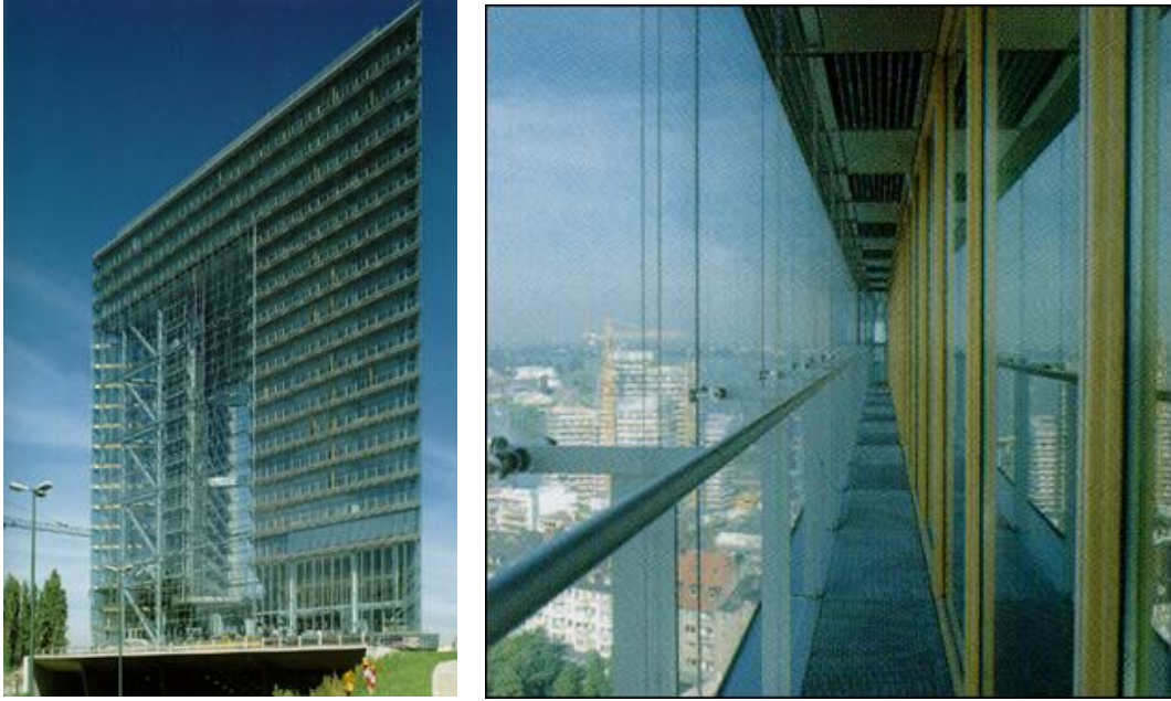
Şekil 3.27 Düsseldorf City Gate Binası'nda çift cephe uygulaması (Düsseldorf Stadttor (City Gate), bt)
