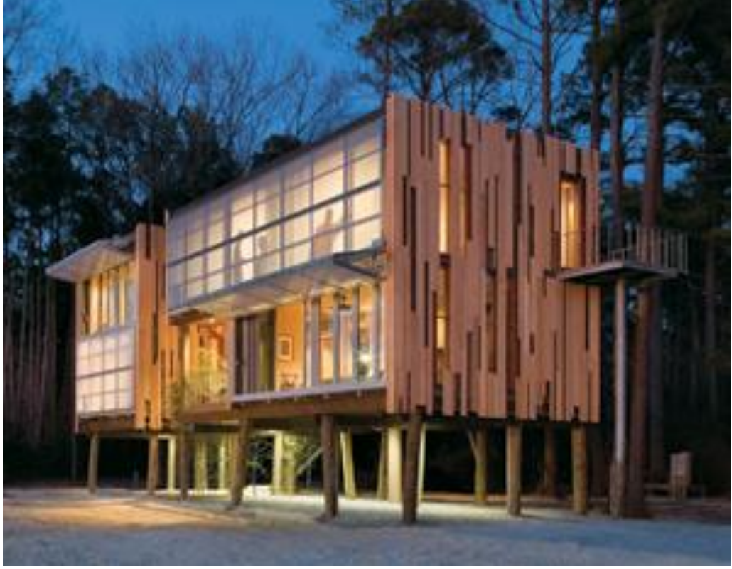
Şekil 4.25 Loblolly House dış görünüşü (KieranTimberlake Associates, bt )
