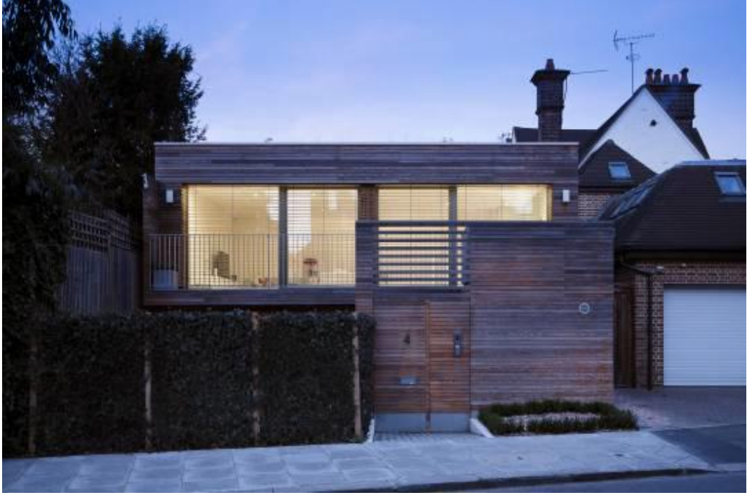
Şekil 4.68 Camden Passivehaus Ön Görünüş (Camden Passivhaus – London’s first certified Passivhaus, bt)
