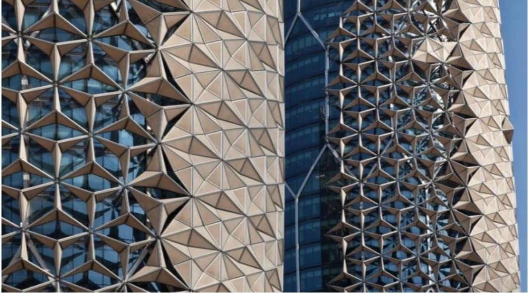
Şekil 3.14 Al Bahar Kulesi’nde güneş kırıcı kullanımı (Indosky, 2014)
