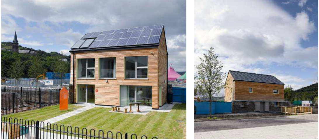
Şekil 4.66 The Larch House güney ve kuzey cephesi (Denby Dale Case Study, bt)
