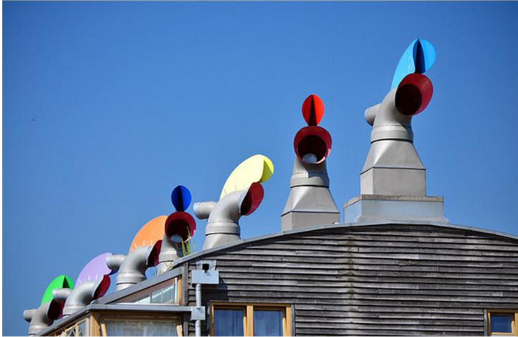
Şekil 3.21 Bedzed Konutları'nda kullanılan rüzgar kepçeleri ( flicker, bt )
