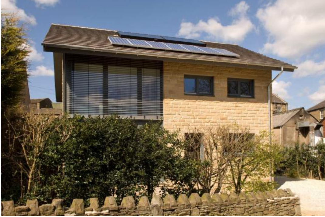
Şekil 4.47 Denby Dale House dış görünüş (Denby Dale Passivhaus, bt)
