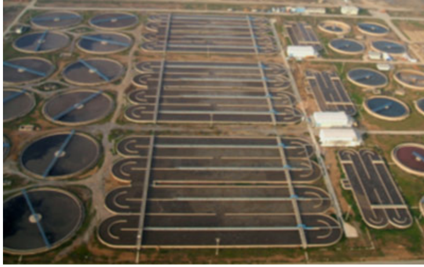
Şekil 1.4Çiğli atık su arıtma tesisinin havadan görünümü(Anonim, 2013b)
