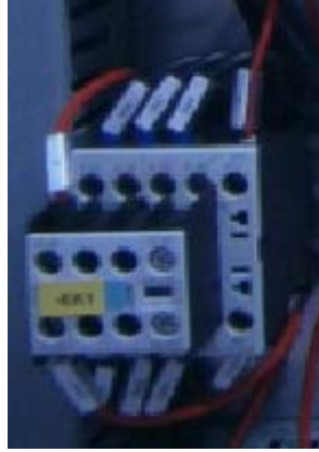
Şekil 5.11 Kontaktör ve yardımcı kontaktör birlikte
