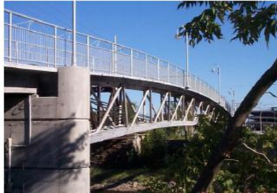
Şekil 1.3 Sherbrooke yaya köprüsü – Kanada (Blais ve Couture , 1999).
