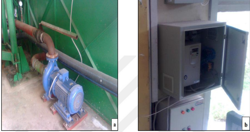
Şekil 3.4 a) Pompa, b) hız kontrol cihazı
