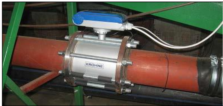
Şekil 3.5 Elektromanyetik debimetre
