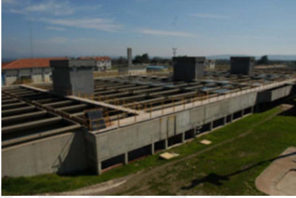
Şekil 4.5 Tahtalı Barajı durultucu havuzları
