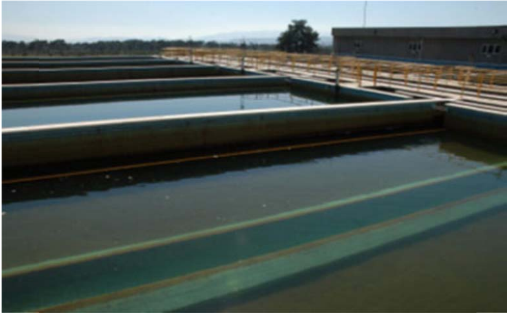
Şekil 4.6 Tahtalı barajı filtre havuzları
