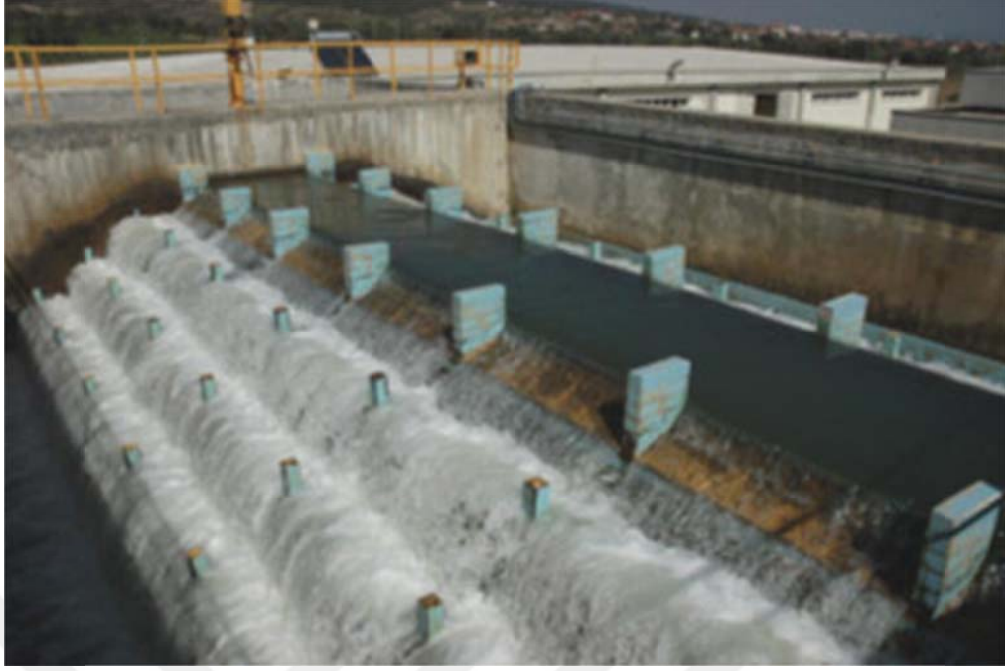
Şekil 4.4 Tahtalı Barajı havalandırma kaskatları
