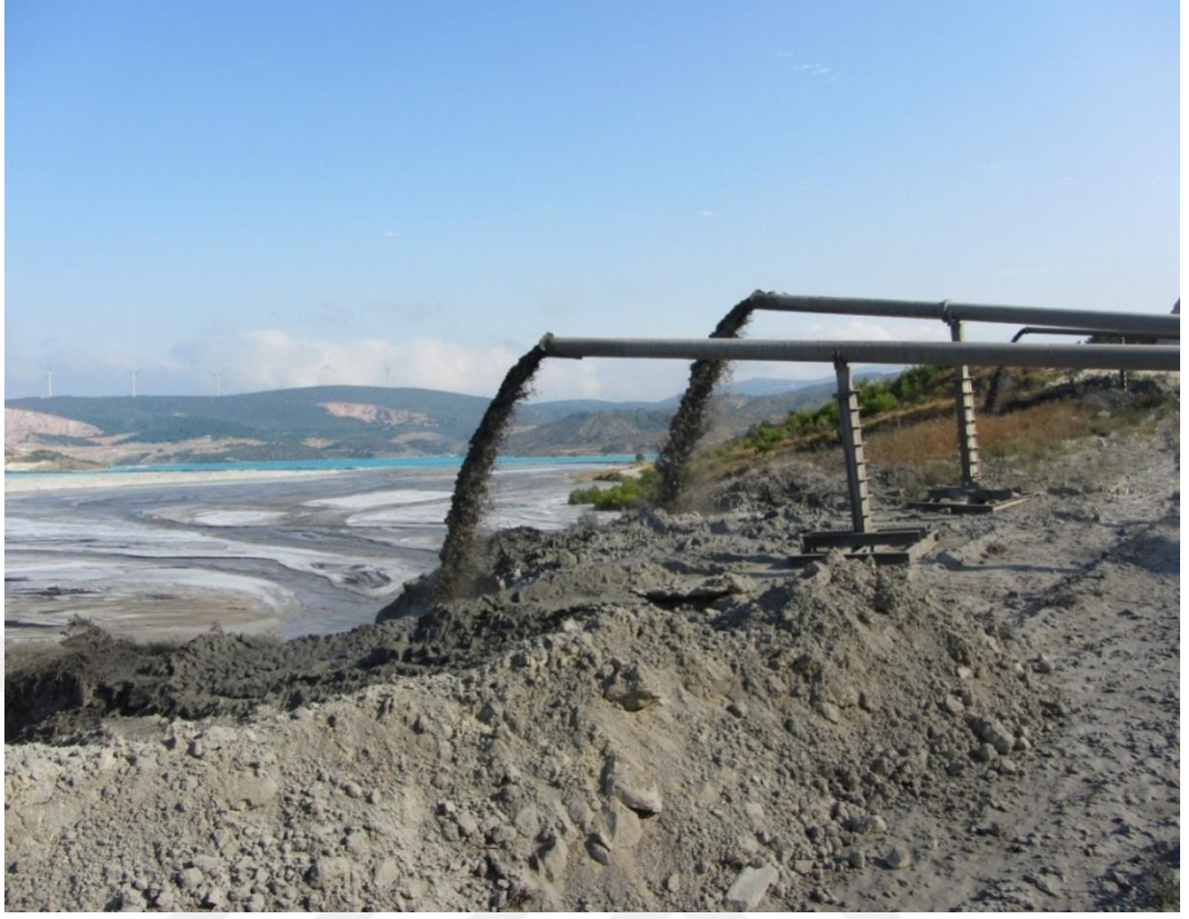
Şekil 3.16 Ayıtlı Kül Barajı
