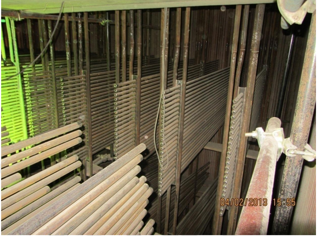
Şekil 3.7 Kazan boru donanımı
