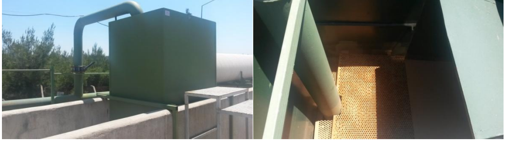
Şekil 4.2 Devede boynu boru ile giriş ve sakinleştirici plakalar
