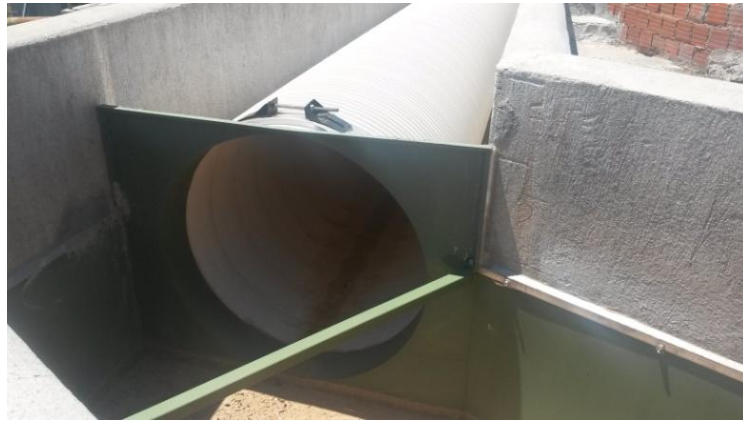
Şekil 4.4 Tahliye kanalı girişi
