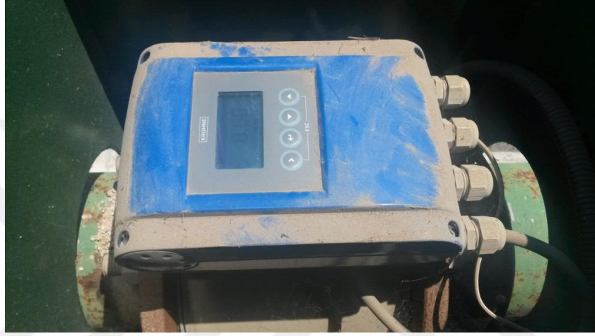
Şekil 4.3 Elektromanyetik debimetre
