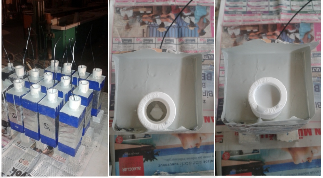
Şekil 6.24 Epoksi ile donatı uçlarını kaplama işlemi.
