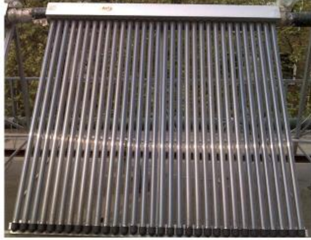
Őekil 2.4 Vakum tñplerin toplayıcıya bađlanmış hali (Li ve ark., 2010)
