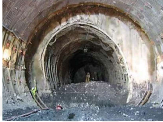
Şekil 2.8 Geometrisi bozulan tüneller (Manh, 2014)
