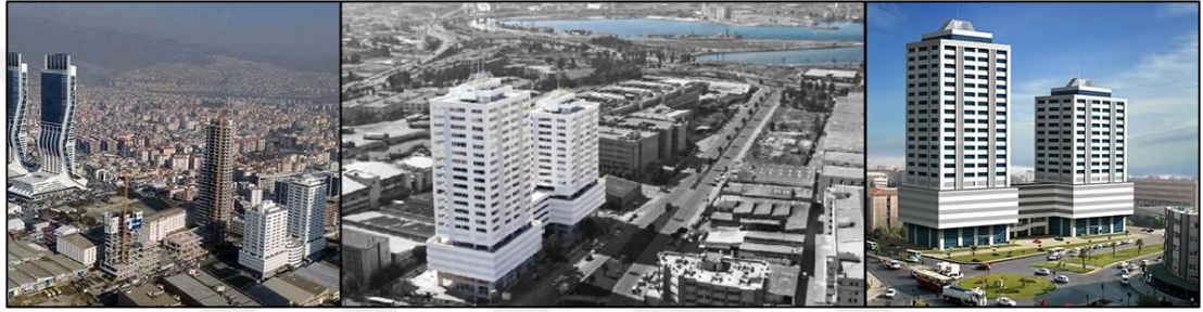
Şekil 4.22 Sunucu Plaza ve Martı Tower görünüş (Ardalı İnşaat, b.t.; Egetek Makine, 2014; Instagram, b.t. verilerinden düzenlenmiştir.)
