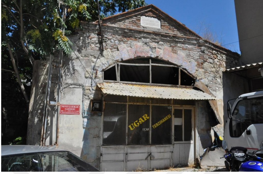
Şekil 2.47 Güneydeki sonradan dükkana dönüştürülen giriş cephesi ve üzerindeki mermer kitabe (Kişisel arşiv, 2017)
