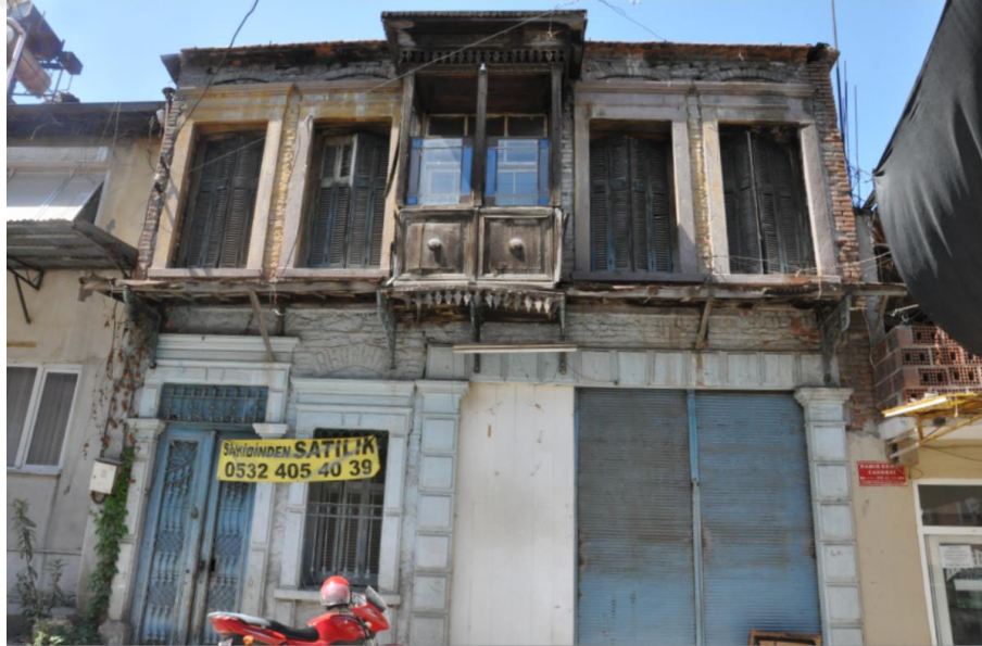
Şekil 4.67 Yapının ön cephesi (Kişisel arşiv, 2019)
