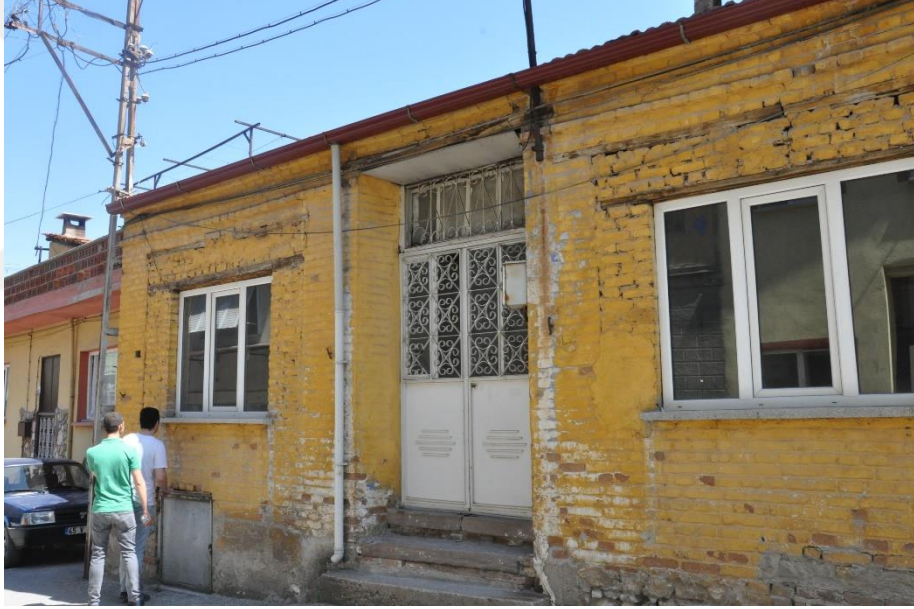
Şekil 3.13 Basit onarım gerektiren yapı örneği (Kişisel arşiv, 2017)
