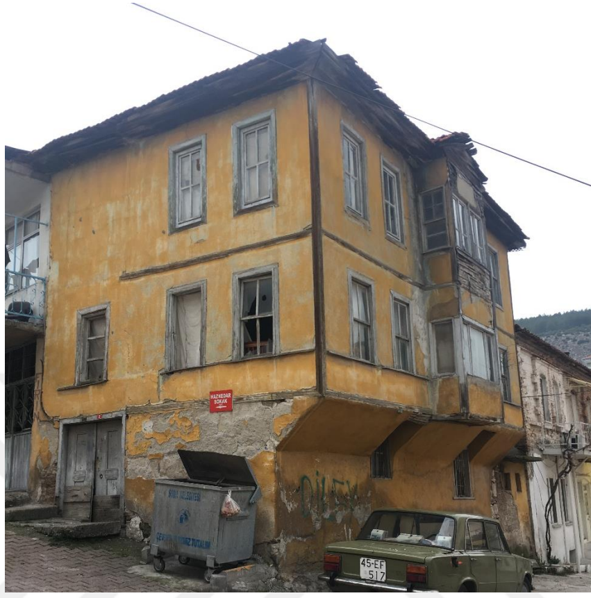
Şekil 3.19 203 Ada 9 Parseldeki özgünlüğü korunmuş tescilli yapı (Kişisel arşiv, 2019)
