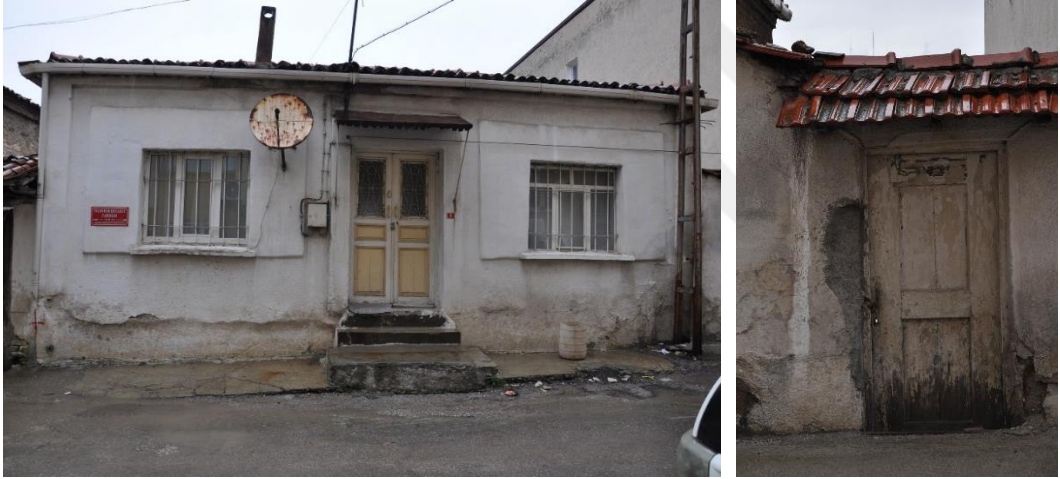
Şekil 4.95 Konutun Yıldırım Beyazıt Caddesi'nde bulunan ön cephesindeki girişleri (Sağdaki resim; konutun yanında bulunan bağımsız bahçe giriş kapısı) (Kişisel arşiv, 2019)
