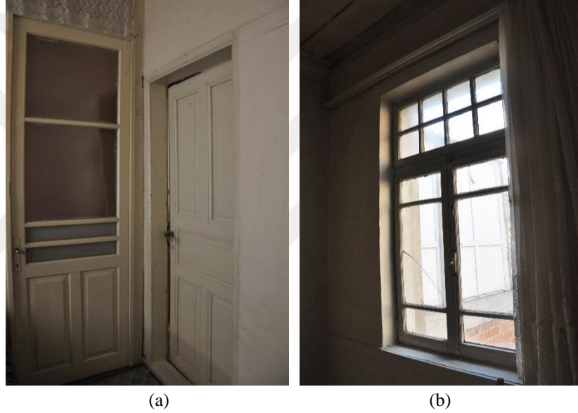
Şekil 4.91 a) Üst kat sofasında bulunan kapılar (soldaki kapı dönem eki olan odanın, sağdaki kapı 3 nolu oda kapısının resmidir), b) Yapıdaki ahşap çift kanatlı pencere örneği (Kişisel arşiv, 2019)
