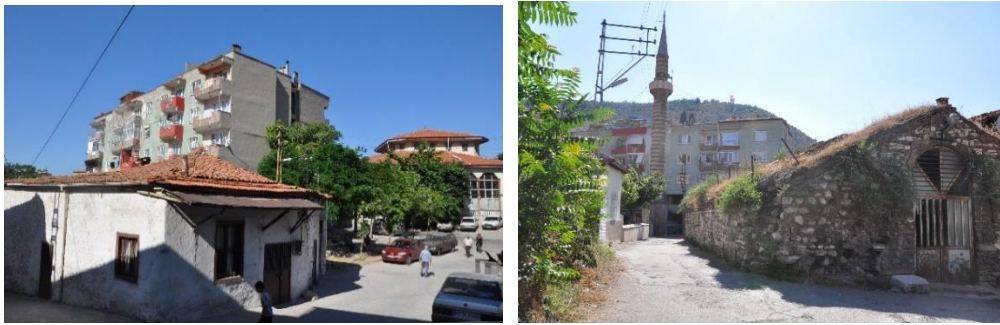
Şekil 5.16 Çarşı Camii'nin yanında (eski Çukur Han'ın yerinde) inşa edilmiş, dokunun her yerinden göze çarpan ve silueti olumsuz etkileyen 5 katlı apartman yapısı (Kişisel arşiv, 2019)
