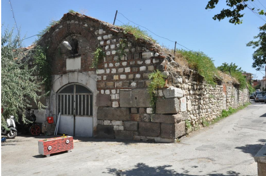
Şekil 2.31 Bedestenin batı cephesi (Kişisel arşiv, 2019)
