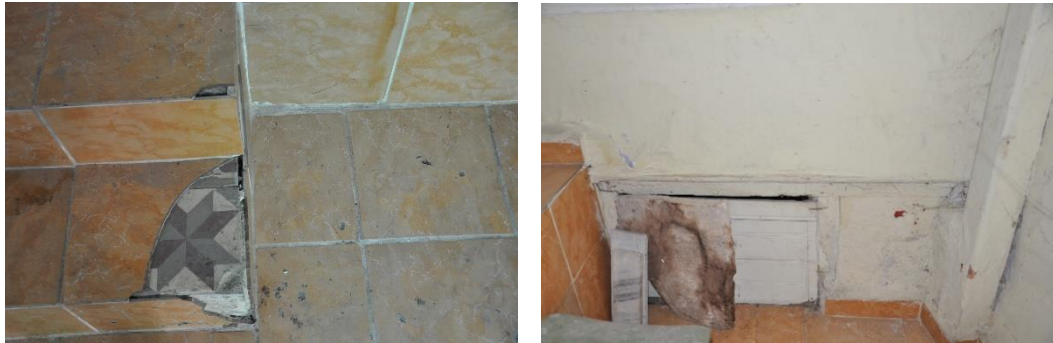
Şekil 4.10 Yapının girişinde görülen özgün karosiman döşeme ile bodrum kapısı (Kişisel arşiv, 2019)
