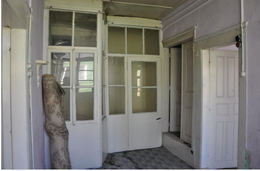
Şekil 4.15 Merdiven ile sofa arasındaki ahşap profilli cam bölme (Kişisel arşiv, 2019)
