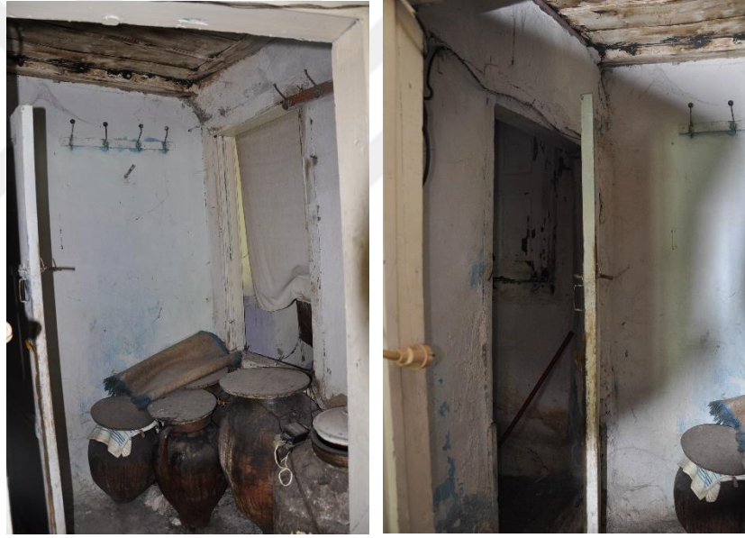
Şekil 4.9 Mutfağın doğu duvarından geçilen depo ve tuvalet birimi (Kişisel arşiv, 2019)
