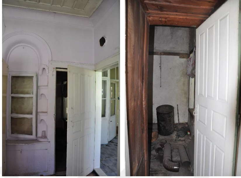
Şekil 4.22 4 nolu odadan geçilen kömürlük/depo mekanı (Kişisel arşiv, 2019)
