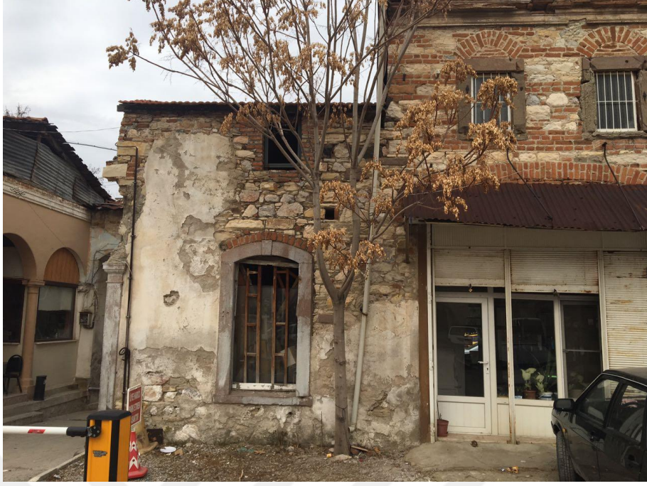
Şekil 2.45 Yapılarda görülen sıva dökülmeleri, malzeme kayıplarına bir örnek (Sol taraftaki birim, yukarıdaki metinde bahsedilen Avcılar Derneği'dir.) (Kişisel arşiv, 2019)
