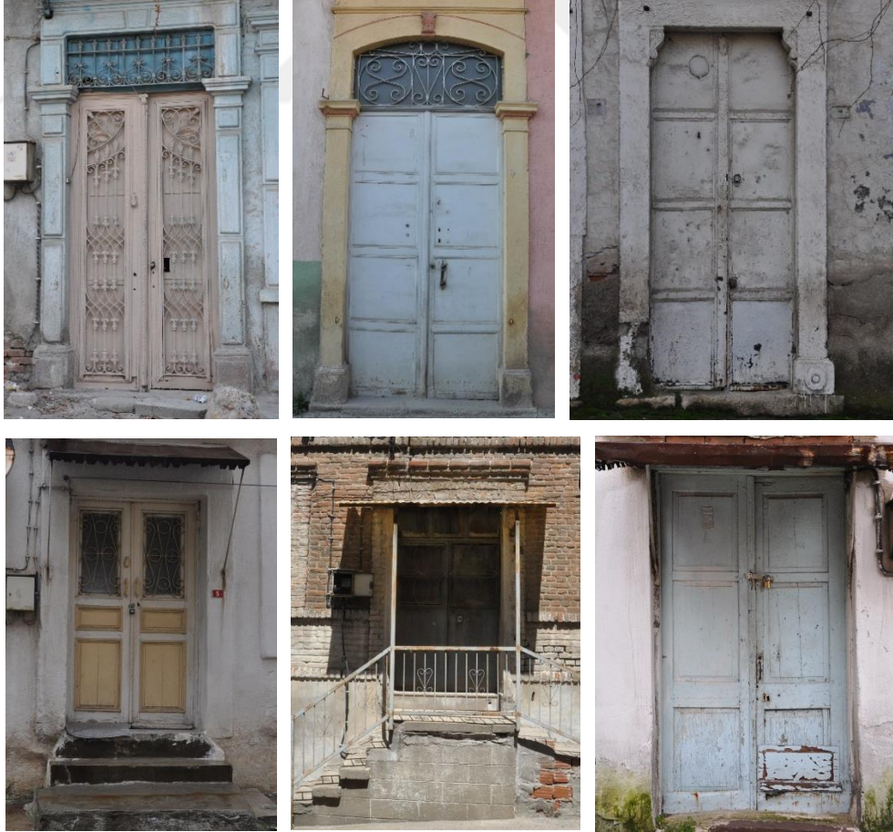
Şekil 4.104 Rum konutlarında görülen kapılar ve giriş tiplerinden bazıları (Kişisel arşiv, 2019)
