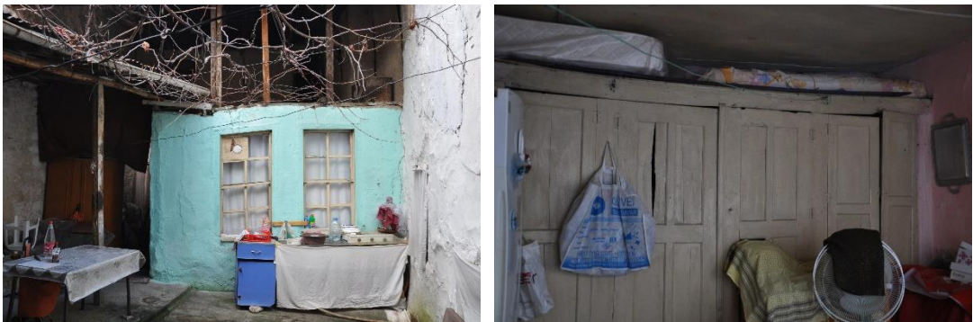
Şekil 4.44 Avluda bulunan 1 nolu odanın dışarıdan ve içeriden görünümü (Kişisel arşiv, 2019)
