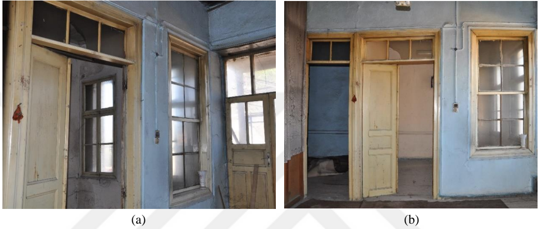
Şekil 4.80 a) 2 nolu odanın giriş kapısı ve 1 nolu odaya bakan iç penceresi, b) 2 nolu odanın yanından girilen dar girişe sahip 3 nolu odanın görünümü (Kişisel arşiv, 2019)
