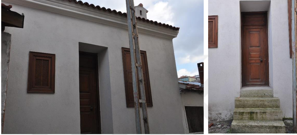
Şekil 4.52 Yapının Namık Kemal Caddesi’nden (batı cephesi) olan girişi (Kişisel arşiv, 2019)
