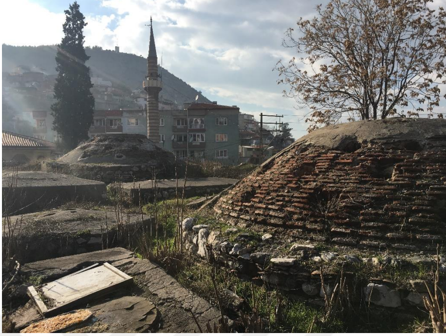
Şekil 2.39 Hamamın çatısından bir görünüm (Kadınlar ve erkeklerin sıcaklık bölümünün kubbeleri) (Kişisel arşiv, 2017)
