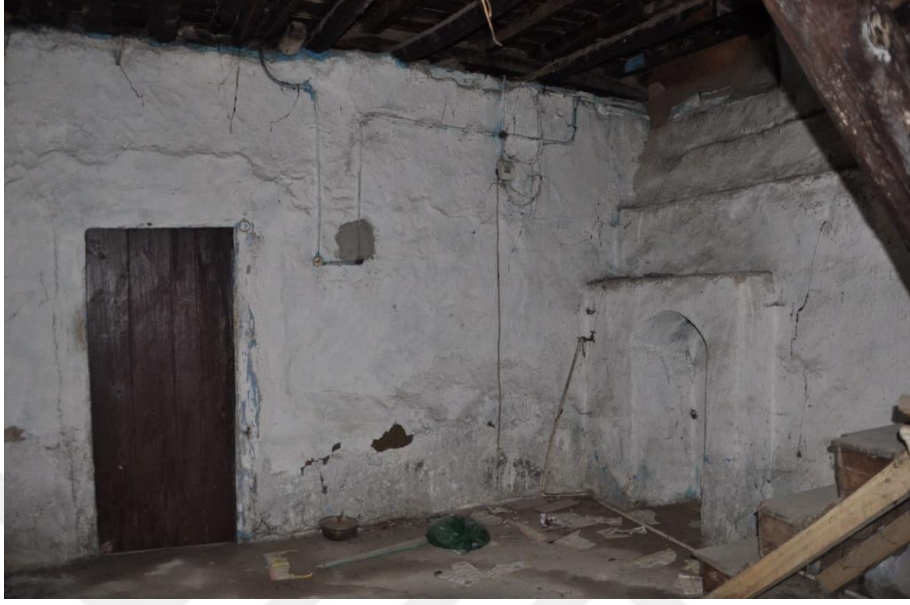
Şekil 4.28 Zemin kattaki giriş mekanının resmi (Kişisel arşiv, 2019)
