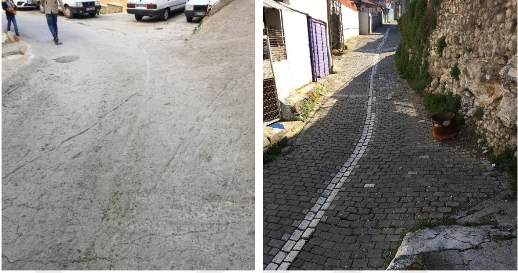
Şekil 3.35 Asfalt ile parke taşı kaplanmış yol örnekleri (Kişisel arşiv, 2018)
