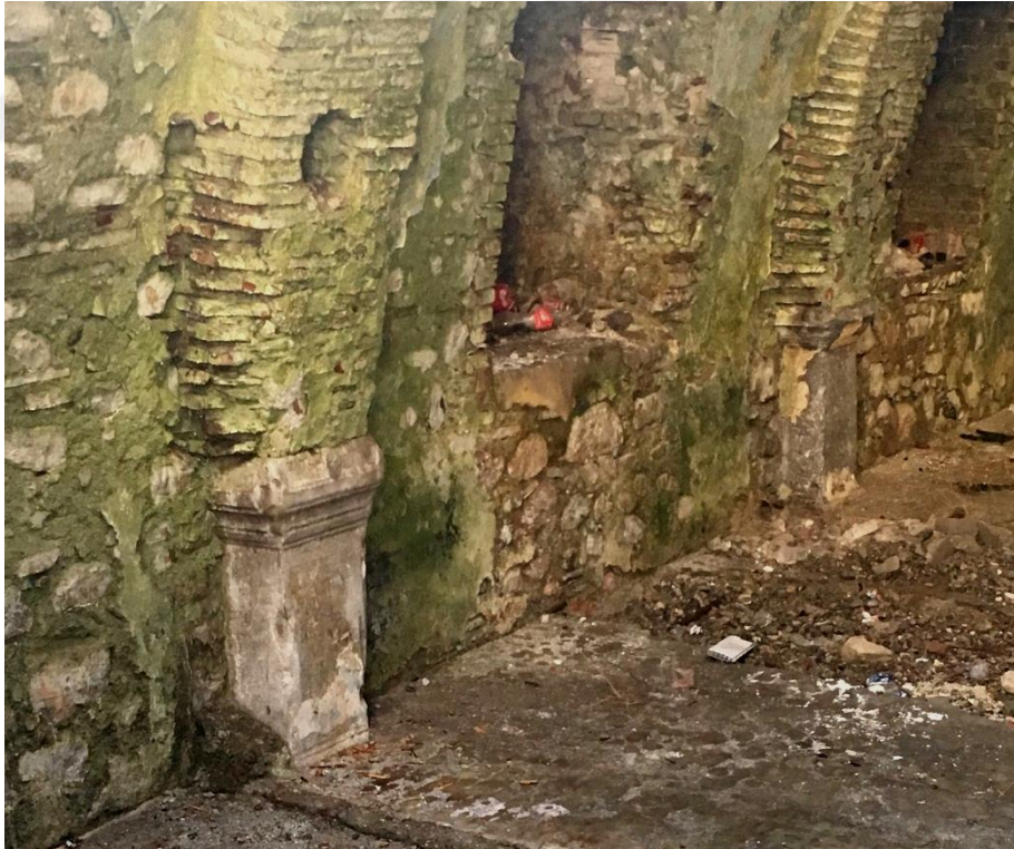
Şekil 2.33 İç mekanda taşıyıcı kemerlerin altındaki Antik Dönem taşları (Kişisel arşiv, 2017)
