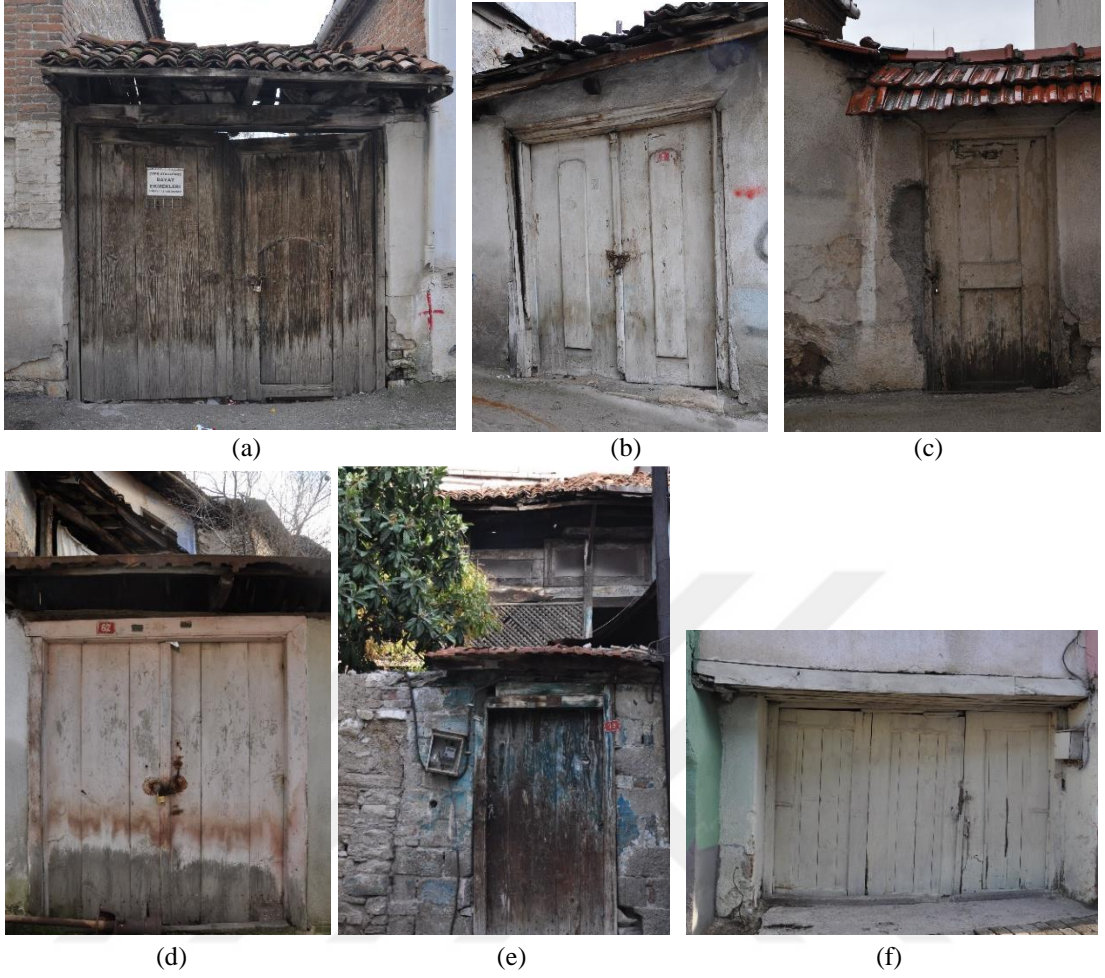
Şekil 4.106 (a), (b), (c) Rum konutlarında görülen bahçe/avlu kapı örnekleri, (d), (e), (f) Türk konutlarında görülen bahçe/avlu kapı örnekleri (Kişisel arşiv, 2019)
