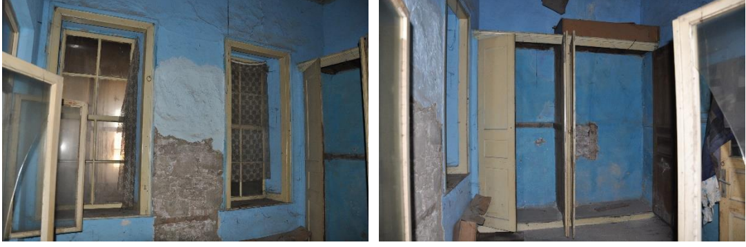
Şekil 4.81 4 nolu odanın ahşap giyotin iç pencereleri ve ahşap dolapları (Kişisel arşiv, 2019)
