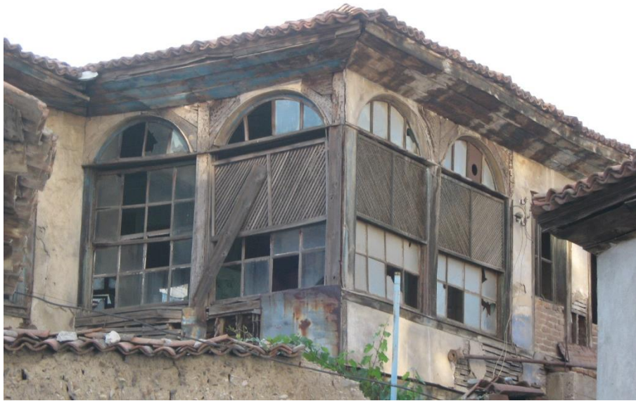
Şekil 4.55 Yapının restore edilmeden önceki resmi (Soma Belediyesi arşivi, 2010)
