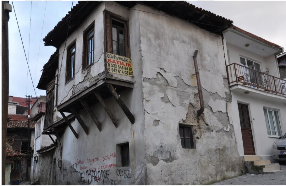
Şekil 4.24 Konutun ön (kuzey) cephesi ile batı cephesinden görünümü (Kişisel arşiv, 2019)
