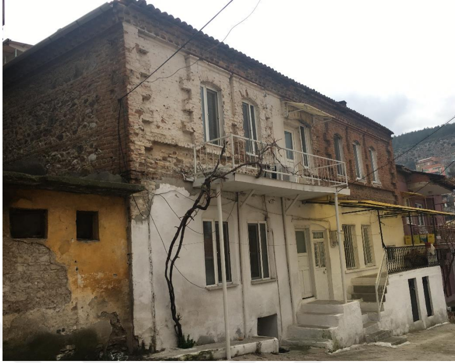
Şekil 5.3 Özgünde bir bütün olan yapının farklı ailelerin kullanımı için ayrılmasına ve özgün cephe kurgusunda olmayan balkon eki yapılmasına bir örnek (Kişisel arşiv, 2017)
