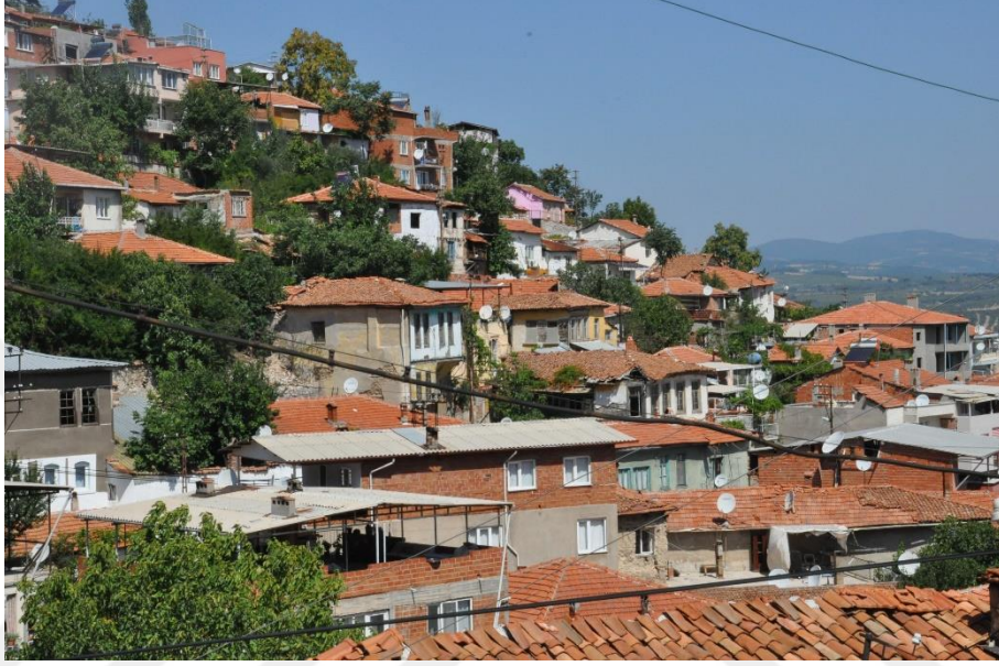
Şekil 5.17 Tarihi dokuda bulunan izinsiz inşa edilmiş niteliksiz yapı örnekleri (Kişisel arşiv, 2017)
