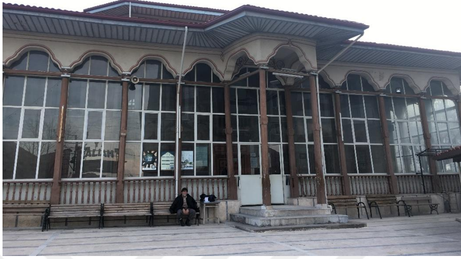
Şekil 3.14 Onarım gerektirmeyen 181 Ada 1 Parseldeki Emir Hıdır Camii (Kişisel arşiv, 2017)
