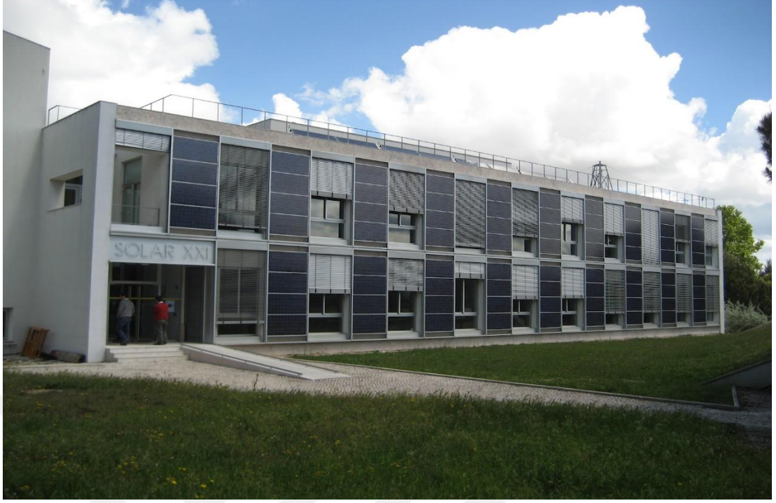
Şekil 3.21 SOLAR XXI binasının güney cephesinden dış görünümü (Gale-Snowden, 2019)
