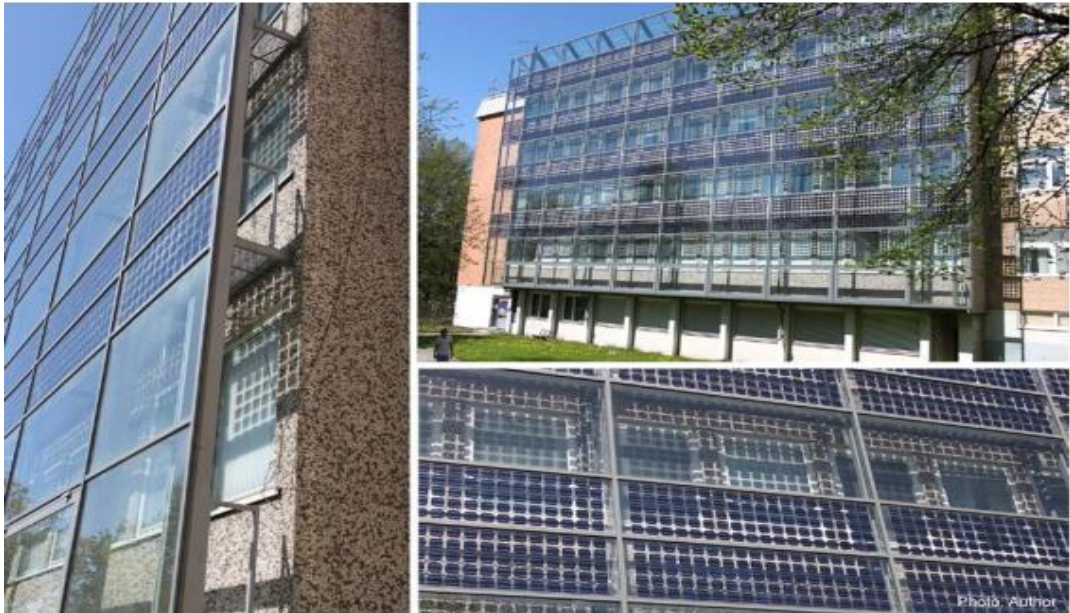
Şekil 3.16 Cam cephede monokristal PV kaplamalı BP Solar binası (Basnet, 2012)
