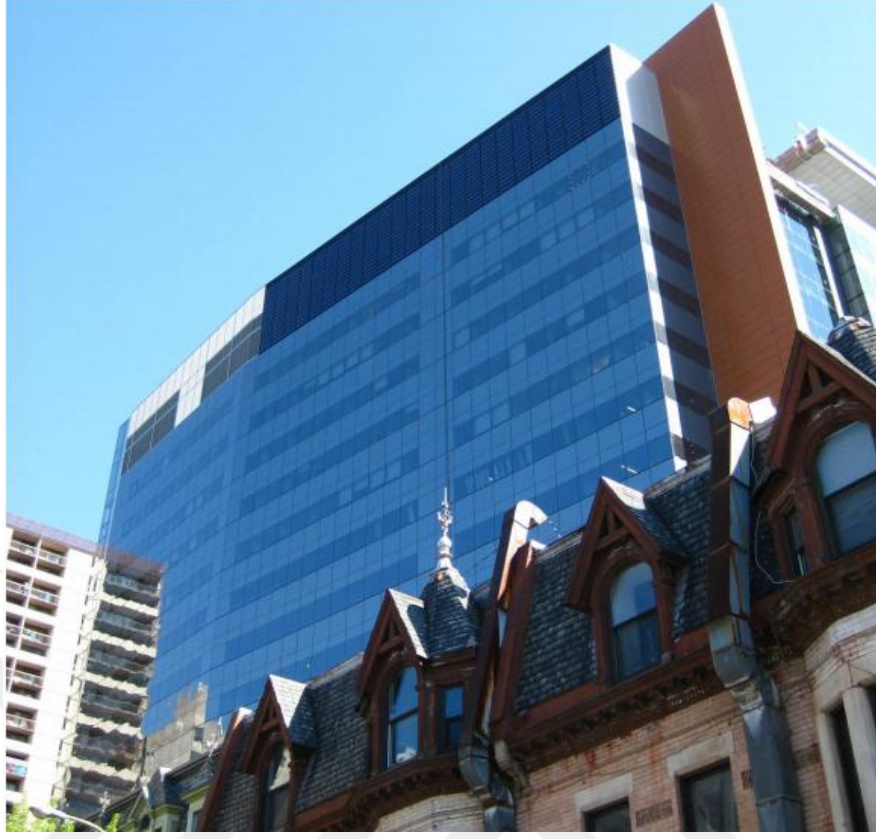
Şekil 3.13 JMSB binasının cephesine entegre PV/T sisteminin sokak seviyesinden görünümü (Concordia, 2018)
