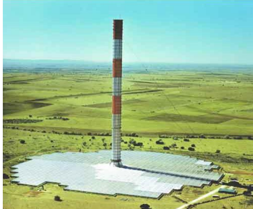
Şekil 2.10 İspanya'daki Manzanares güneş bacası (200 m yükseklik, 10 metre çap, 50 kW güç) (Kıncay ve Utlı, 2018)
