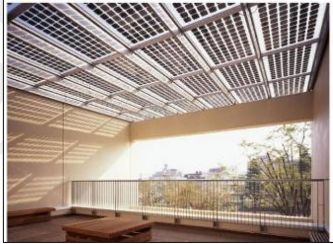
Şekil 2.20 Binaya entegre şeffaf PV modüllerinden oluşan cam tavan (Global Energy Network Institute, 2009)
