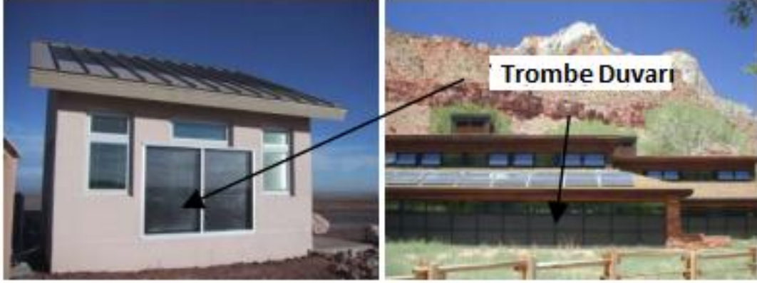
Şekil 2.4 Trombe duvarı uygulamaları a) ABD Colorado'da bulunan NREL, b) Utah'ta bulunan Zion Ulusal Parkı Ziyaretçi Merkezi (Torcellini ve Pless, 2004)
