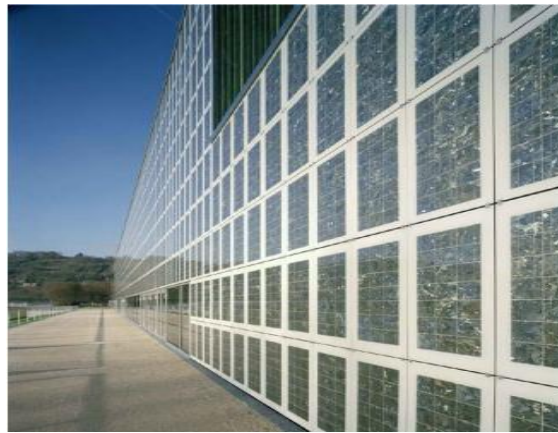
Şekil 3.19 Paul Horn Arena'daki renkli polikristal güneş hücrelerinin entegrasyonu (Almannsattlerwappner, 2018)
