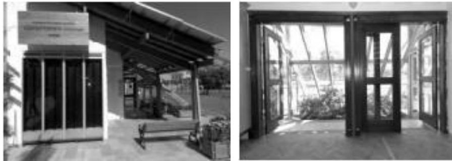
Şekil 3.32 Güneş Evine ait tromp duvarı ve sera (Aykal, Gümüş ve Özbudak-Akça, 2009)
