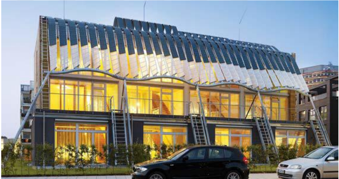
Şekil 3.27 Soft House’un Uyarlanabilir PV tekstil membran gölgelendirme görünümü (Orhon, 2016)
