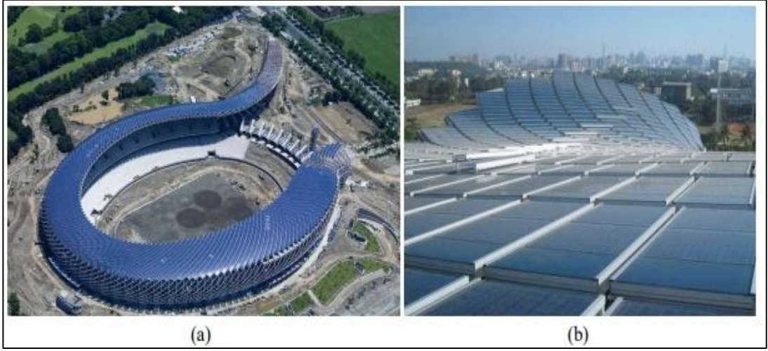
Şekil 2.23 Kaohsiung Dragon stadyumu a) Kuşbakışı görüntü ve b) çatıdaki BIPV modüller (Orhon ve Altın, 2014)
