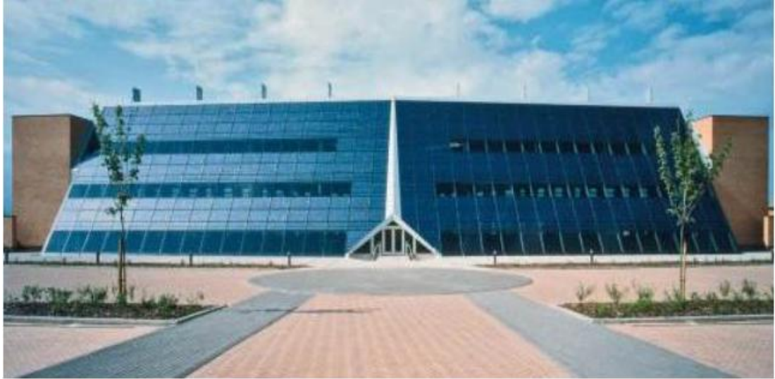
Şekil 3.24 Solar Ofis Doxford International binasının dış görünümü (Skaaland ve diğer., 2011)
