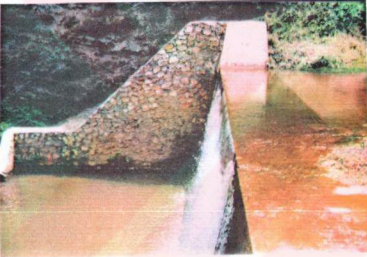
Foto 9: Akarsuların taşkınlara ve erozyona neden olmasını önlemek için yapılan bentlere bir örnek.
