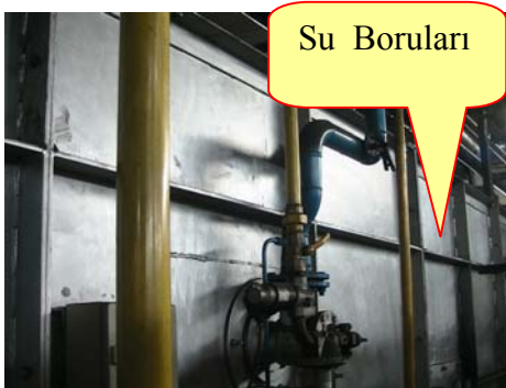
Şekil 12: Su Borularının ve Doğalgaz Borularının Renklendirilmesi
