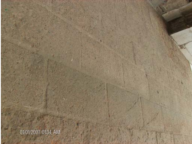
Resim 237: Emir Sultan Camisi, Revak Zemin Döşemesi
