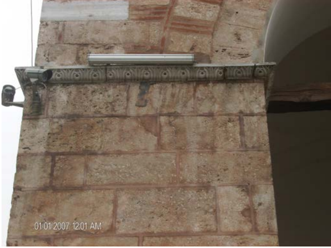
Resim 238: I.Murad Camisi, Revakta Mermer Korniş
