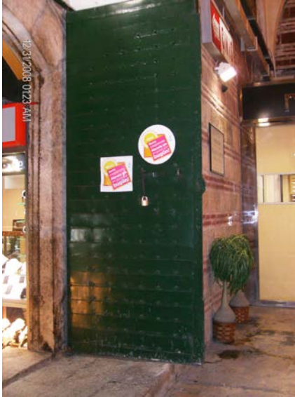
Resim 202: Orhan Hamamı, Demir Kapı
