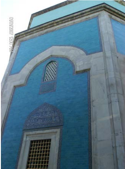
Resim 326: Yeşil Türbesi, 2010 Yılı Onarımı Sonrası Duvarda Çiniler
