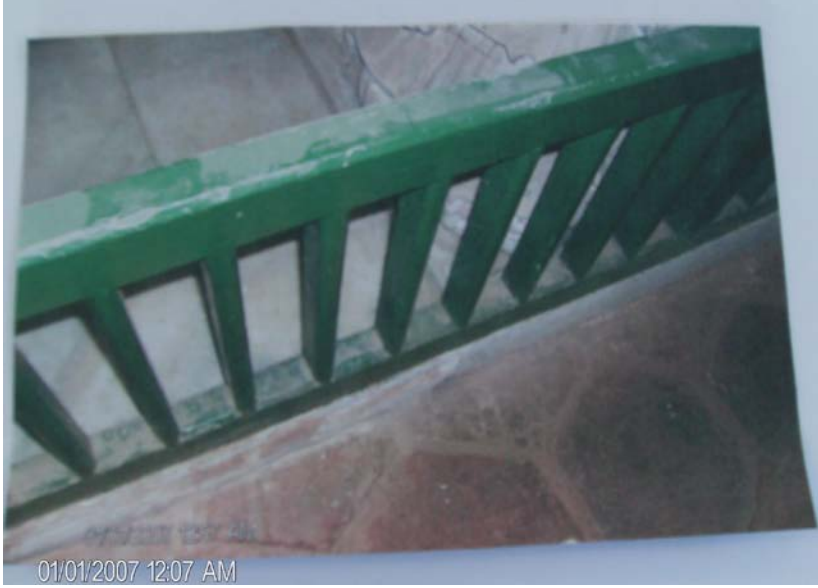
Resim 236: II.Murad Türbesi, İç Kısımda Zemin Döşemesi
