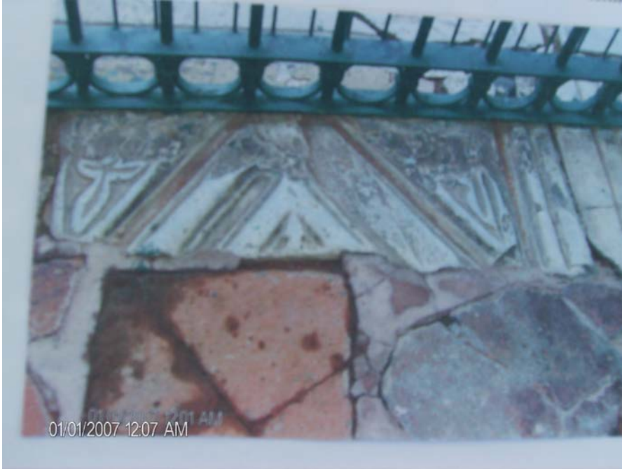
Resim 229: Orhan Camisi, Revak Zemin Döşemesinde Devşirme Mermer
