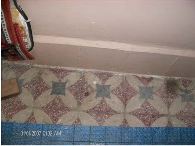
Resim 234: Maksem Camisi, Revak Döşemesi Olarak Yer Karosu
