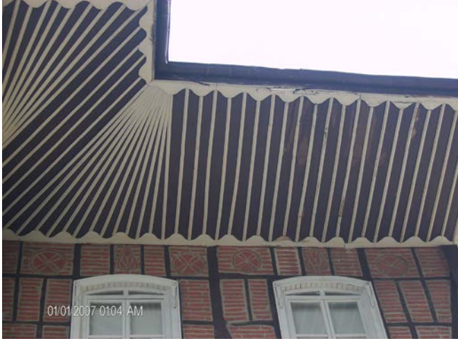
Resim 252: Belediye Binası Ahşap Saçak
