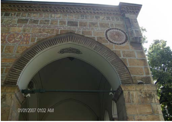
Resim 128: Orhan Camisi, Revakta Tuğla Kemer
