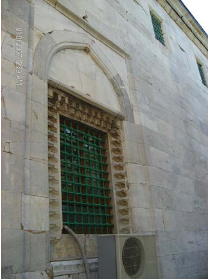
Resim 184: Yıldırım Camisi, Yan Cephe Pencere Atkı ve Sövesi
