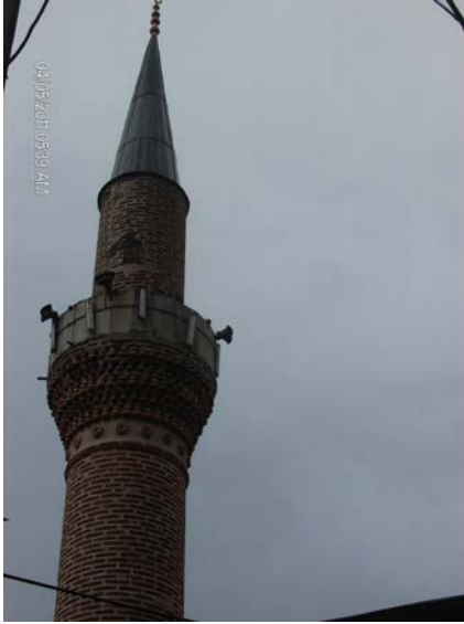
Resim 293: Őeyh Konevi Camisi, Minare Gvdesinin st Kısımındaki Tuęla Ssleme
