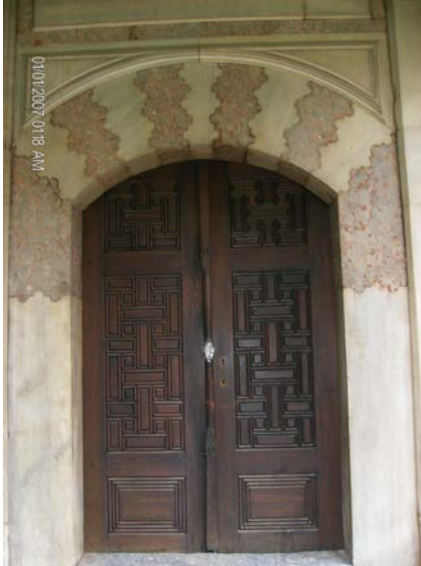
Resim 200: Şehzade Ahmed Türbesi, Kapı
