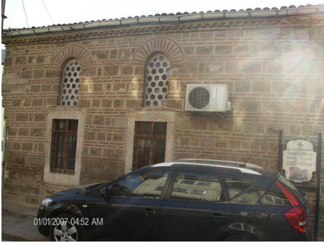
Resim 186: Çerağ Bey Camisi, Pencere Atkı ve Sövesi
