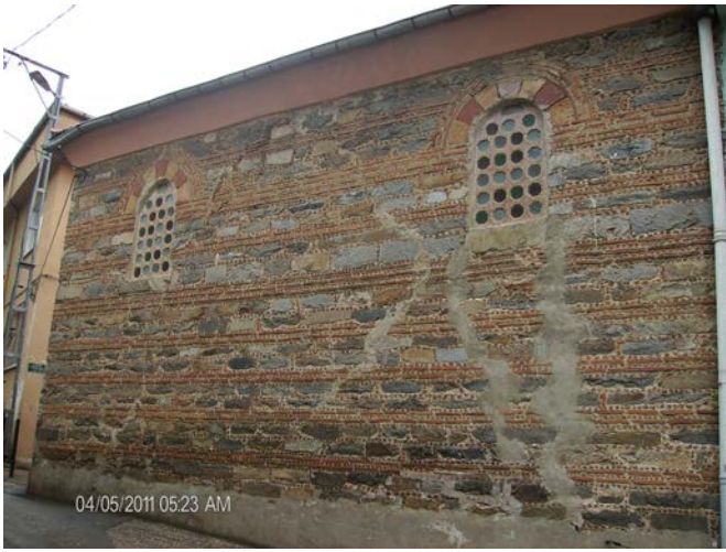
Resim 64: Şeyh Konevi Camisi, Güney Duvarı
