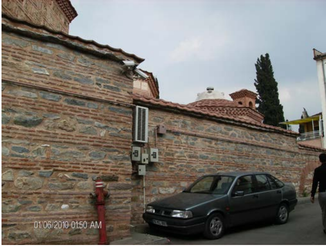
Resim 37: II.Murad Hamamı, Duvar Genel Görünüm
