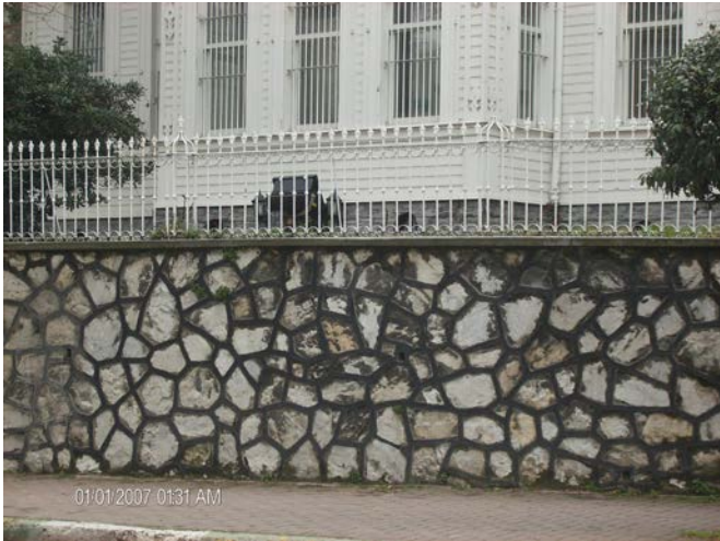
Resim 219: Saatçi Köşkü, Bahçe Duvarı Parmaklığı
