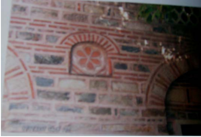
Resim 142: Kara Şeyh Camisi, Duvarda Ss Kemerleri
