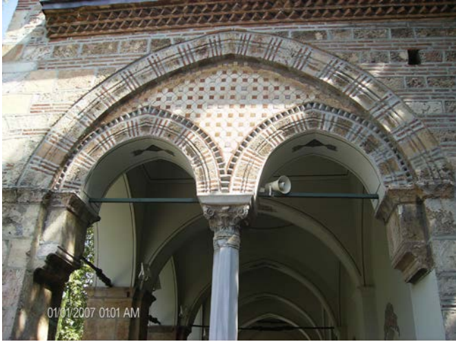
Resim 121: Orhan Camisi, Yan İkiz Kemer ve Kemer Alınlığı
