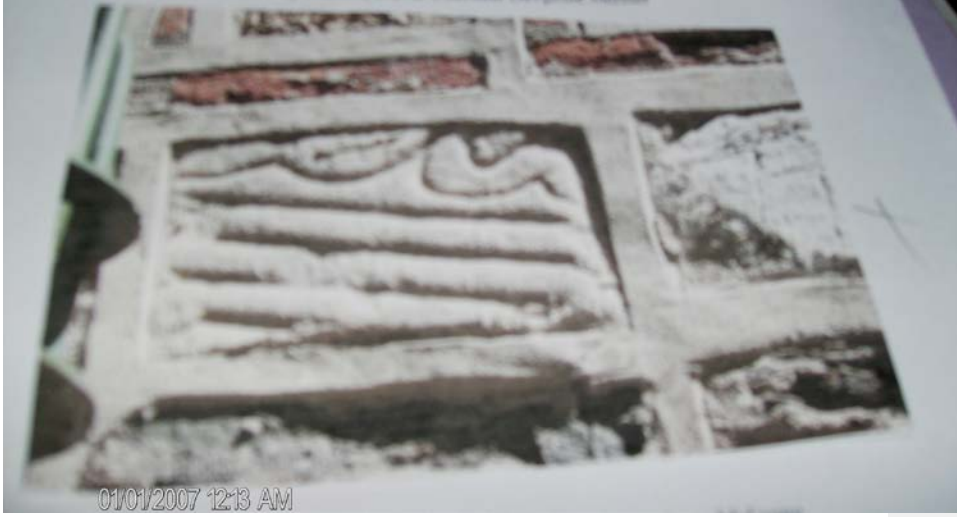
Resim 351: Orhan Bey Camisi, Duvar Üzerinde Devşirme Mermer
