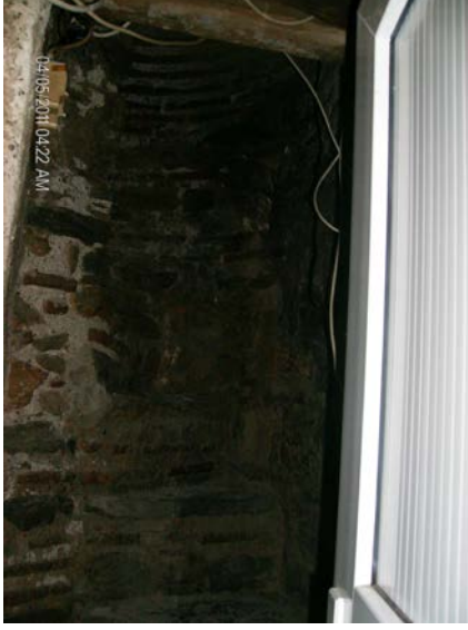
Resim 296: Üç Kuzular Camisi, Minare Merdiven Basamakları
