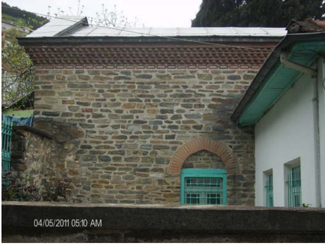
Resim 249: Molla Fenari Camisi, Kirpi Saçak
