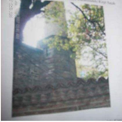
Resim 246: Şeker Hoca Camisi, Minare Kaidesindeki Kirpi Saçak
