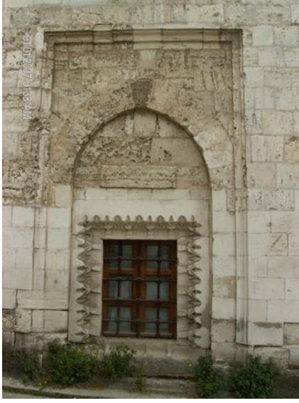
Resim 185: Yıldırım Medresesi Kuzey Cephedeki Pencerenin Atkı ve Sövesi
