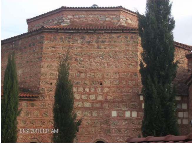
Resim39: Bedreddin Camisi, 1956 Yılındaki Onarımdan Önceki Durumu
