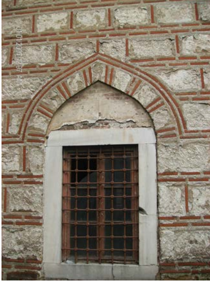
Resim 128: Orhan Camisi, Revakta Tuğla Kemer
