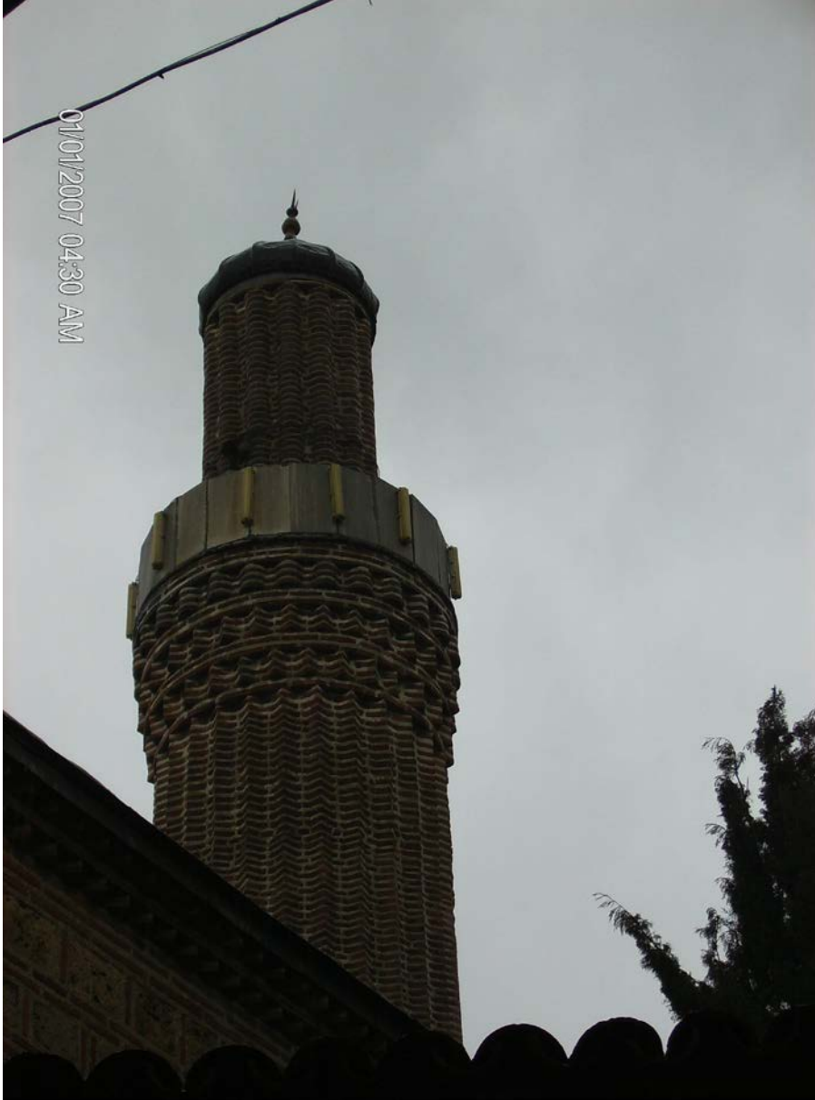
Resim 288: Tuz Pazarı Camisi, Yivli Tuğlalı Minare Gövdesi
