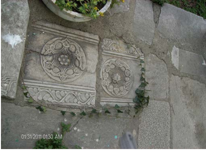
Resim 354: Umur Bey Türbesi, Zemin Döşemesinde Devşirme Mermer
