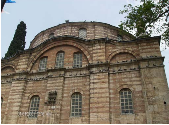
Resim 240: Emir Sultan Camisi, Taş Korniř ve Saak
