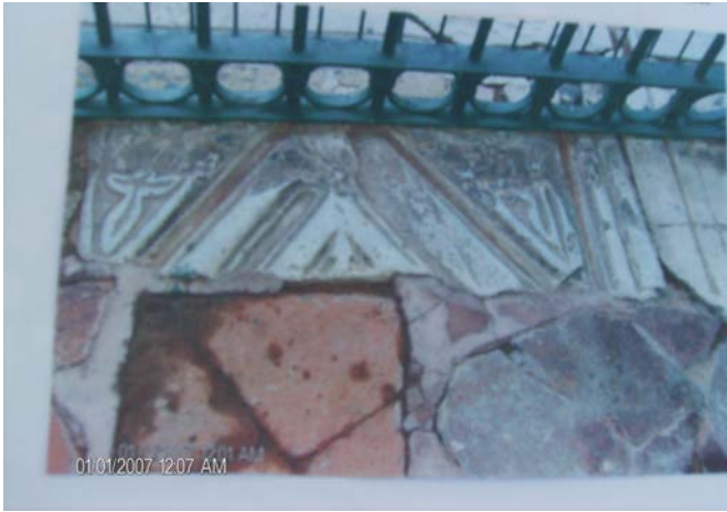
Resim 352: Orhan Bey Camisi, Revak Zemininde Devşirme
