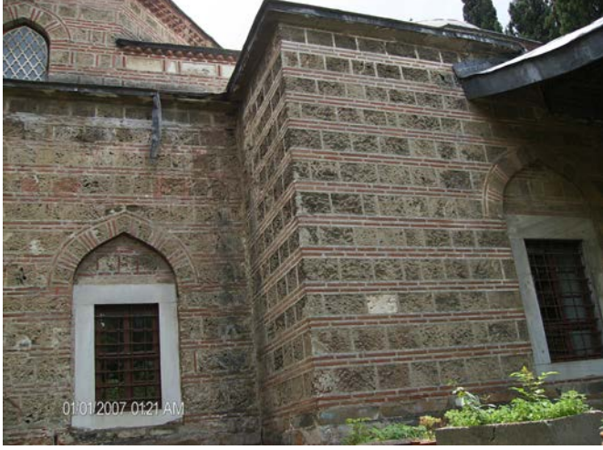
Resim 82: Okçu Baba Türbesi, Tuğlalardaki Renk Değişikliği
