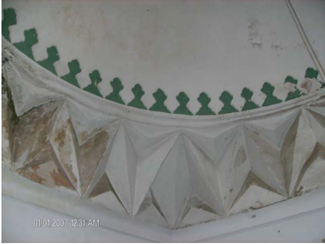
Resim 176: Gir Çık Hamamı, Kubbeye Geçiş Sistemi
