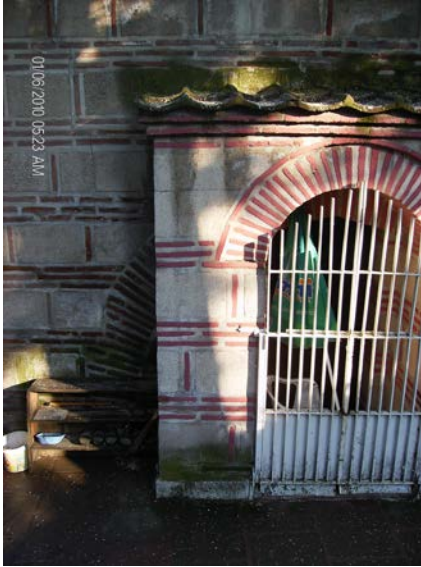
Resim 82: Okçu Baba Türbesi, Tuğlalardaki Renk Değişikliği
