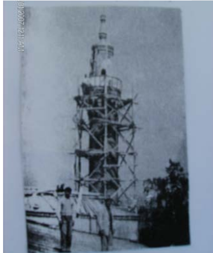
Resim 282: I.Murad Camisi, Minare Onarım Sonu (Takke Külâh)
