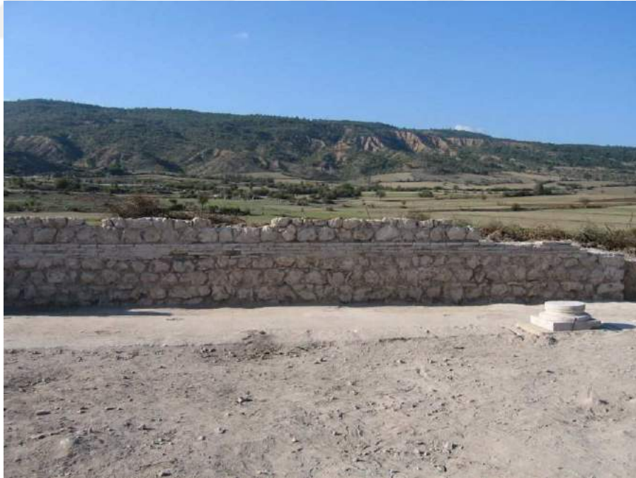
Resim 73: A Kilisesi Kuzey Duvarı
