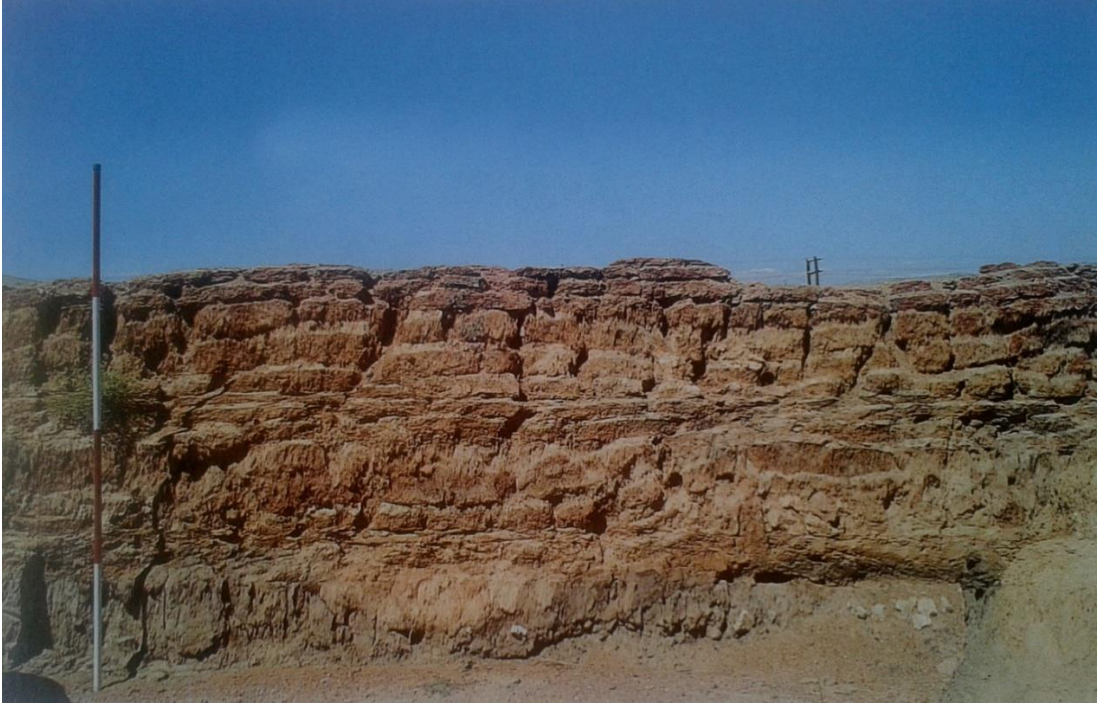
Resim 66: Höyücek TD Yapılarından Birinin Kerpiç Duvarı.
