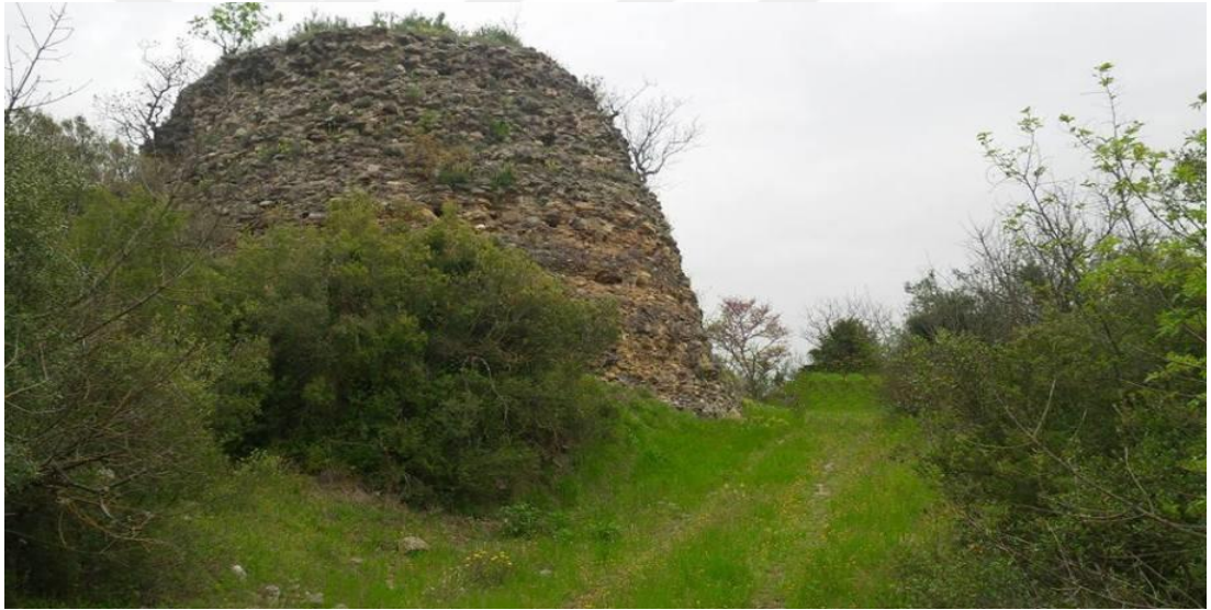
Şekil 5: Kestelek Köyü'nde Bulunan Kule ve Sur Duvarları
