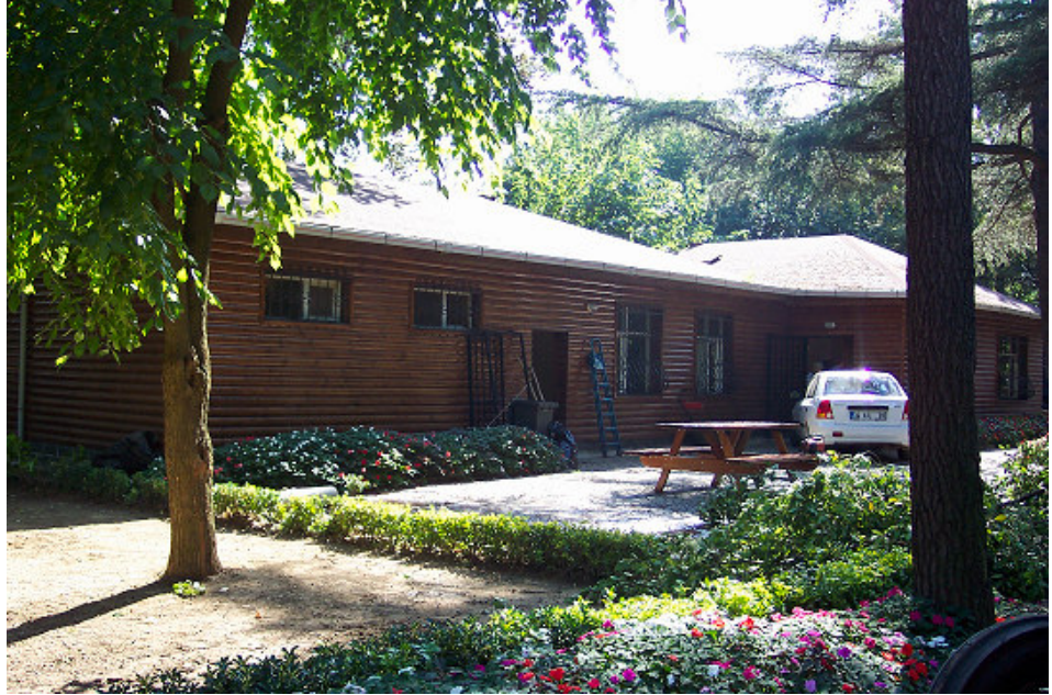
Şekil 4.8. Emirgan Koru Şefliğine ait idare bina
