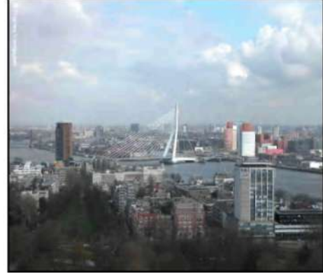
Şekil 4.4. Yeni İnşa Edilen Köprü
