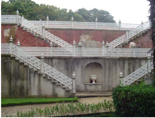
Resim 4.21. İstinad Duvarı, Merdivenler ve Çeşme
