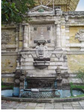
Resim 4.33. Avlu Duvarında Kaskatlı, Selsebilli Çeşme
