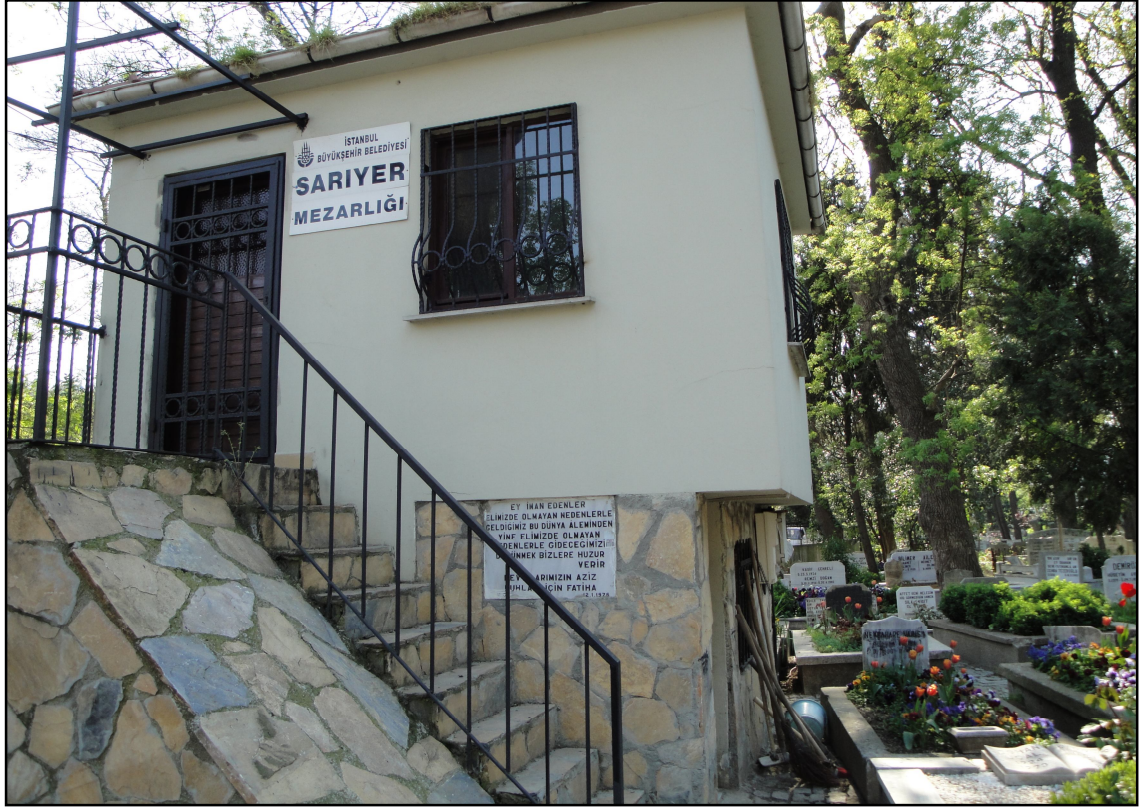
Şekil 5.21 : Sarıyer Mezarlığı İdari Binası
