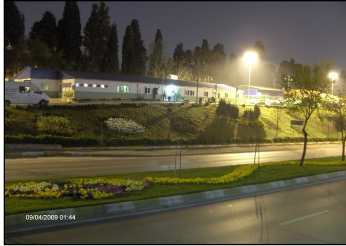
Şekil 5.170 : Müdür yardımcılığı hizmet binası gece aydınlatması
