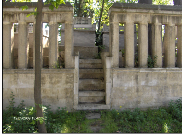
Şekil 5.88 : Mezarlığın 7. adasına kontrolsüz giriş
