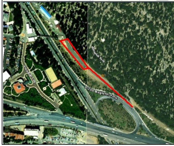
Şekil 5.145 : Mezar inşaatı çalışma noktası hava görüntüsü
