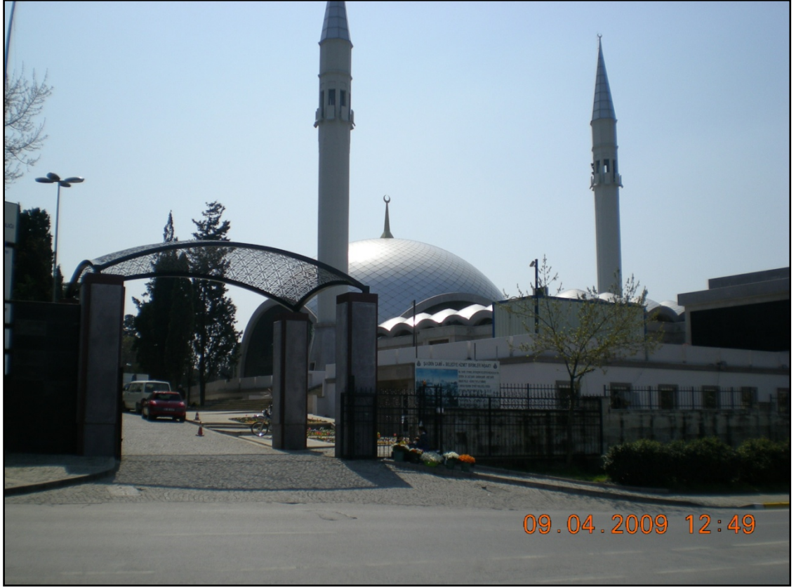
Şekil 5.75 : Mezarlığın Nuh Kuyusu Caddesi giriş ve kapısı
