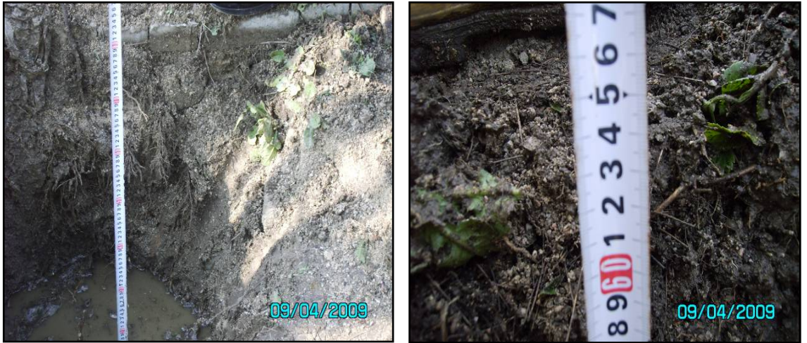
Şekil 5.21 : 60 cm kazı sonucu su çıkmıştır
