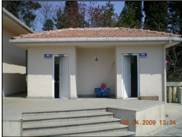
Şekil 5.149 : Gasilhane ve morg binasının yanındaki wc
