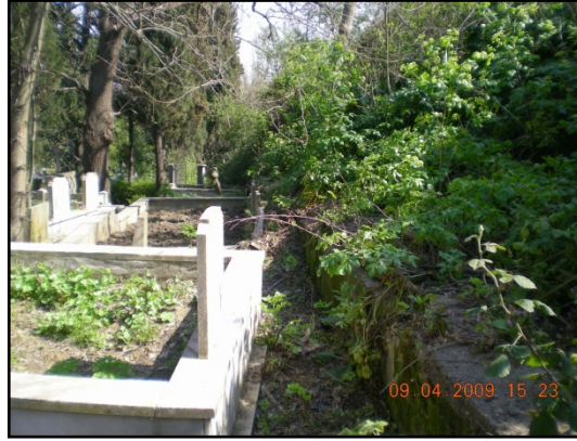
Şekil 5.103: 5. adanın güney duvarları
