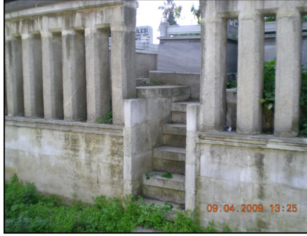
Şekil 5.80 :7. adanın merdivenli diğer bir girişi
