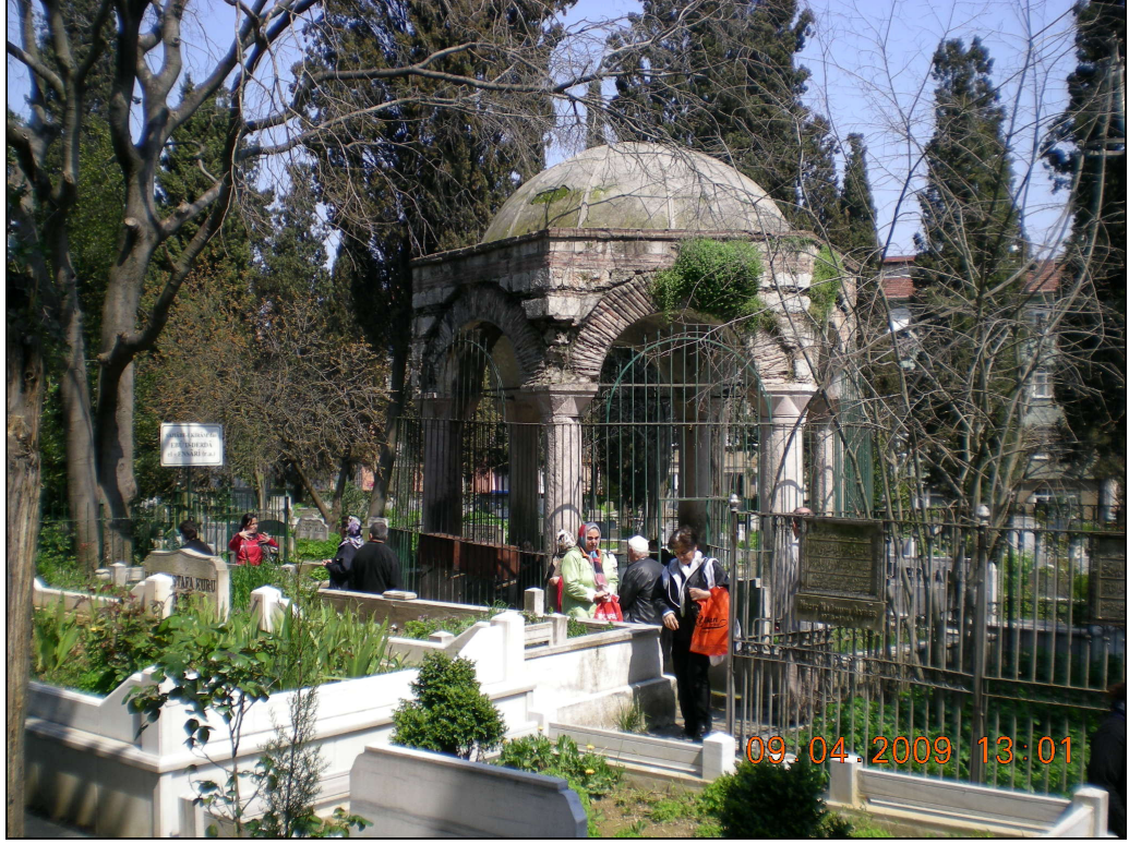
Şekil 4.20 : Nişancı Hamza Paşa Türbesi diğer adıyla Karacaahmet At Türbesi
