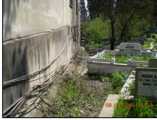
Şekil 5.102 : 4. adanın doğu duvarları
