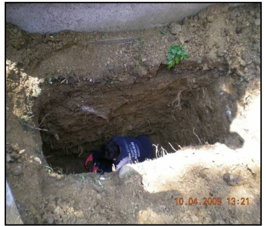
Şekil 5.6 : 4. adadaki muayene çukur çalışmaları
