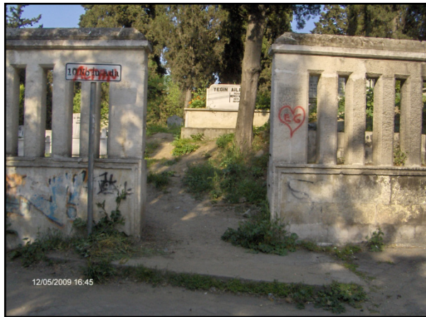
Şekil 5.89 : Mezarlığın 10. ada girişi
