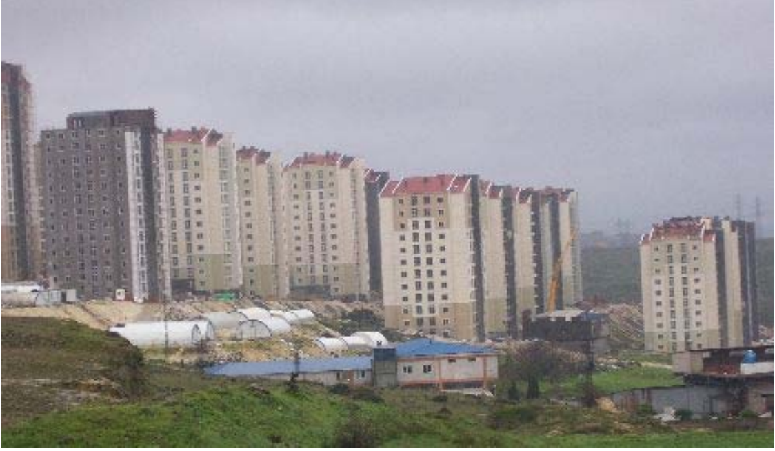
Şekil 3.22: Kayabaşı Konutlarından bir görünüş.
