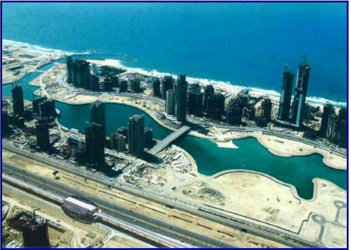
Şekil 3.2: Dubai Metrosu Marina İstasyonu, Viyadük Kaynak: İBB Raylı Sistemler Müdürlüğü Sunum Dosyası
