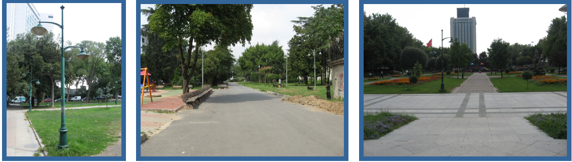
Şekil 7.5: Ana aks ve yaya yolu aydınlatmaları gündüz görüntüsü
