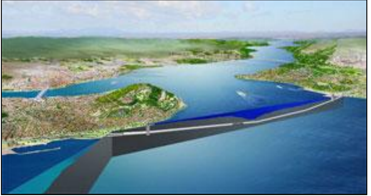
Şekil 2.8 Planlanan Tüp Tünel Geçişi Boğaz Görünümü
