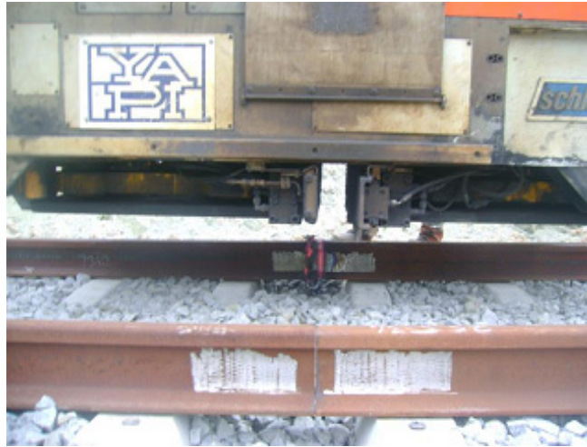
Şekil 4.28: FBW Soğutma işlemi
