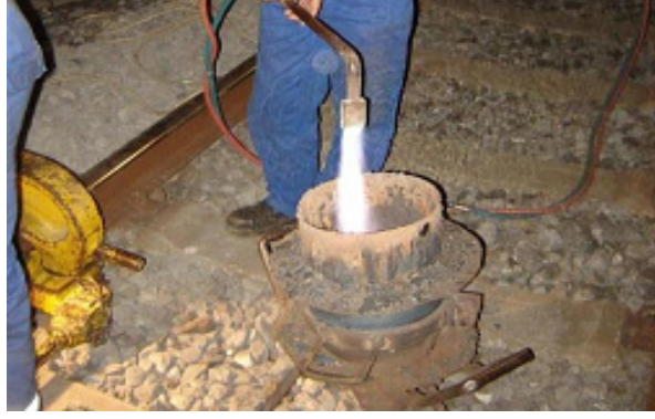
Şekil 4.15: Potanın ısıtılması
