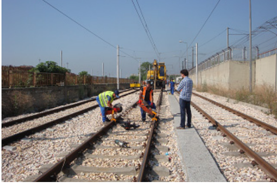
Şekil 8.9: Ray kesme yapılıması
