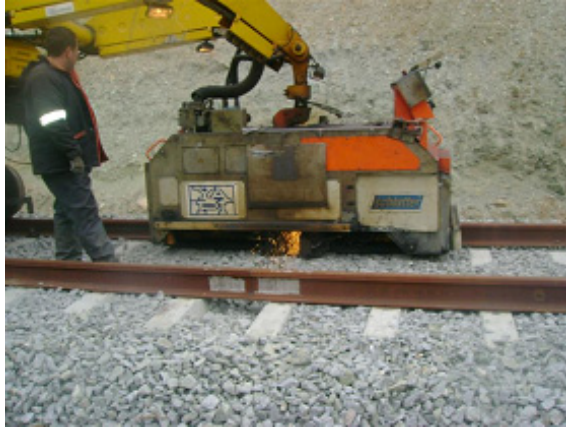
Şekil 4.25: FBW yakma işlemi
