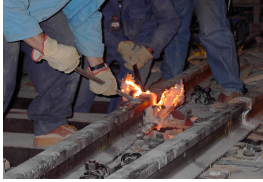
Şekil 4.21: Sıyırma işlemi tamamlanmış ray
