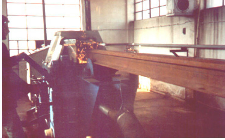
Şekil 4.29: Yakma alın kaynağı sonrası taşlama işlemi
