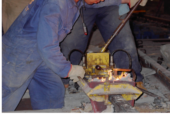
Şekil 4.20: Aluminotermite kaynağında ray sıyırma işlemi
