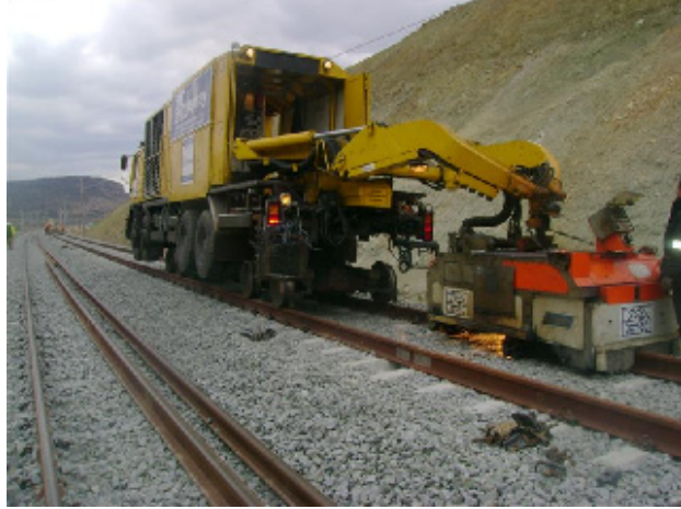
Şekil 4.26: FBW Yanma işlemi
