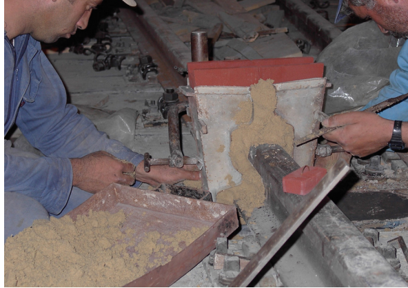
Şekil 4.14: Aluminotermite kaynak kalıbın bağlama
