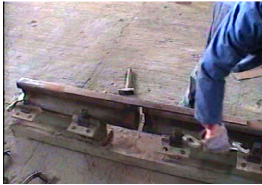
Şekil 4.13: Kaynak boşluğunun hizalanması
