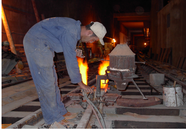
Şekil 4.17: Rayların ısıtılması
