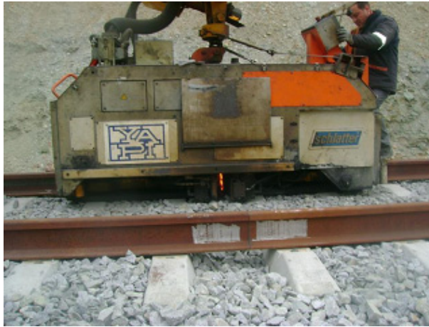
Şekil 4.27: FBW Şişirme işlemi
