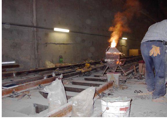
Şekil 4.18: Pota içinde reaksiyon oluşması
