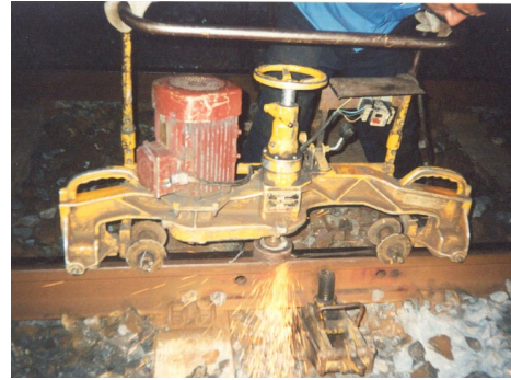
Şekil 4.12: Kaynak taşlama makinesi
