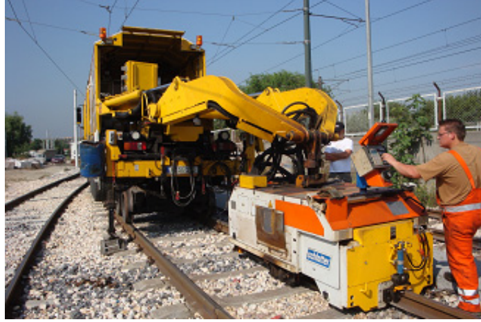
Şekil 4.30: FBW Otomatik kafa ayarlama
