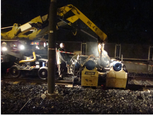
Şekil 8.11: Gece kaynak çalışması
