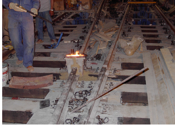
Şekil 4.19: Porsiyonun kalıba dökülmesi
