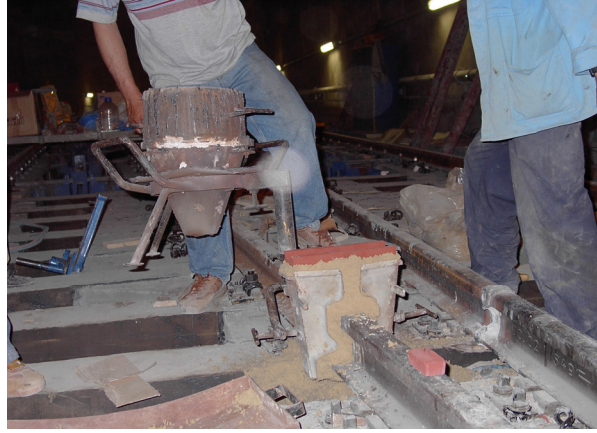
Şekil 4.16: Potanın yerleştirilmesi
