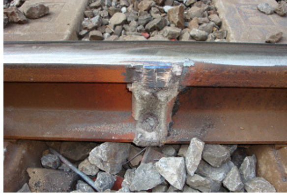
Şekil 4.22: Aluminotermite kaynak yapılmış ray görünüşü
