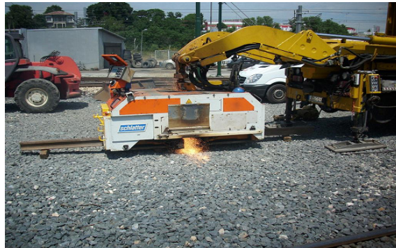
Şekil 8.13: FBW makinesi ile test rayı kaynağı
