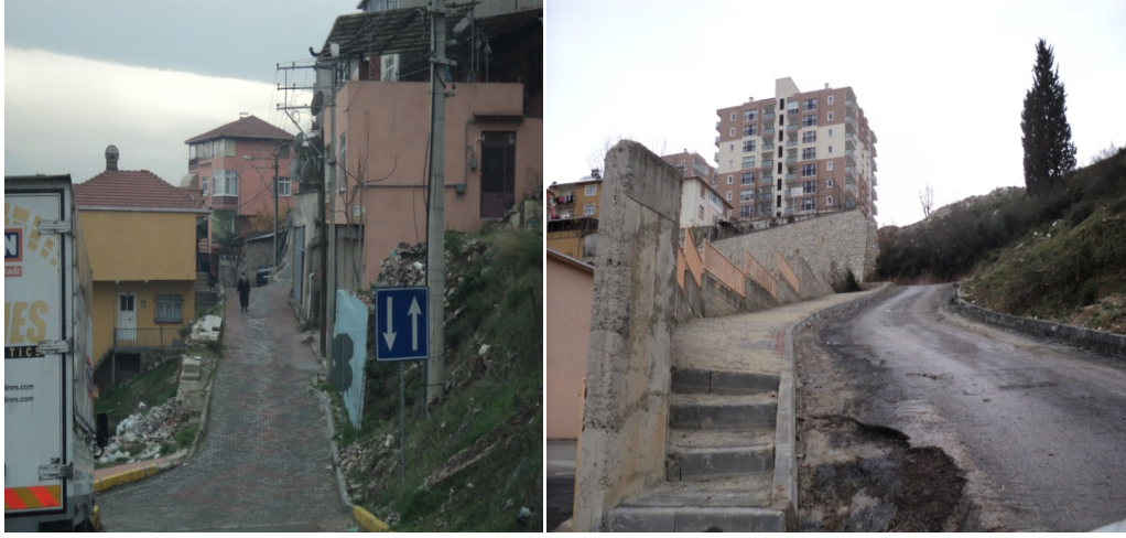
Şekil 4.25: Erenler mahallesindeki bakımsız yol kenarlarından bir görünüm
