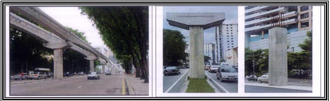
Şekil 2.7 : Kemer tipi monoray ve kolon tasarımları
