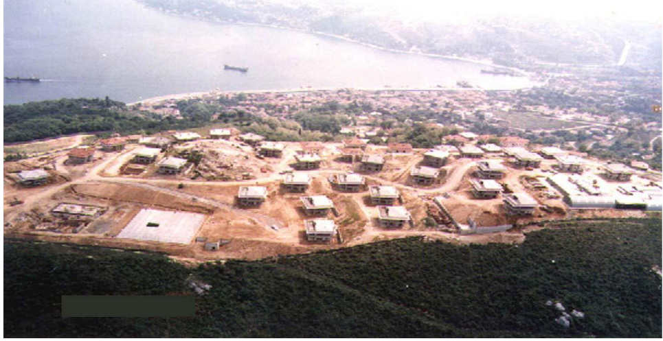
Şekil 5.3: Sarıyer sırtlarında 47. maddeye göre uygulama yapılmış bir site
