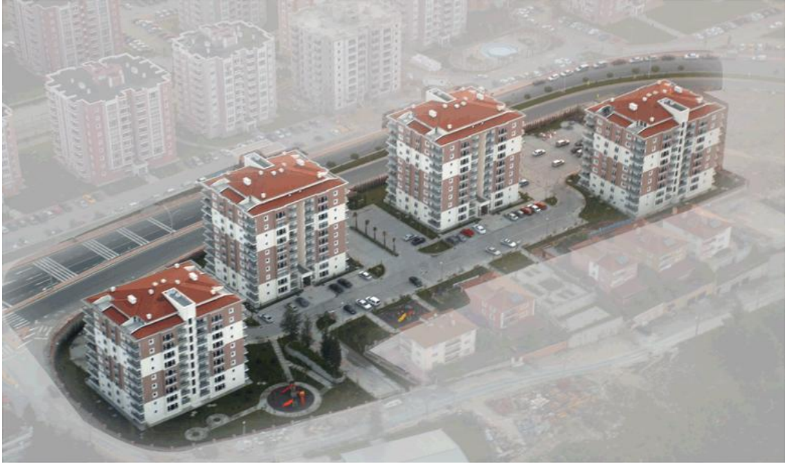
Şekil 6.15 : Umut Kent Sitesi
