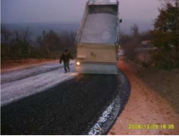
Resim 4.2 : Sathi Kaplama Agrega Sericisi Kaynak : K.B.B. Fen İşleri Daire Başkanlığı
