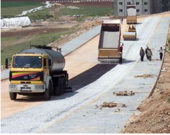
Resim 6.1 : Sathi Kaplama Yapılması Kaynak : K.B.B. Fen İşleri Daire Başkanlığı
