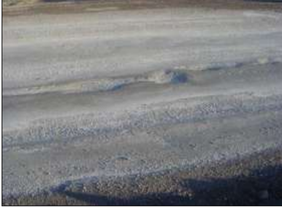
Resim 7.3 : Kaplama yüzeyinde, tekerlek izlerinin yoğunlaştığı kısımlarda meydana gelen çökmeler Sandıklı Devlet Karayolu-2005
