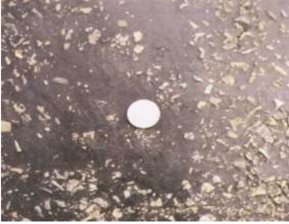
Resim 7.4 : Sathi Kaplamalarda Görülen Kusma Sonucu Oluşan Negatif Yüzey Dokusu
