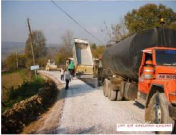
Resim 4.1 : Sathi Kaplama Distribütör Kaynak: K.B.B. Fen İşleri Daire Başkanlığı
