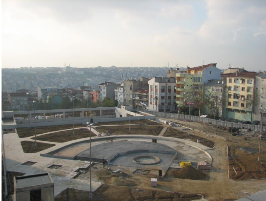
Şekil 2.94: Esenler Nenehatun yer altı otoparkı ve park düzenleme inşaatı (Haziran 2010)
