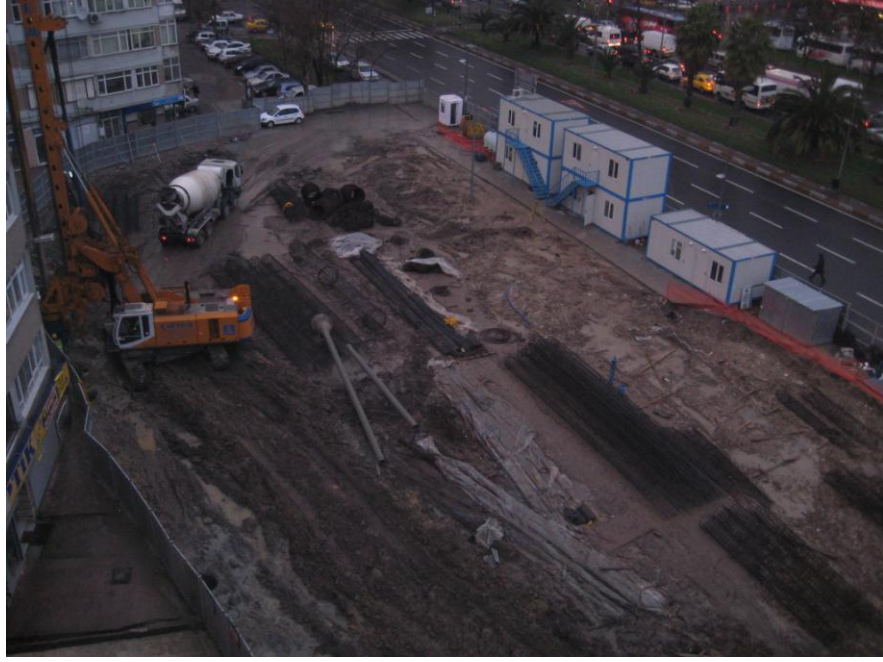
Şekil 2.90: Fatih Muratpaşa yer altı otoparkı ve park düzenleme projesi inşaatı (Temmuz 2010)
