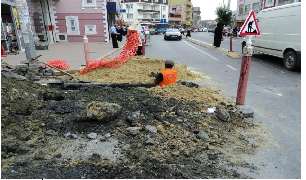
Şekil 3.14: İGDAŞ Kutu Bağlantı Kazı Çalışmaları, Arnavutköy Fatih Cad.
