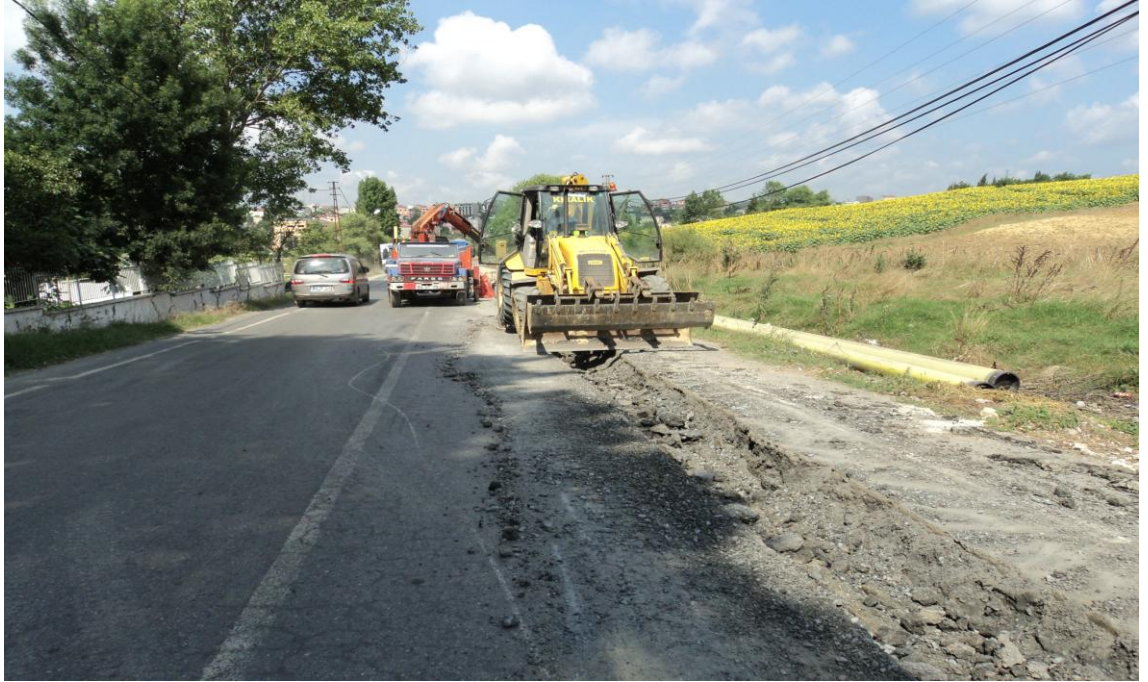
Şekil 3.16: İGDAŞ Polietilen Kazı Çalışmaları, Arnavutköy Haraççı-Hacımaşlı yolu
