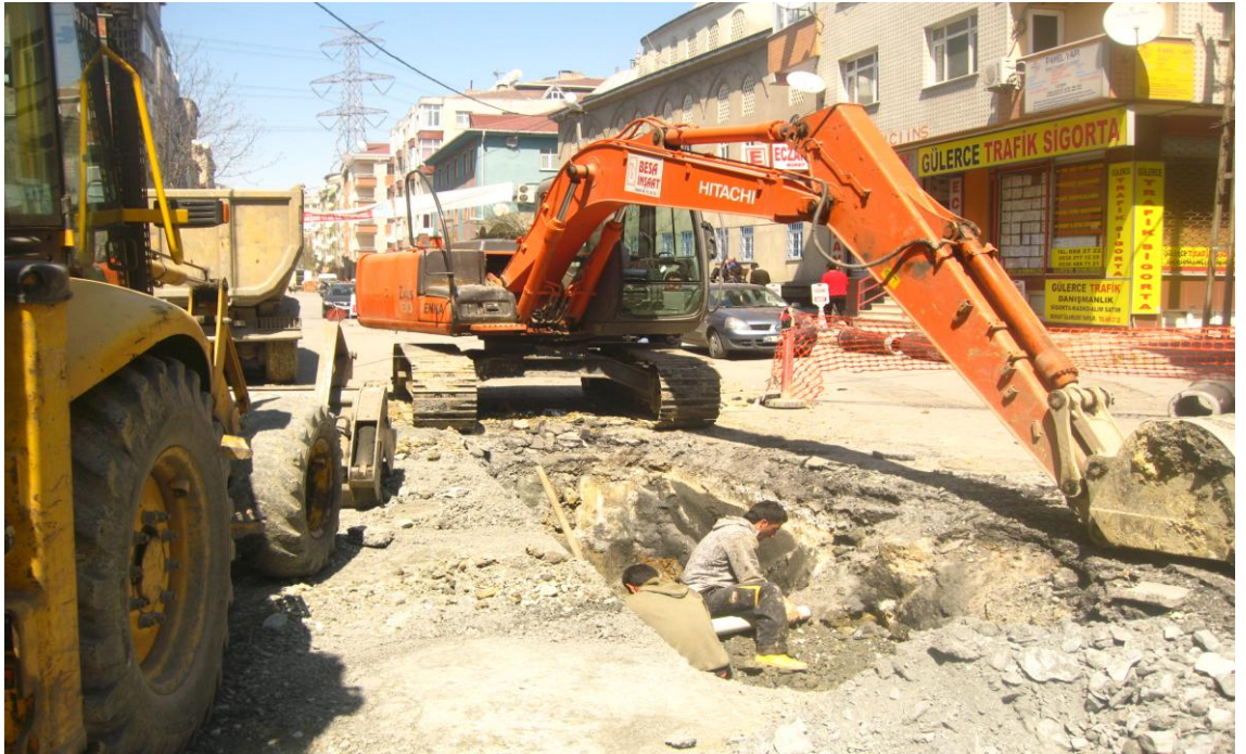
Şekil 3.9: İSKİ Atıksu İsale İnşaat Çalışmaları, Sultangazi Ordu Cad.
