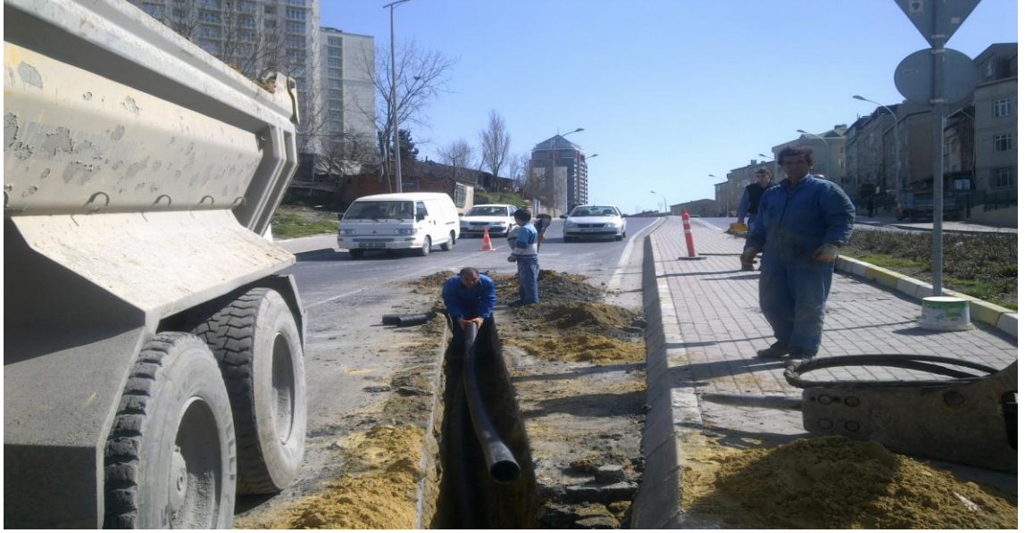
Şekil 3.20: Yatırım Kazı Çalışması, Gaziosmanpaşa,Abdiipekçi Cad.
