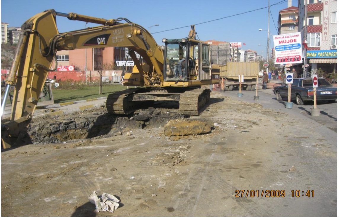
Şekil 3.10: İSKİ Atıksu İsale İnşaat Çalışmaları, Sultangazi İsmetpaşa Cad.
