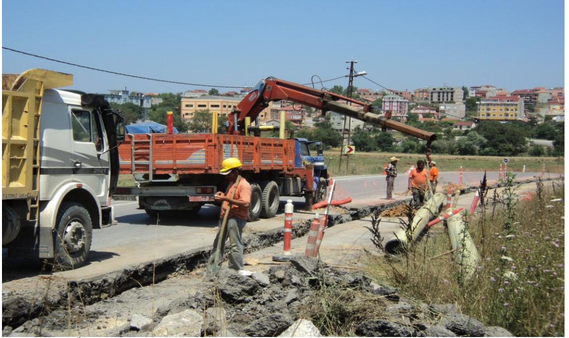
Şekil 3.17: İGDAŞ Polietilen Kazı Çalışmaları Arnavutköy Haraççı-Hacımaşlı yolu
