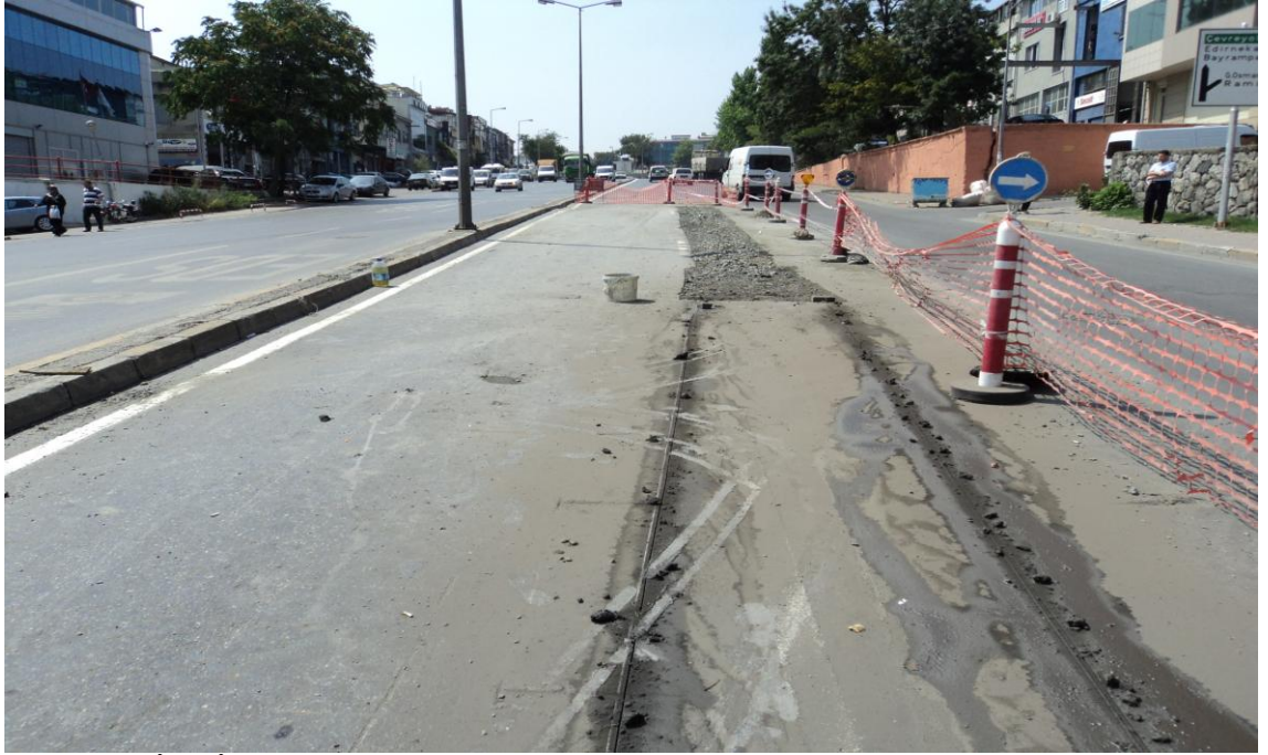
Şekil 3.5: İSKİ Yeni Su Kazı Çalışmaları, Eyüp Sultan Bulvarı
