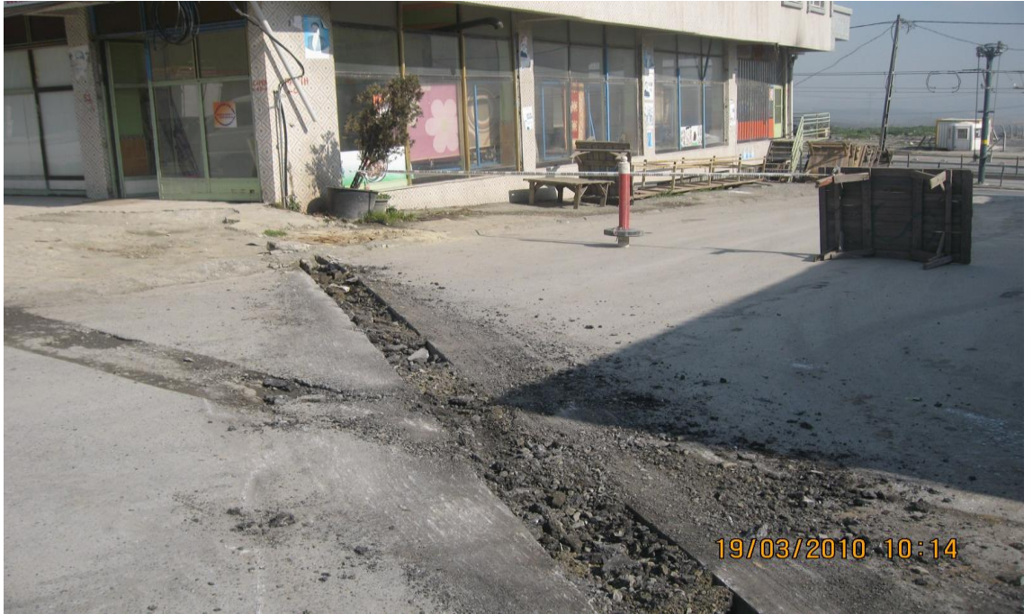
Şekil 3.19: Türk Telekom Fidel Kazı Çalışması, Sultangazi Zafer Cad.
