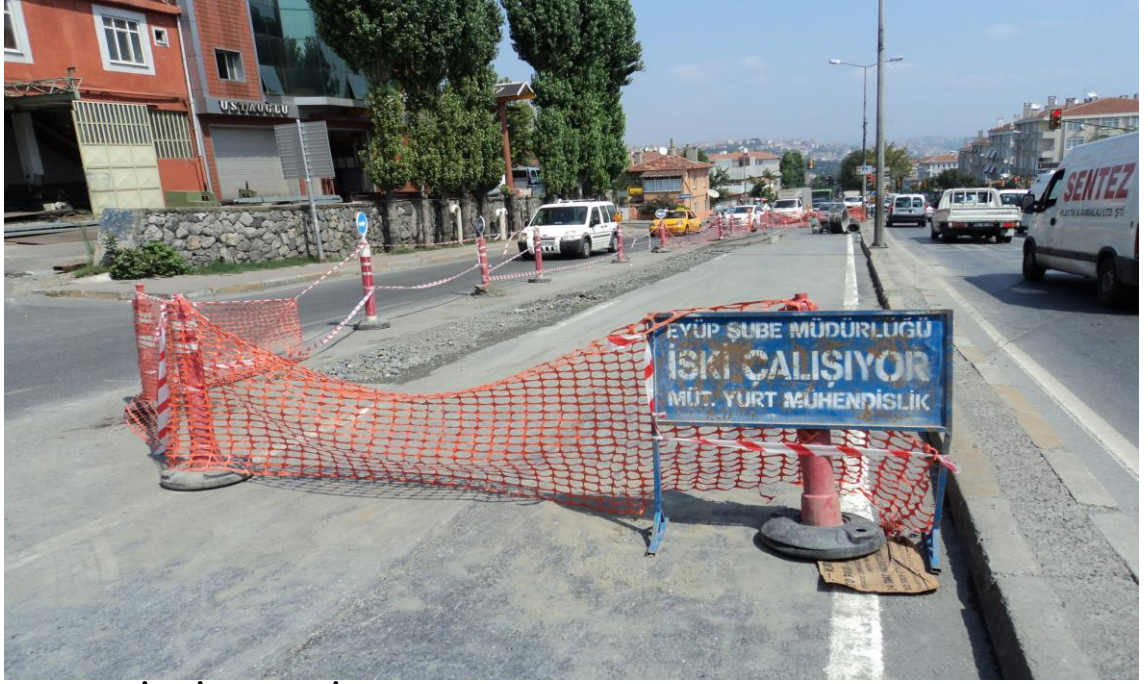
Şekil 3.4: İSKİ Yeni Su İnşaat Çalışmaları Eyüp Sultan Bulvarı
