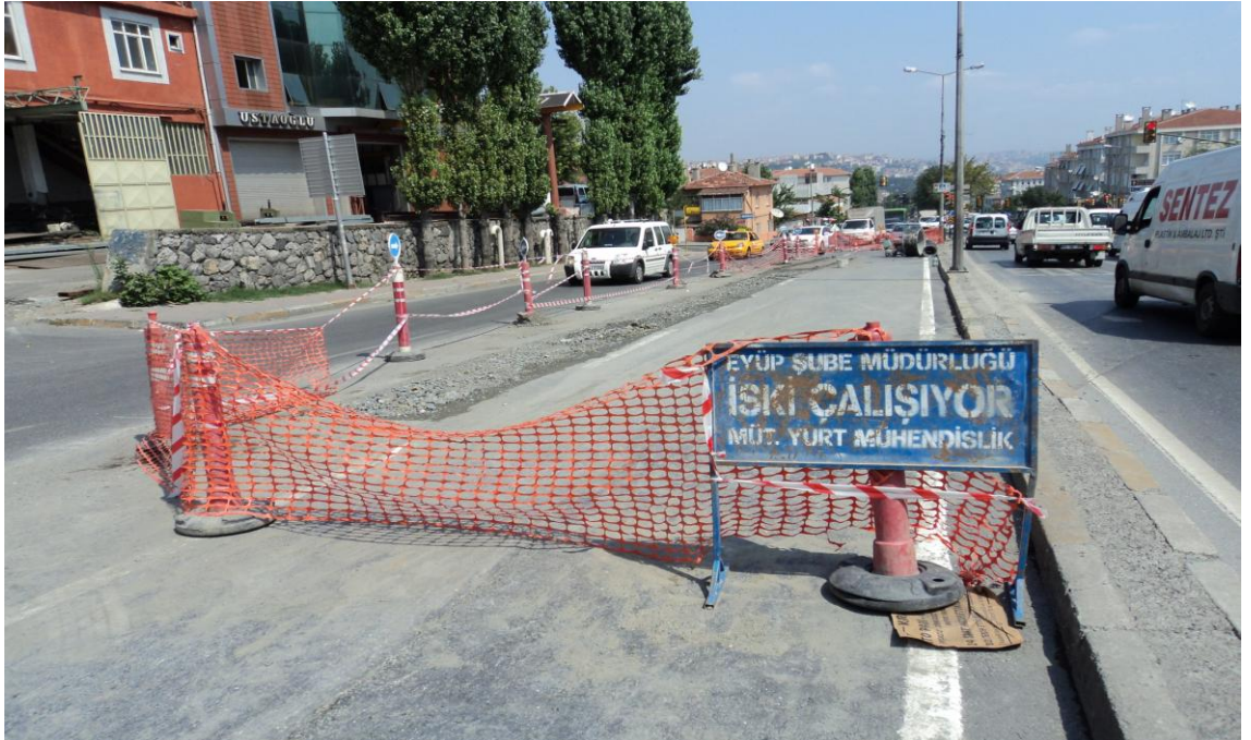
Şekil 3.11: İSKİ Atıksu İsale İnşaat Çalışmaları Eyüp Sultan Bly.
