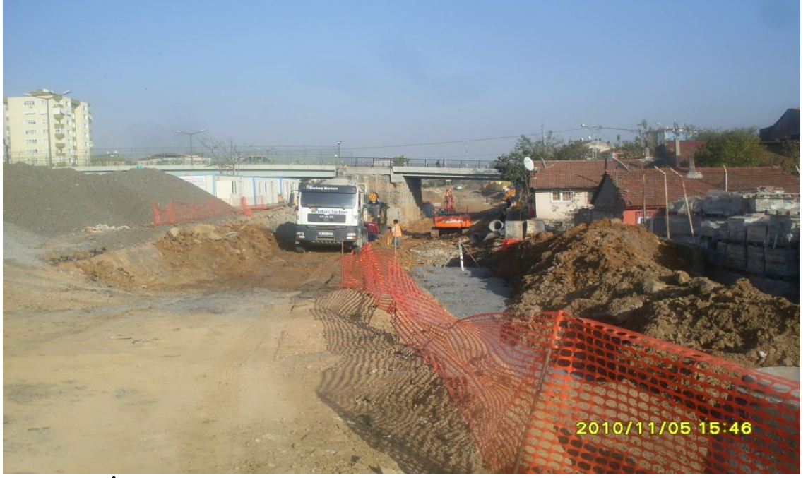
Şekil 3.24: İBB Altyapı Hizmetleri Müdürlüğü Yapım Çalışmaları
