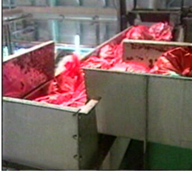
Şekil 5.7: Atık besleme sistemi Kaynak: İSTAÇ AŞ. (2011) Tıbbi Atıkların İnsinerasyon Sunumu
