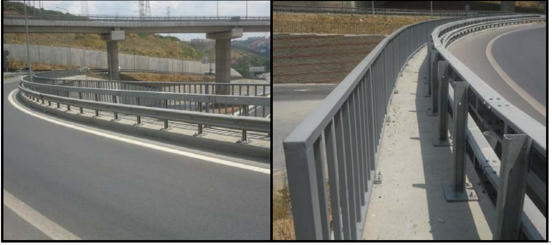
Şekil 3.4: İstanbul Sınırları İçerisinde Bulunan Köprü Tipi, Yeni Uygulanmaya Başlanan Başarılı Oto Korkuluk Uygulamaları
