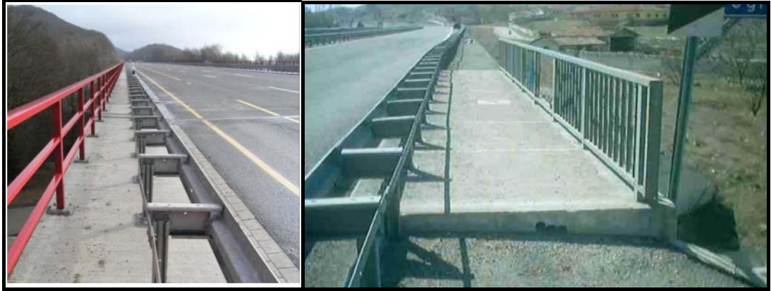
Şekil 3.3: İstanbul Sınırları İçerisinde Bulunan Köprü Tipi, Mevcut Oto Korkuluk Uygulamaları
