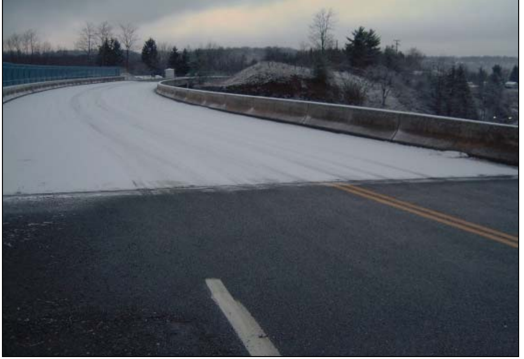
Şekil 2.8: Soğuk Havanın Köprü Geçişlerine Olan Etkisi
