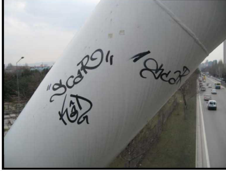
Şekil 4.23: Köprülere kullanıcılar tarafından verilen zarar
