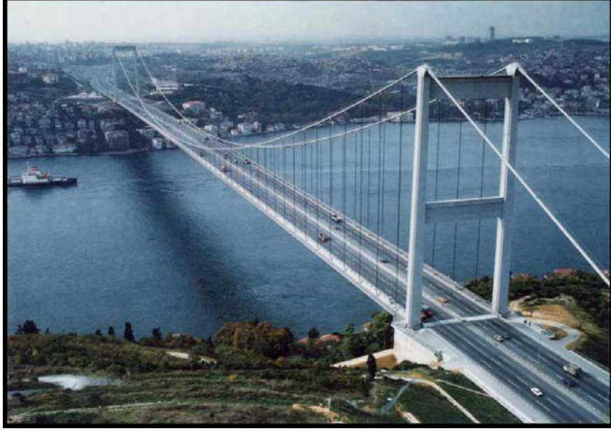
Şekil 2.1: Fatih Sultan Mehmet köprüsü
