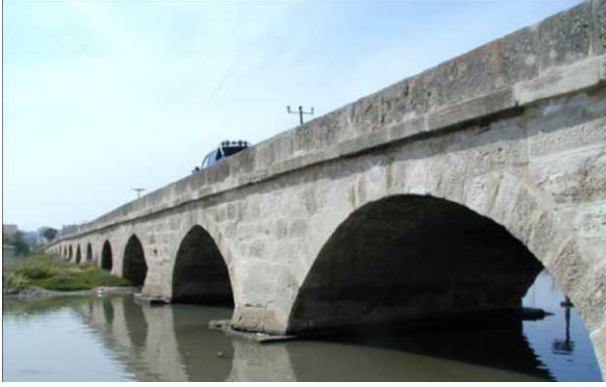
Şekil 3.4: Silivri Çayı Köprüsü
