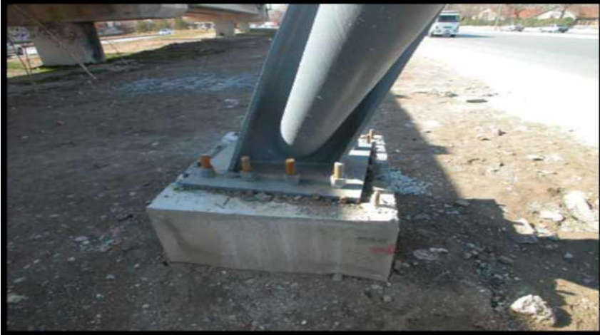
Şekil 4.18: Taşıyıcı sistemin yer ile birleşimi
