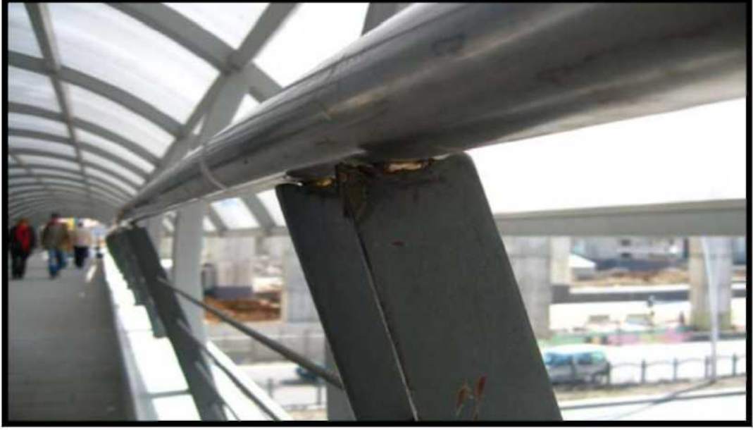
Şekil 4.13: Merdiven detay hataları
