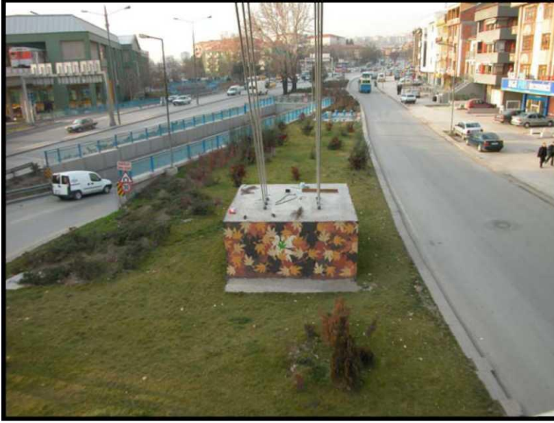
Şekil 4.19: Taşıyıcı sistemin yer ile birleşimi sorunsuz uygulama
