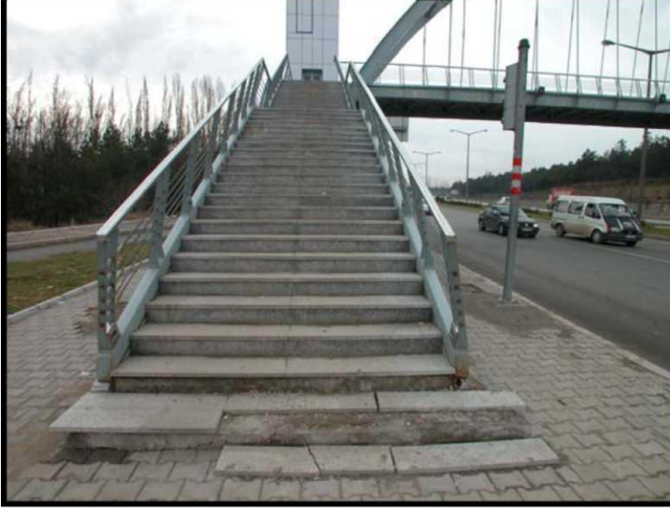
Şekil 4.16: Merdiven ile zemin birleşimi
