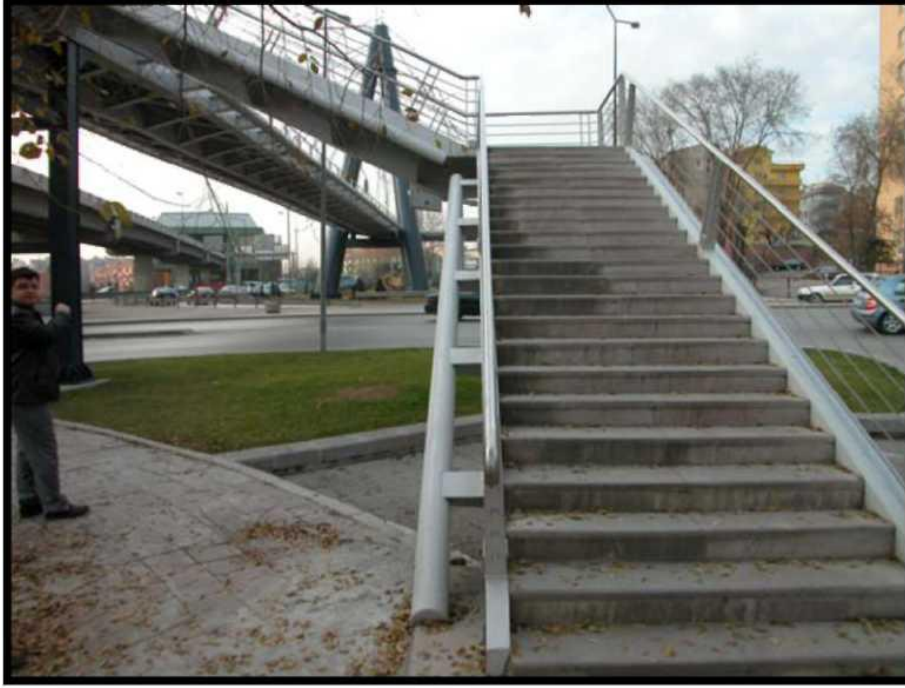
Şekil 4.14: Merdiven detay ve işçilik için sorunsuz bir uygulama
