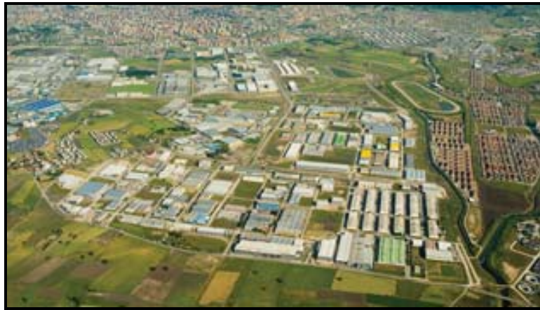
Şekil 5.7: Nilüfer OSB genel görünüm
