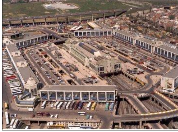
Şekil 4.12: Esenler Otogarı mekansal yapısı ve istasyon binasından görünüm
