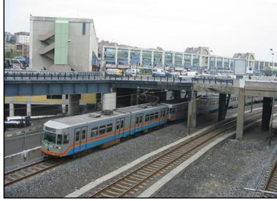
Şekil 4.6: Esenler Otogarı-hafif metro sisteminden görünüm
