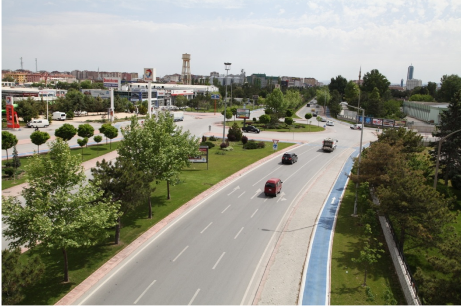
Şekil 4.24 Ankara Yolu Karayolları Kavşağı görüntüsü
