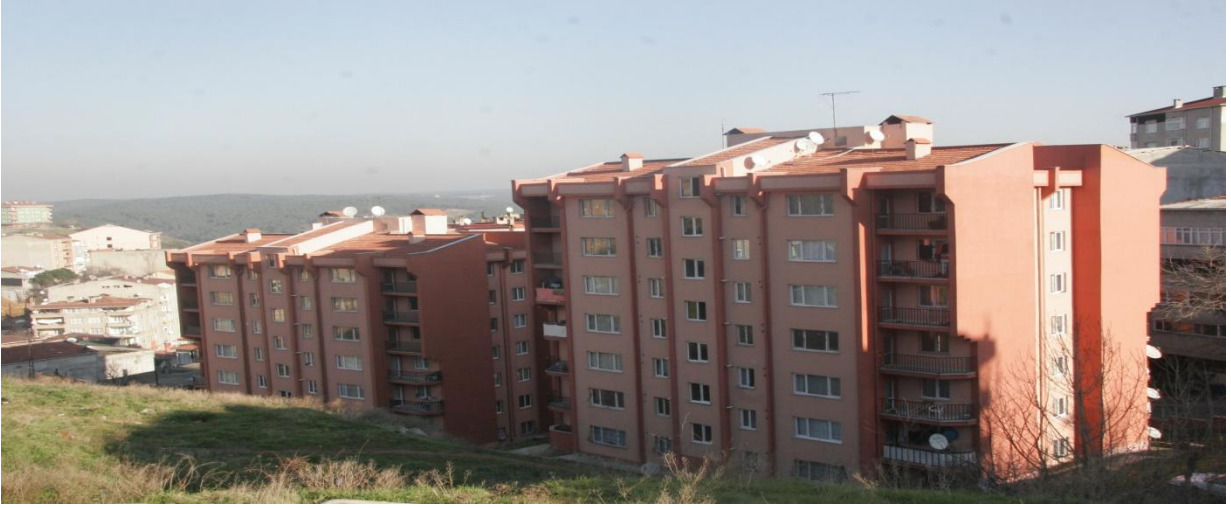
Şekil 4.12 : Tamamlanan Kağıthane İlçesi Sosyal Konut Projesi Genel Görünüm
