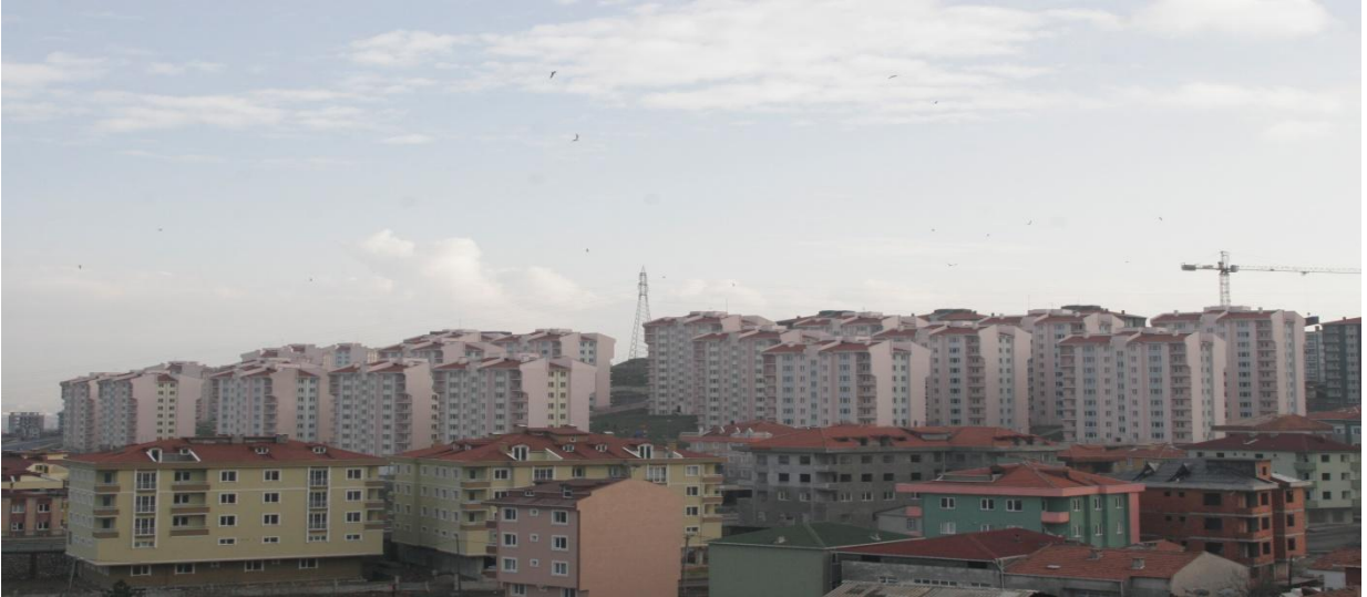
Şekil 4.11 : Tamamlanan Pendik İlçesi Sosyal Konut Projesi Genel Görünüm
