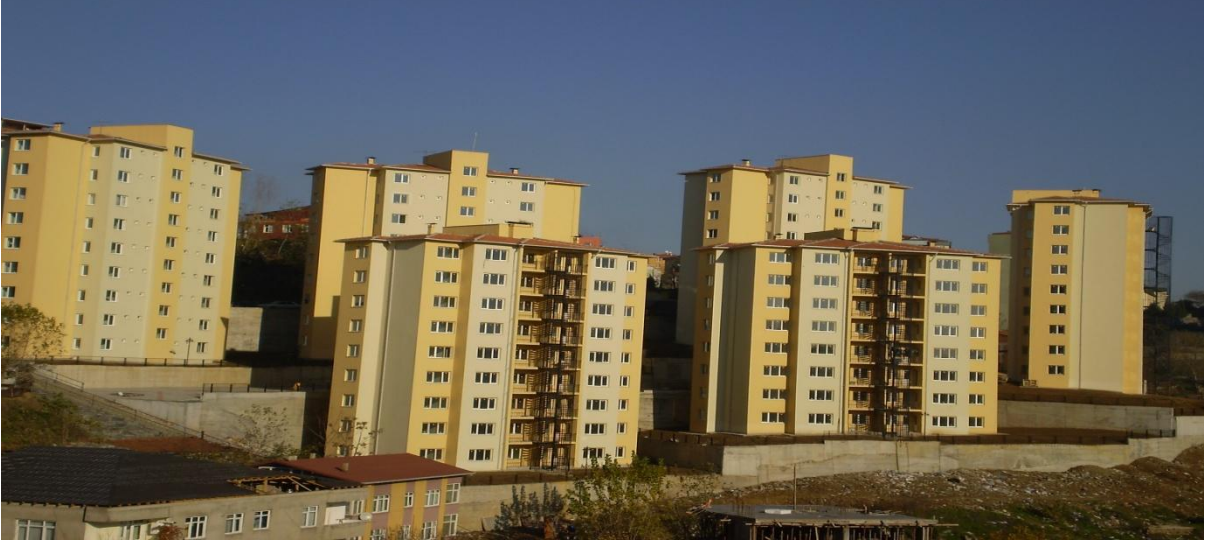
Şekil 4.10 : Tamamlanan Kağıthane İlçesi Sosyal Konut Projesi Genel Görünüm
