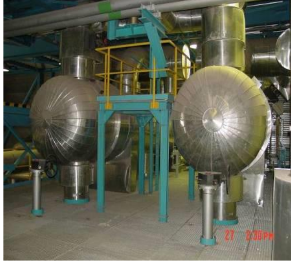
Şekil 6.6: Doğa Enerji Kojenerasyon Tesisi LT Yoğuşturucuları
