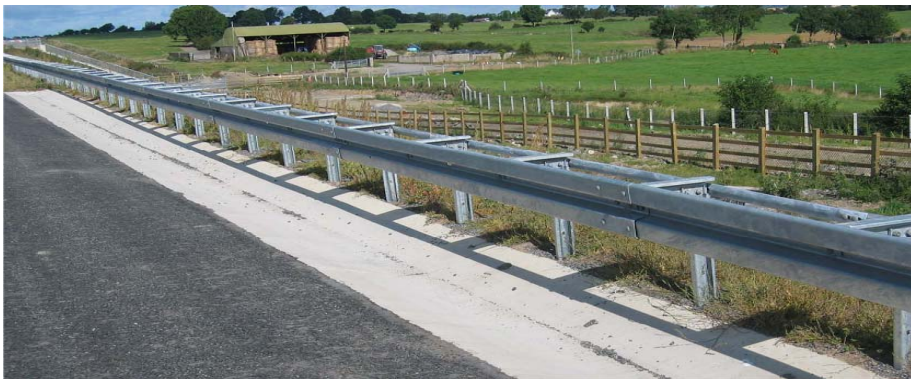
Şekil 1.1: Karayolu çelik otokorkulukları ve yapı elemanları
