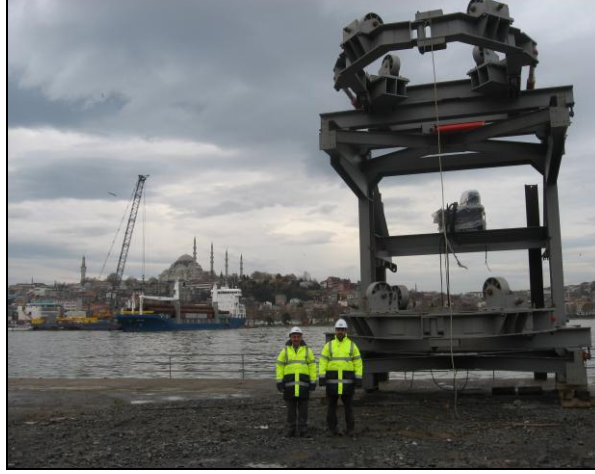
Şekil 5.48: Hidrolik Kazık Çakım Aparatı ( Gidaj-Guide Frame)
