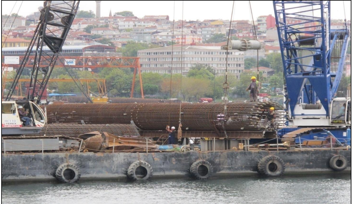
Şekil 5.55: Hazırlanan donatı kafeslerinin gemi ile kazık bölgesine taşınması.
