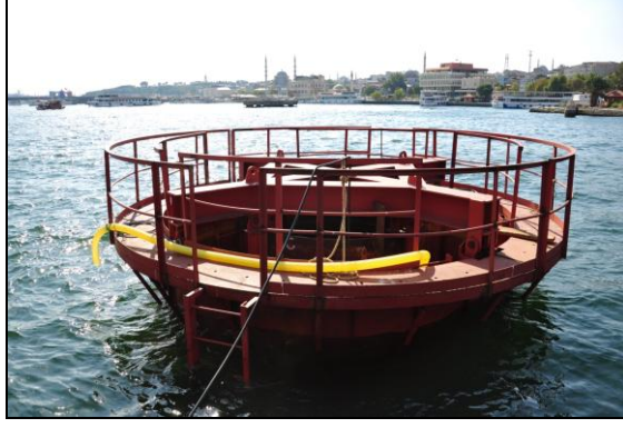
Şekil 5.57: Kuru havuz sisteminin deniz yüzeyinden görünüşü.
