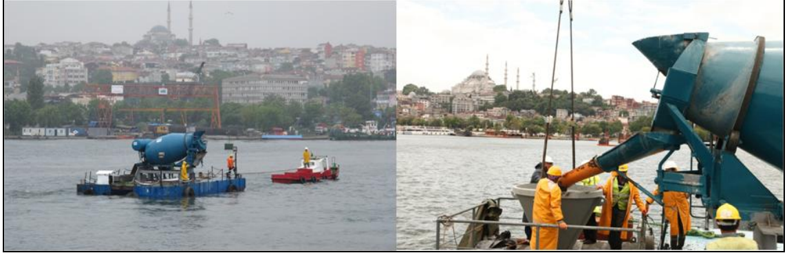
Şekil 5.56: Betonun duba üzerindeki mikser ile taşınması ve kazıklara dökülmesi.
