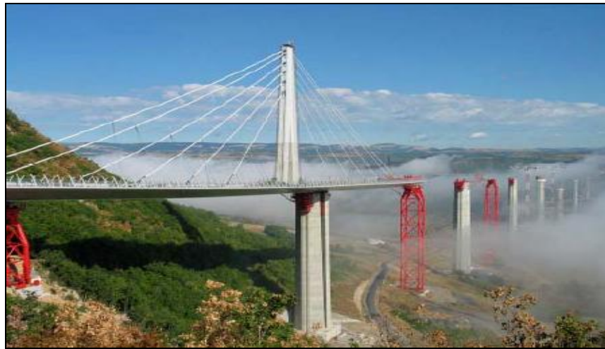
Şekil 4.15: Hazırlanan ilk pilon ve itme sürme işlemi.
