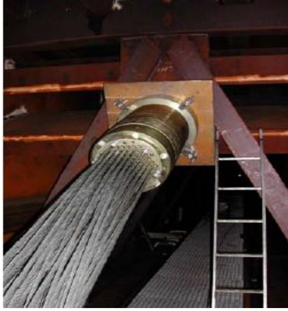
Şekil 4.14: Millau viyadüğünde kabloların genel görünüşü.
