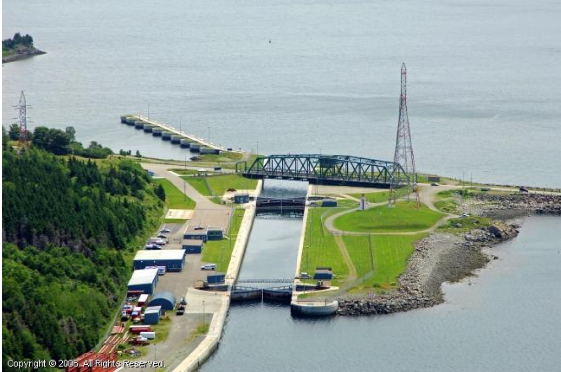
Şekil 3.4: Bir kolu dolgu zemini geçen yana açılan köprü (canso causeway yana açılan köprüsü).
