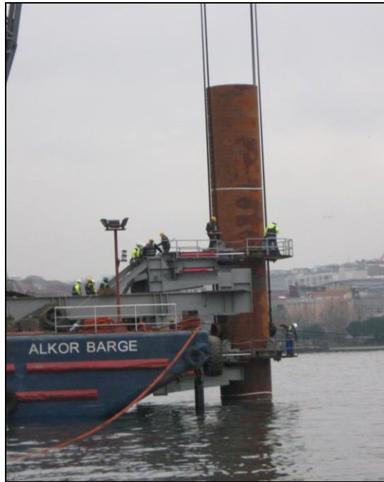
Şekil 5.49: Kazığın hidrolik kazık çakım aparatı ( gidaj-guide frame) tarafından kilitlenmesi.
