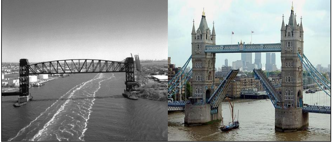
Şekil 3.1: Dikey hareketli ve baskül köprü.
