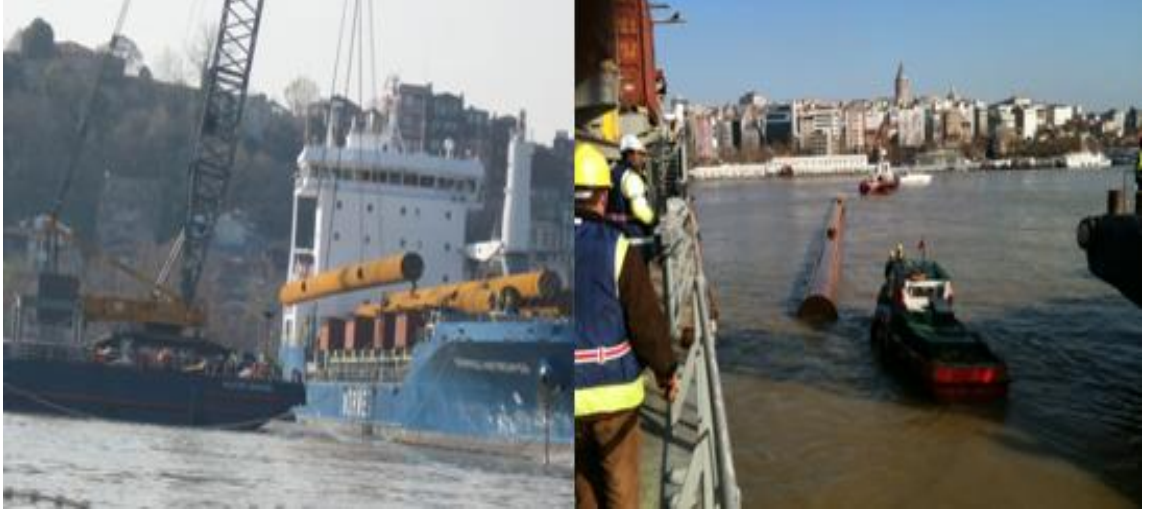
Şekil 5.45: Kazıkların gemiden indirilmesi ve geçici depolanması.
