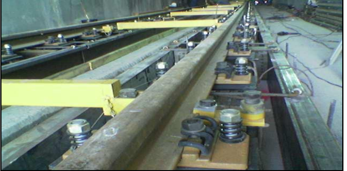
Şekil 4.10: Beton Dökümüne Hazır Hale Getirilmiş Ray Altı Kirişleri
