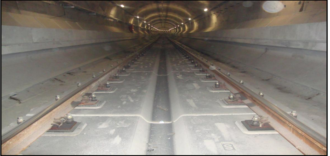
Şekil 4.30: Montajı Tamamlanmış Bir Prekast Ray Altı Panelinin Görünümü
