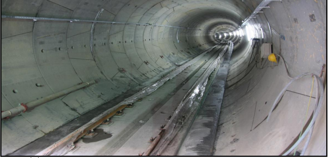
Şekil 4.29: Dolgu Betonu Prizini Almış Prekastlar
