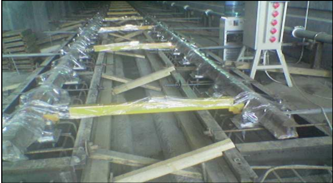
Şekil 4.12: Rayların ve Bağlantı Malzemelerinin Koruyucu Malzeme İle Sarılması
