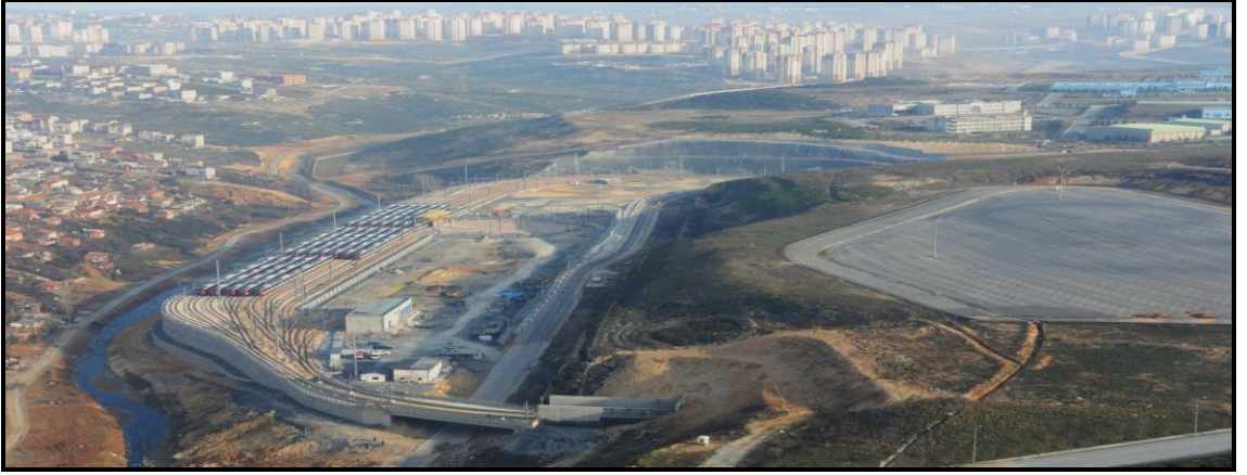
Şekil 2.7: Depo ve Atölye Sahası
