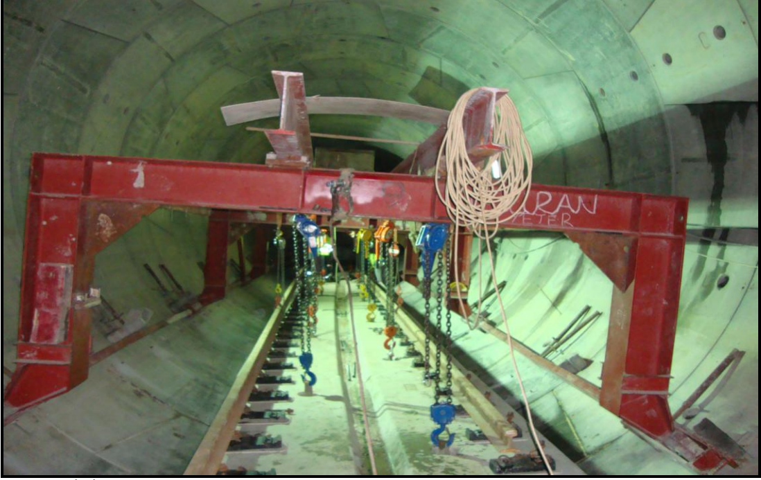
Şekil 4.20: Prefabrik Ray Altı Panellerinin Askı Aparatı İle Taşınması
