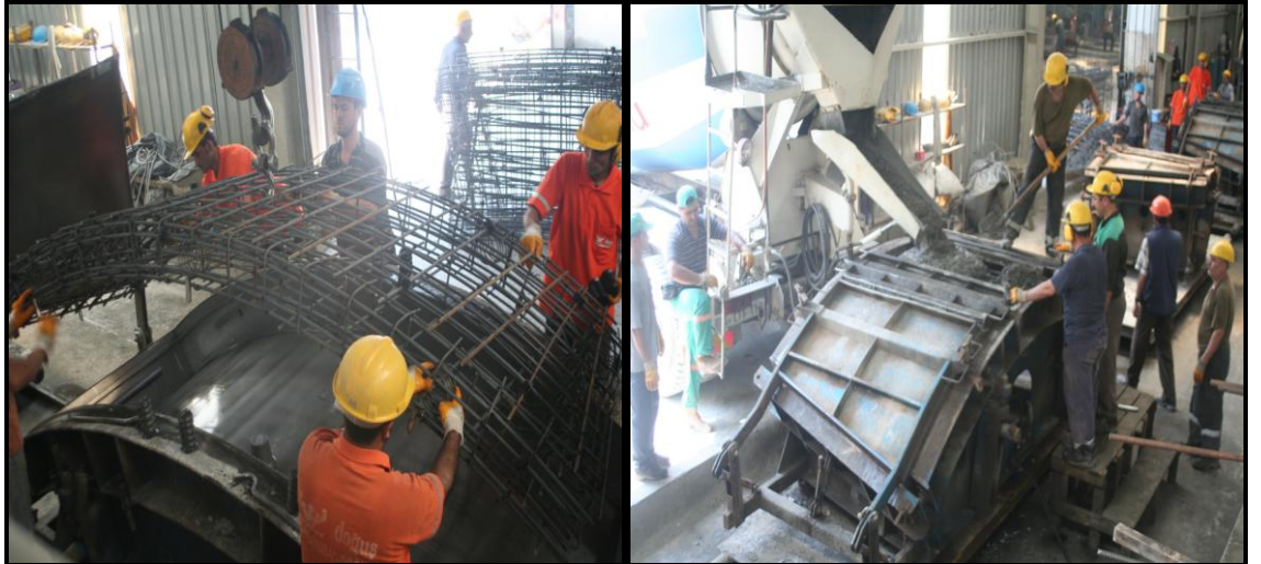
Şekil 2.11: Segment Donatılarının Özel Kalıba Konulup Betonunun Dökülmesi
