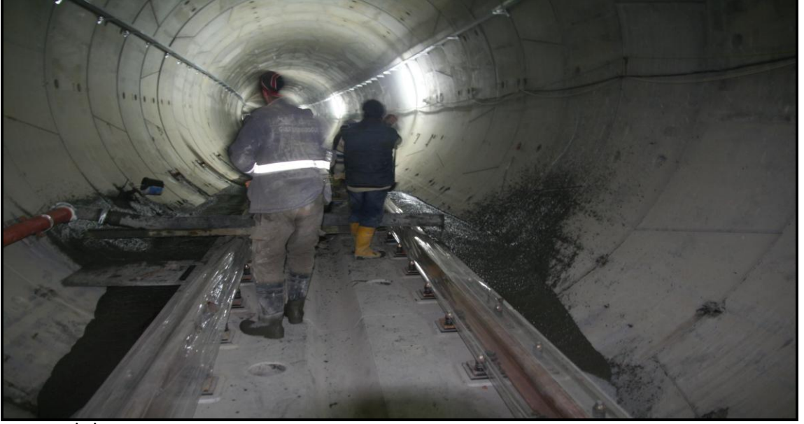
Şekil 4.27: Tünel Dışından Pompalanan Betonun Tünel İçi Borularla Getirilmesi
