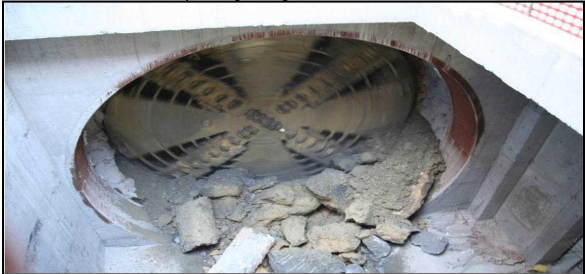
Şekil 2.13: TBM 'in İstasyon Yapısına girişi
