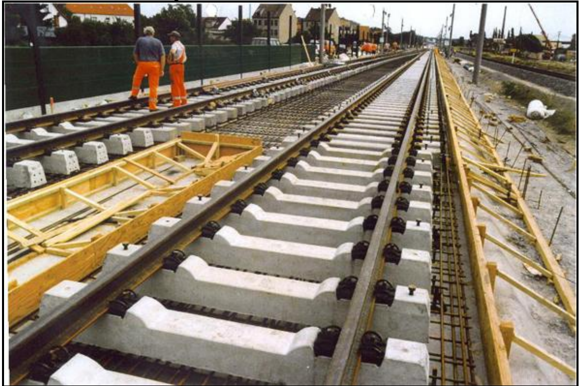
Şekil 3.18: Rheda Üst Yapı Sistemi
