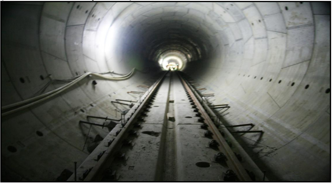
Şekil 4.21: Prekast Ray Altı Döşemelerinin Kamalarla Sabitlenmesi
