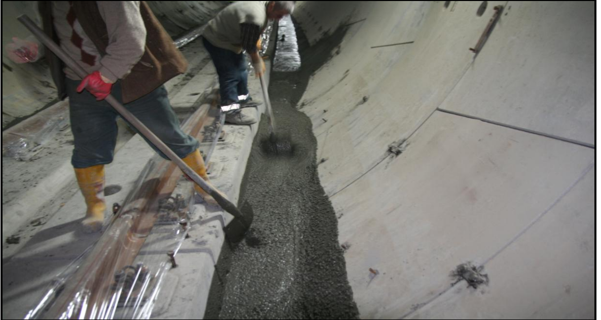
Şekil 4.28: Beton Dökümü Sırasında Ray ve Bağlantı Elemanları Folyo İle Sarılır
