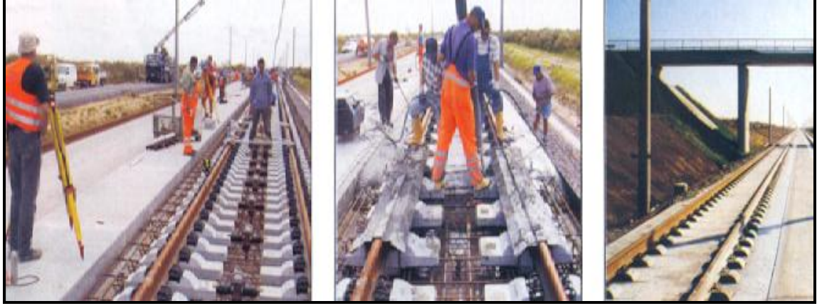
Şekil 3.17: Rheda Üst Yapı Sisteminin Döşenmesi
