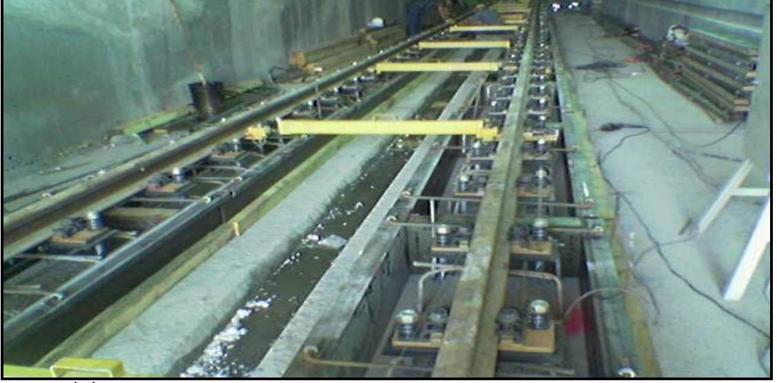
Şekil 4.9: Kalıba Alınmış Ray Altı Kirişleri
