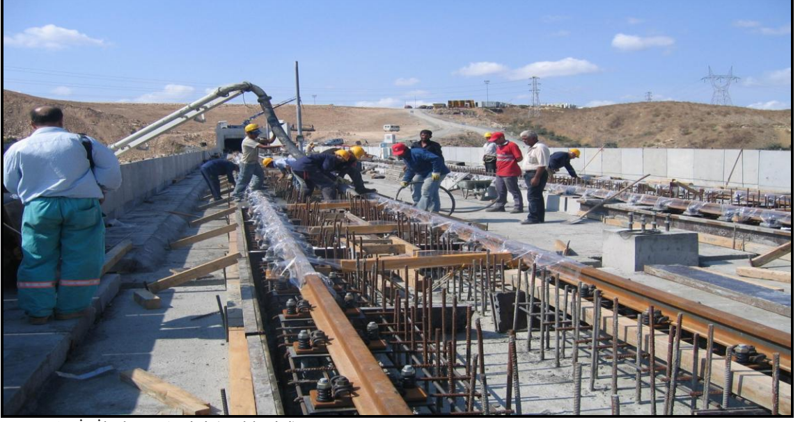
Şekil 4.13: Ray Altı Kiriş Betonunun Dökülmesi
