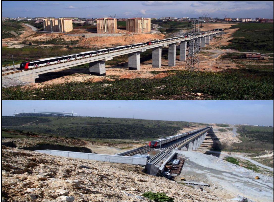
Şekil 2.14: Olimpiyat Köyü Viyadüğü
