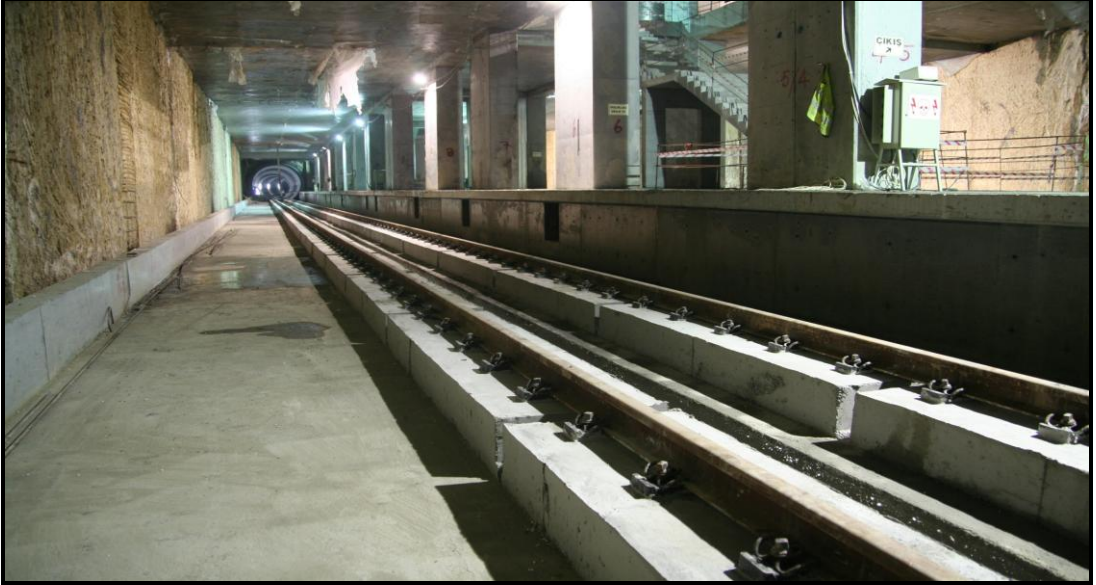
Şekil 4.14: Tespit Betonu Dökülüp Kalıbı Alınmış Ray Altı Kirişleri
