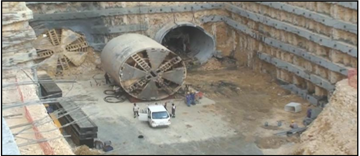
Şekil 2.9: TBM Kesici Kafanın Görünüşü
