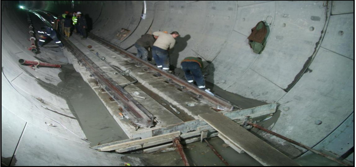
Şekil 4.26: Dolgu Betonunun Karılarak Yerleştirilmesi
