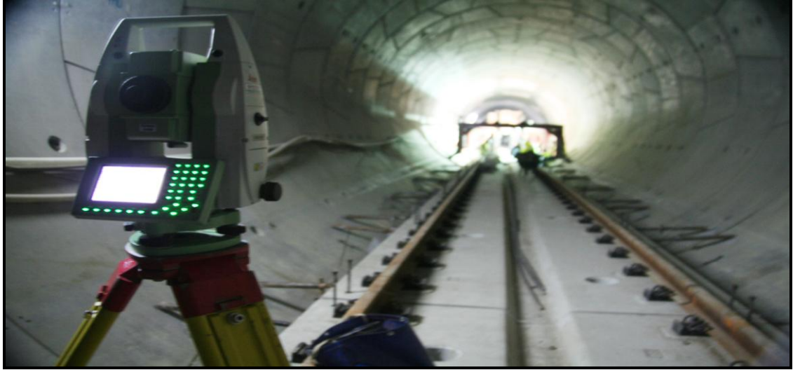
Şekil 4.22: Rayların Nihai Kotuna Getirilmesi
